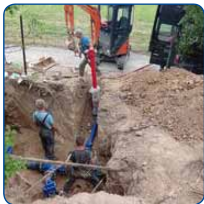
Wymiana układu zasuw w Przegini
