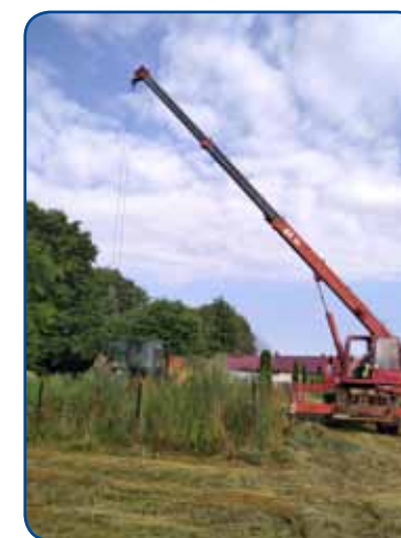
Modernizacja ujęcia wody Saspów - Poręba
