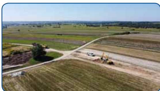
Tak powstaje droga między Przeginią a Sułoszową. zdj. Powiat Krakowski
