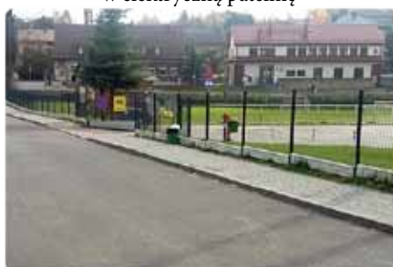
Jerzmanowice - remont ogrodzenia od strony u. Rajskiej
