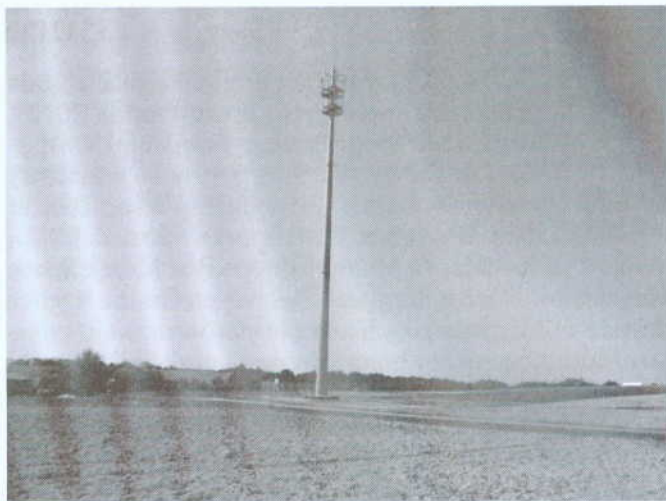
Budowa masztu telefonii komórkowej T-Mobile w Kowalowej. Inwestycja prowadzona przez T-Mobile.
