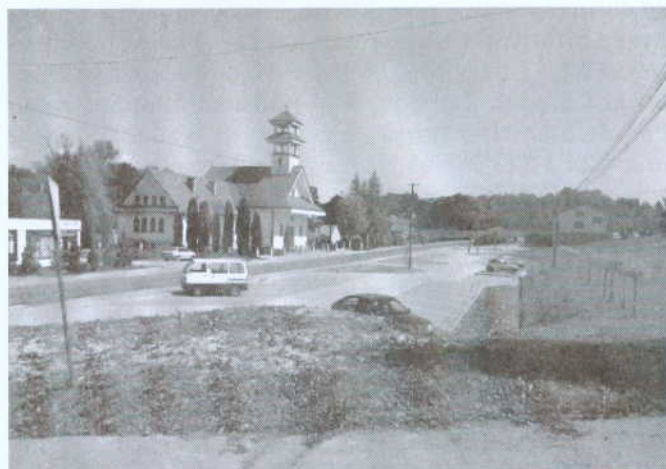
Odnowa centrum m. Joniny poprzez budowę infrastruktury drogowej i boiska sportowego. Wartość inwestycji = 522 429,89 zł
