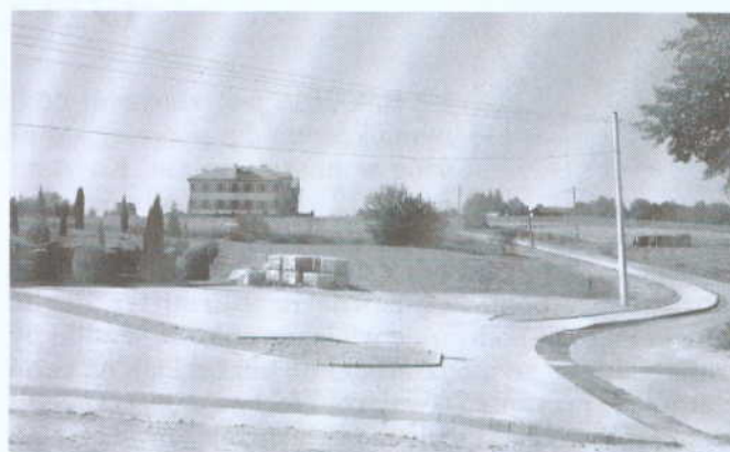
Budowa parkingu ok. 300 m 2 i chodnika 210 m wraz z odwodnieniem w m. Wola Lubecka. Wartość inwestycji = 137 770,20 zł
