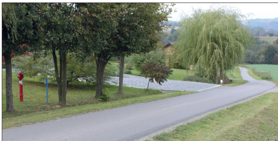
Wodociąg i nowa nawierzchnia drogi na Podlesiu w Bistuszowej
