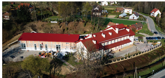
Budowa sali sportowej w Porębie Radlnej
