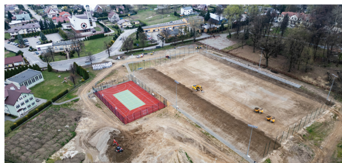
Budowa stadionu piłkarskiego w Zgłobicach
