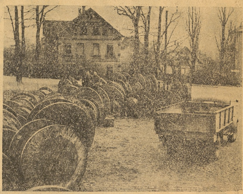
Kable elektryczne — własność Elektrowni Miejskiej w Krakowie, rewindykowane w 1945/46 z Goerlitz do Zgorzelca. Na zdjęciu — składanie kabli na rampie kolejowej w Zgorzelcu po polskiej stronie.
