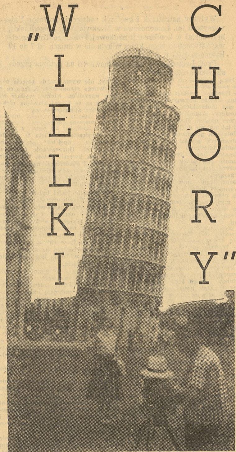
Jak bardzo krzywe są kolumny na południe chyłającej się galerii spostrzegła turysta patrząc na kopułę katedry. Północny wierzchołek wieży sięga 55,52 m, południowy 54,52 m.
