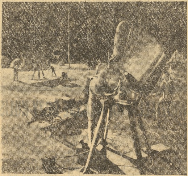
Mamy już własną energię elektryczną. Zmontowaliśmy kilka heliogeneratorów.
