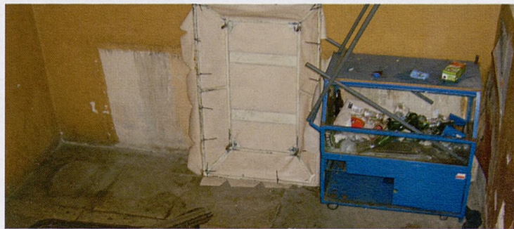
Zmianom uległo wnętrze kamienicy
