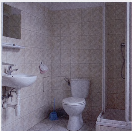
WIDOK NA ŁAZIENKĘ PO REMONCIE
