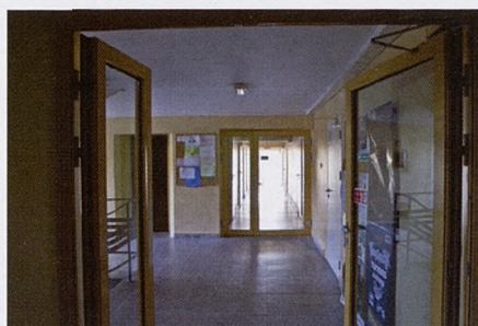
WYMIANA PRZEGRÓD PRZECIWPÓŻAROWYCH, REMONT KORYTARZY (ROK 2005). WIDOK NA DRZWI PRZECIWPÓŻAROWE ORAZ KORYTARZ.
