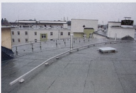
REMONT DACHU (ROK 2005). WIDOK NA DACH NAD TZW. STARYM ŻACZKIEM .
