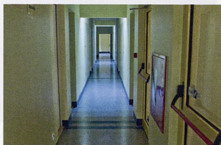
REMONT KAPITAŁNY TZW. „STAREGO ŻACZKA” (LATA 2006–2010). WIDOK NA KORYTARZ PO REMONCIE.
