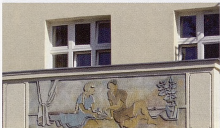
WIDOK NA ELEWACJĘ PO REMONCIE I NOWE OKNA
