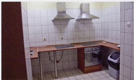
WIDOK NA KUCHNIĘ PO REMONCIE
