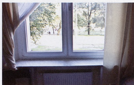
WYMIANA OKIEN – BLOK A, B, C (ROK 2009). WIDOK NA NOWE OKNO.
