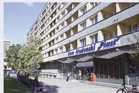
REMONT ELEWACJI ORAZ WYMIANA OKIEN (LATA 2002–2004). WIDOK NA ELEWACJĘ I NOWE OKNA.
