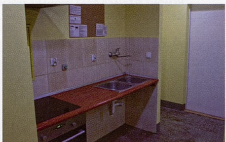
REMONT KAPITAŁNY BLOKU D (LATA 2007–2008). WIDOK NA KUCHNIĘ PO REMONCIE.
