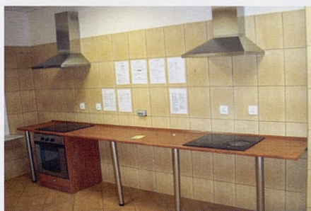
REMONT KAPITAŁNY TZW. „STAREGO ŻACZKA” (LATA 2006–2010). WIDOK NA KUCHNIĘ PO REMONCIE .
