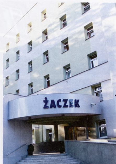
REMONT ELEWACJI ORAZ WYMIANA OKIEN (ROK 2005). WIDOK NA ELEWACJĘ I NOWE OKNA .
