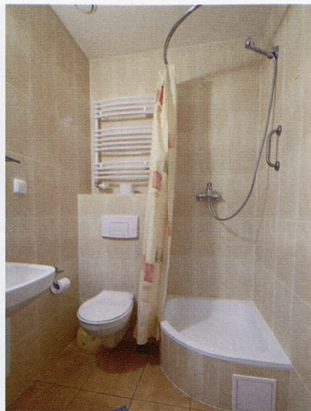
REMONT KAPITAŁNY BLOKU D (LATA 2007–2008). WIDOK NA ŁAZIENKĘ PO REMONCIE.
