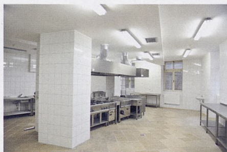
REMONT STOŁÓWKI STUDENCKIEJ (ROK 2010). WIDOK NA POMIESZCZENIA KUCHNI PO REMONCIE.
