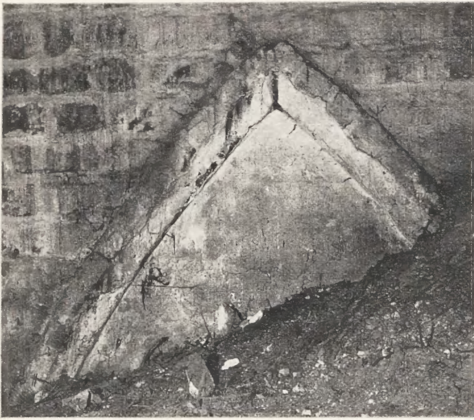
8. Niepołomice, kościół parafialny, ślad pierwotnego sklepienia z w. XIV nad dzisiejszym sklepieniem nawy. Fot. K. Estreicher.
