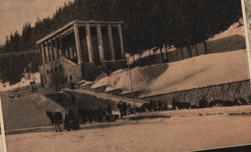
Dworzec Kolejki linowej w Kuźnicach.
