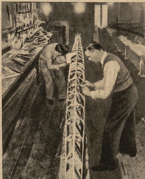
Fragment budowy skifa w warsztatach Phelps'a w Putney pod Londynem.
