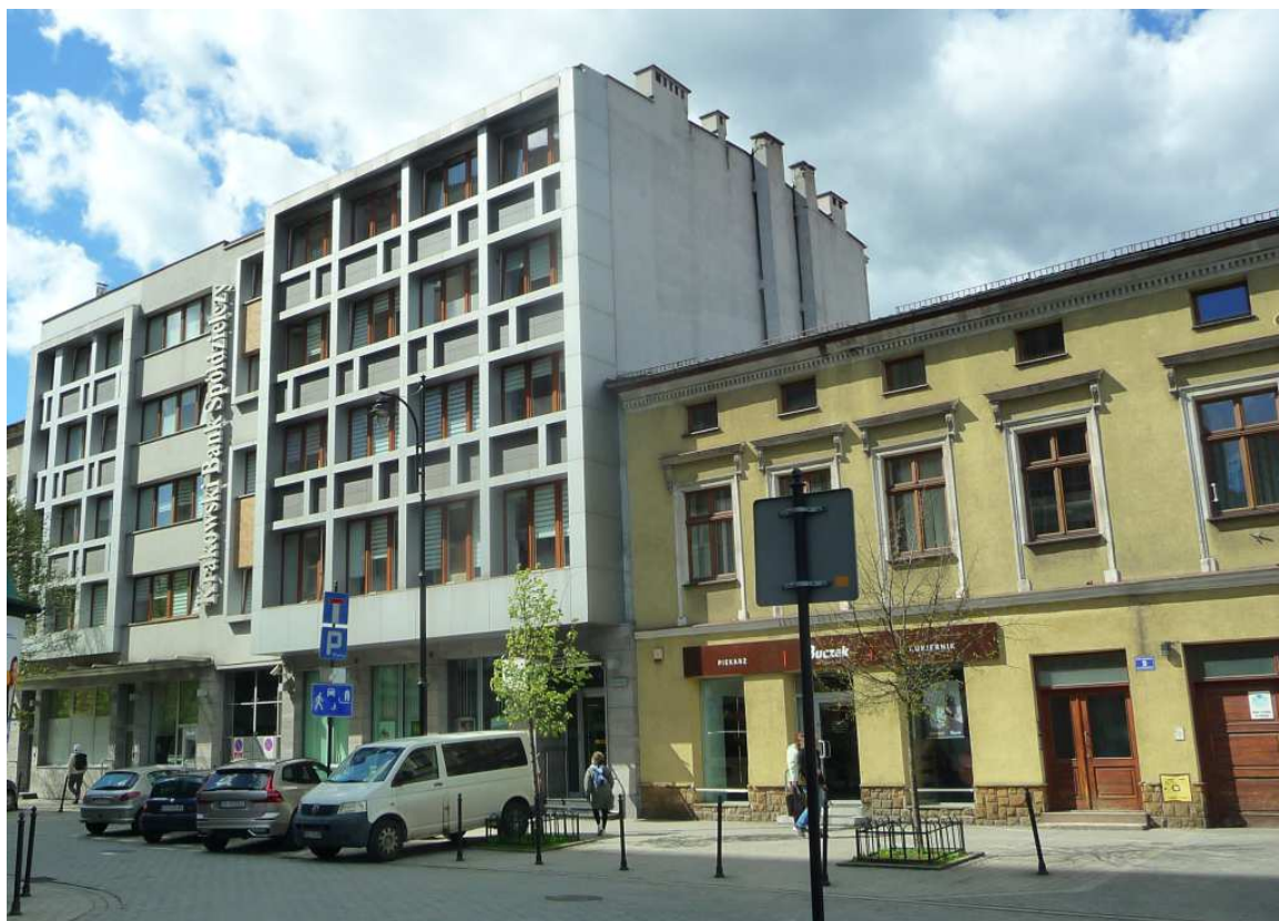
Fot. nr 199. Fragment zabudowy Rynku Kleparskiego, z nowymi budynkami pod nr: 7 i 8. Z prawej niski dom pod nr 9, wybudowany ok. roku 1880. (03.04.2024)
