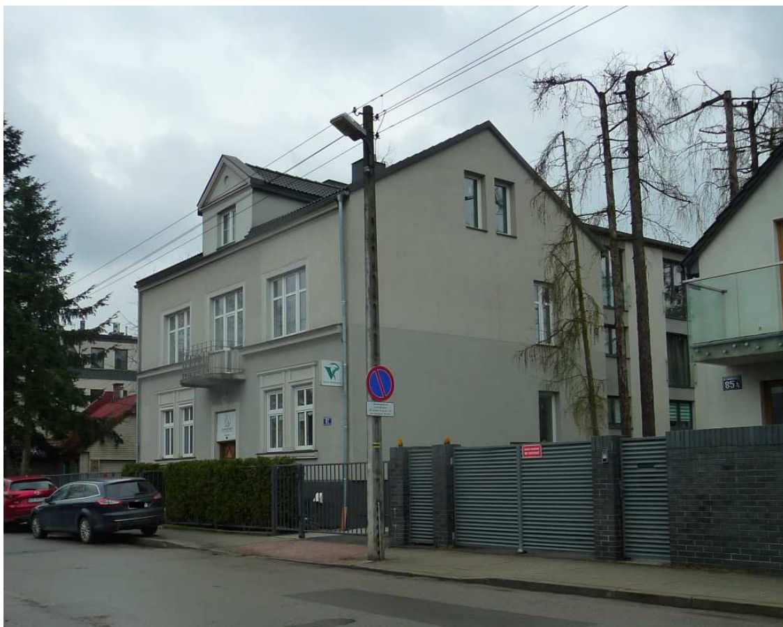
Fot. nr 286. Nieco już przebudowany dom z początku XX wieku pod nr 87. (13.03.2024)
