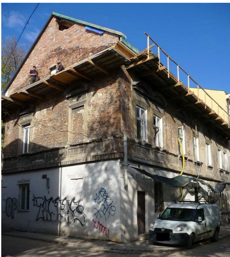
Fot. nr 113. Dom pod nr 1, róg z ulicą Murowaną 6, powstały ok. roku 1890. (26.10.2024)
