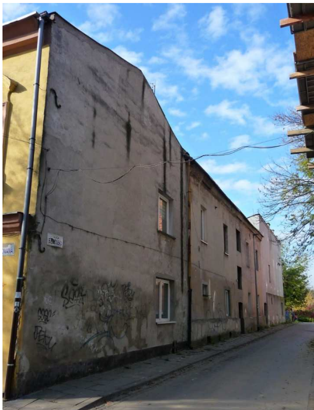
Fot. nr 110 (110-113). Wzdłuż ulicy Będzińskiej. Pierzeja o parzystych numerach. (26.10.2024)
