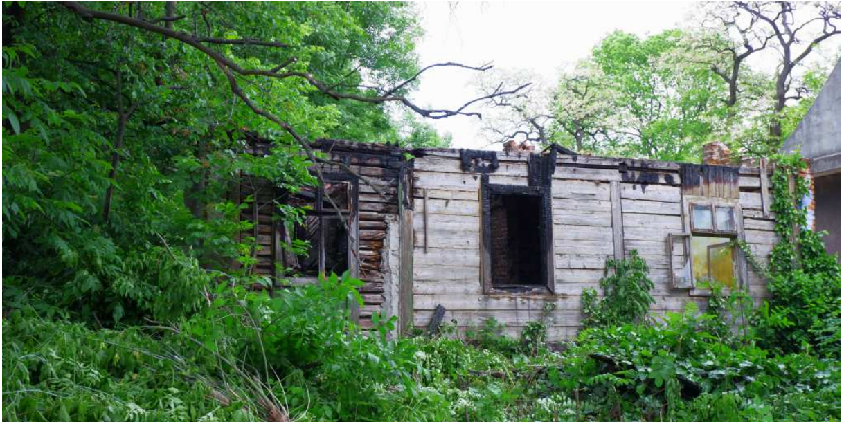
Fot. nr 237. Ruina dawnej chałupy pod nr 2. (17.05.2024)
