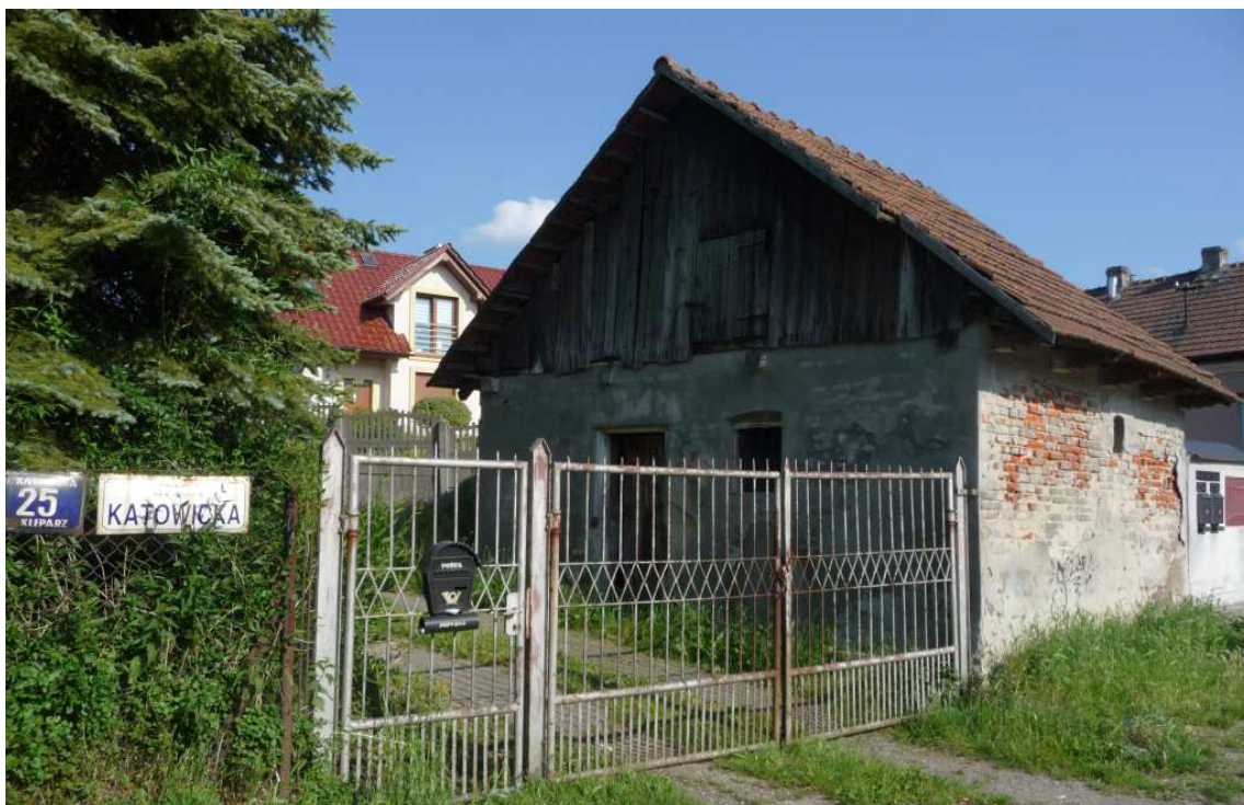
Fot. nr 143. Po starej zagrodzie Wojciecha Susuła i chałupie, wybudowanej w roku 1864, usytuowanej przy ulicy Katowickiej 25, została tylko stajnia. (08.06.2024)
