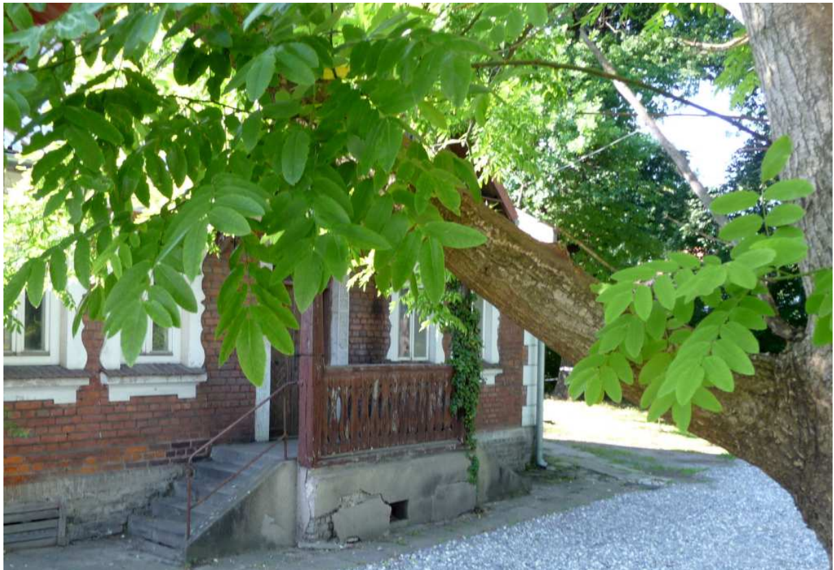
Fot. nr 158 (158-159). Fasada obiektu z odkrytym gankiem pośrodku. (08.06.2024)
