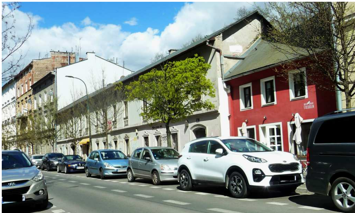
Fot. nr 20. Fragment zabudowy ulicy Łobzowskiej numerach 17-25. Dom pod nr 17 powstał na początku XX wieku, zaś bliźniak pod nr: 19-21 w roku 1868, wg projektu T. Zamojskiego. Pozostałe kamienice zbudowano pod koniec XIX wieku. (03.04.2024)
