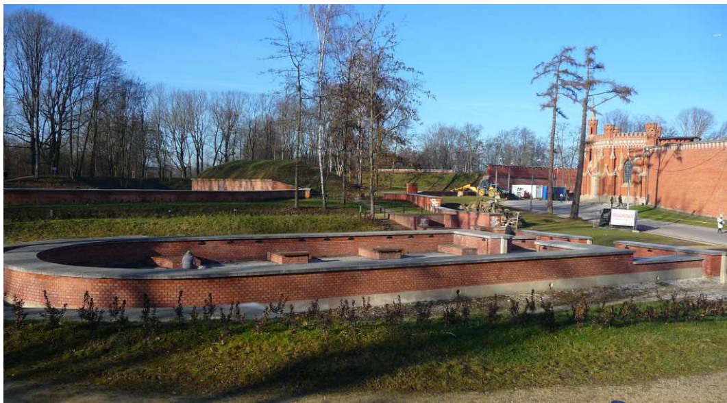
Fot. nr 50 (50-52). Zrekonstruowane przyziemie schronu głównego bastionu nr I. (26.12.2024)
