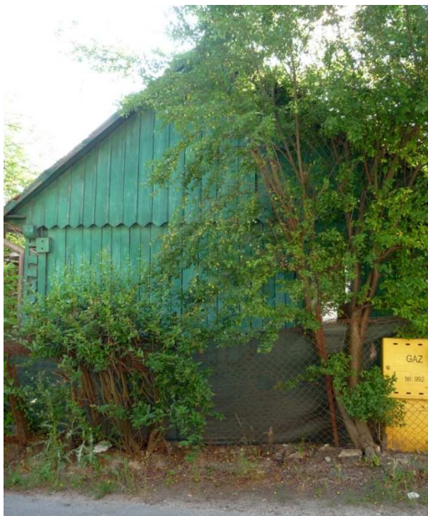
Fot. nr 139. Wzdłuż ulicy Zielony Most. Ściana szczytowa chałupy pod nr 5. (08.06.2024)
