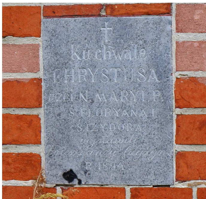
Fot. nr 231. Inskrypcja w cokole lica.
