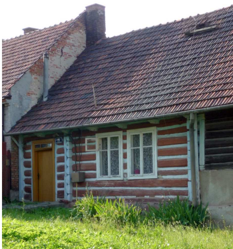
Fot. nr 172. Zachowany prawy fragment dwutraktowej chałupy. Lewa, symetryczna względem sieni część została przebudowana na dom murowany. (08.06.2024)
