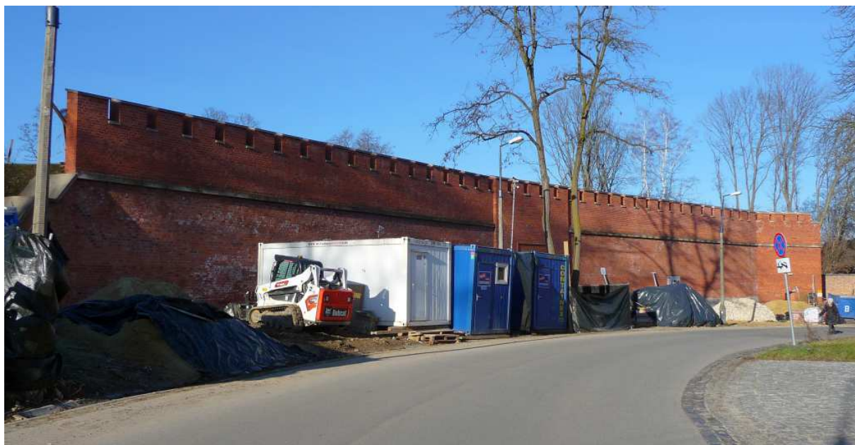
Fot. nr 66. Częściowo zrekonstruowana ściana wewnętrzna (kurtyna II-III) pomiędzy bastionami II i III. (26.12.2024)
