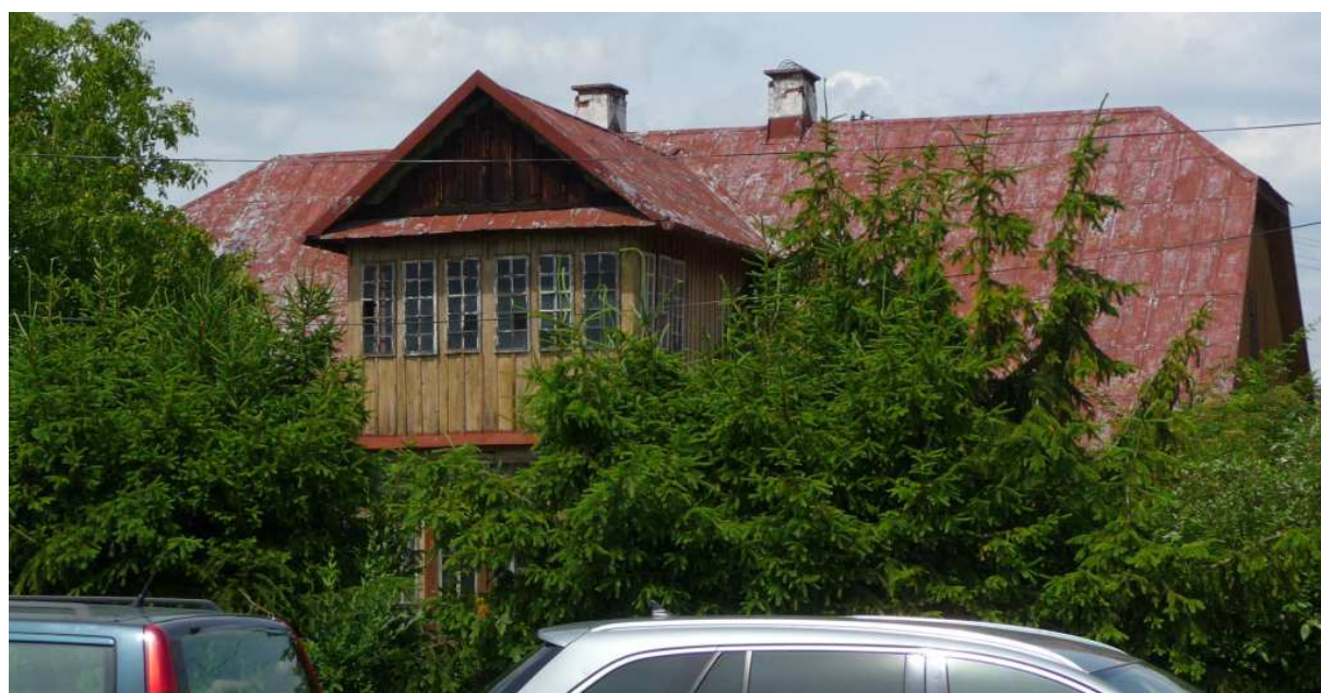
Fot. nr 425. Fasada domu. (14.06.2024)
