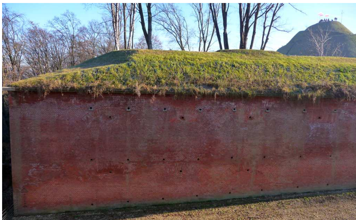
Fot. nr 65. Mur oporowy bastionu nr III. (26.12.2024)
