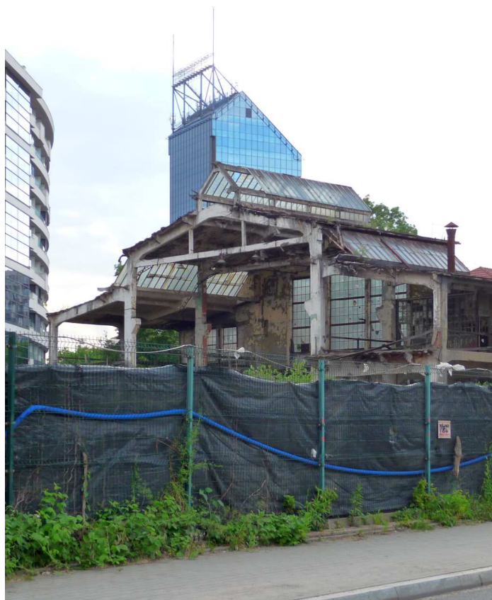
Fot. nr 223. Jedyne pozostałości po hali fabrycznej fabryki Zieleniewskiego przy ulicy Grzegórzeckiej 69. (23.05.2024)
