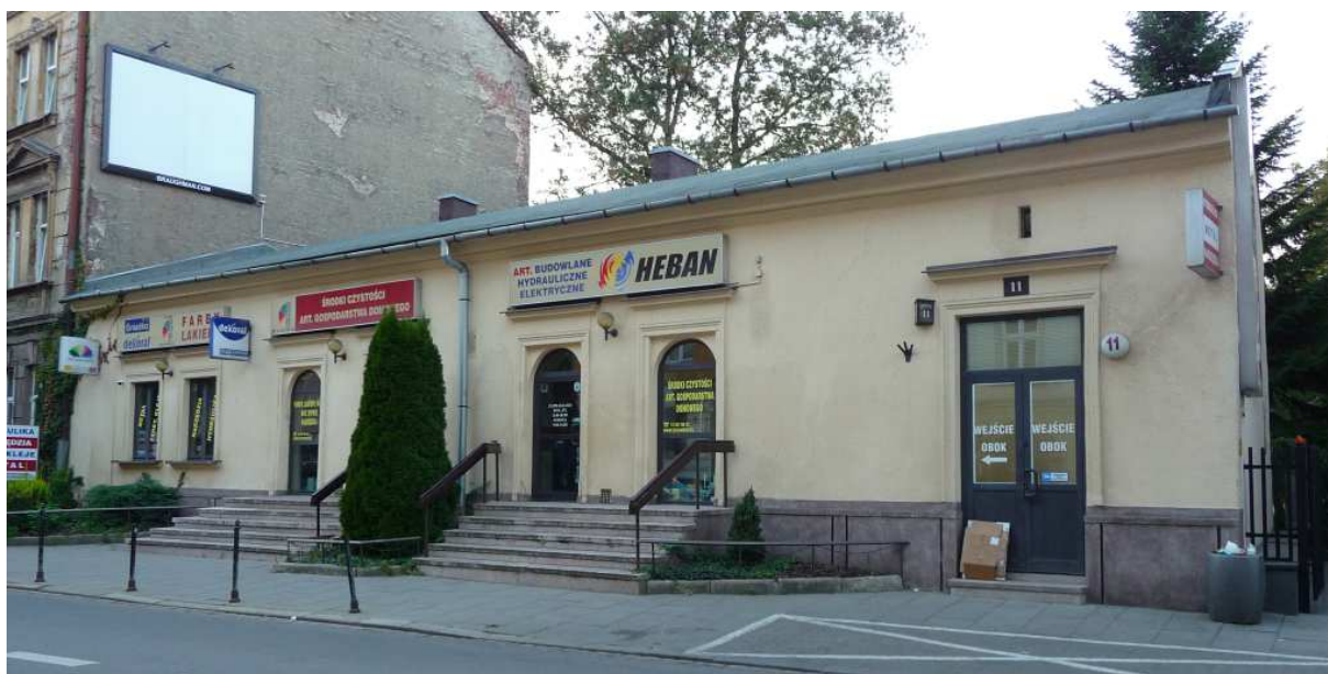
Fot. nr 21. Wybudowany w roku 1880 dom przy ulicy Garbarskiej 11. W roku 1912 został przebudowany na kinematograf, a po roku 1945 został zaadaptowany na biura. (07.09.2024)
