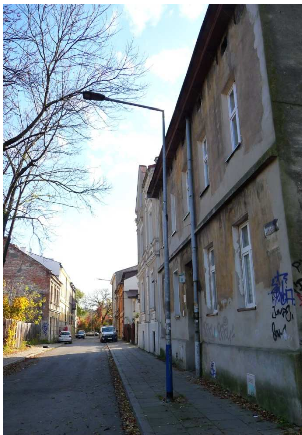
Fot. nr 123. Widok na ulicę od domu pod nr 2. (26.10.2024)
