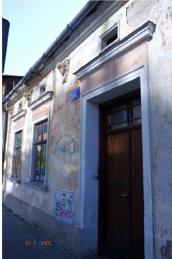
Fot. nr 256. Wybudowany w roku 1912 murowany dom z roku 1912 pod nr 13.
