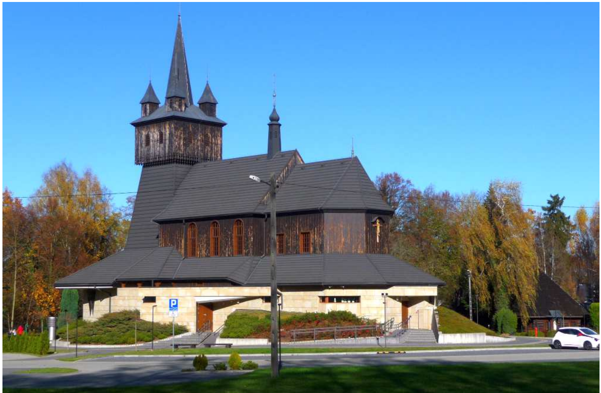
Fot. nr 190. Wybudowana w latach 2016-2020, w miejscu dwóch spalonych (w latach: 1978 i 2002) drewnianych kościołów, świątynia parafii p.w. NMP Królowej Polski, która w założeniu miała imitować dawny oryginał. Czy to się jednak udało??? (01.11.2024)
