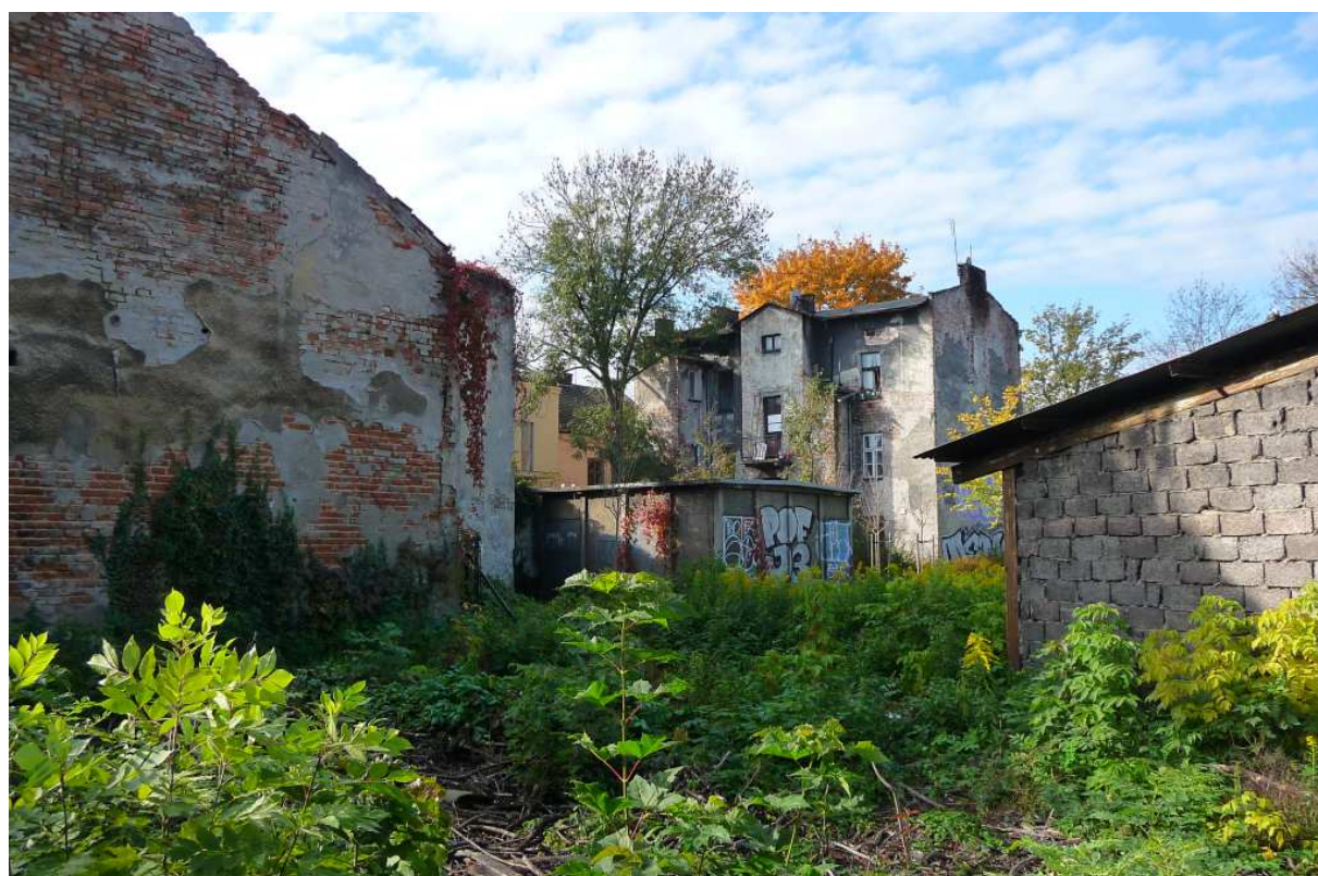
Fot. nr 127. Widok z ulicy Murowanej na tyły ulicy Towarowej. (26.10.2024)
