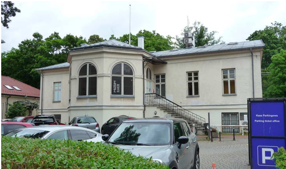
Fot. nr 33. Widok na klasycystyczny dwór od strony dziedzińca. (02.06.2024)
