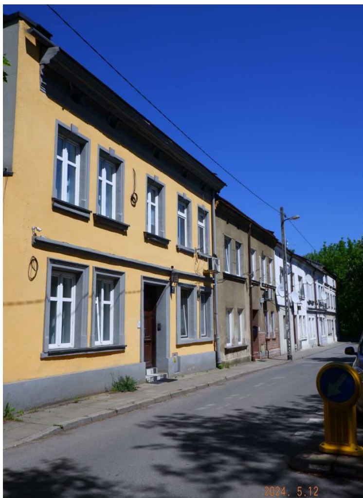
Fot. nr 301. Fragment zabudowy ulicy poniżej nr 19.
