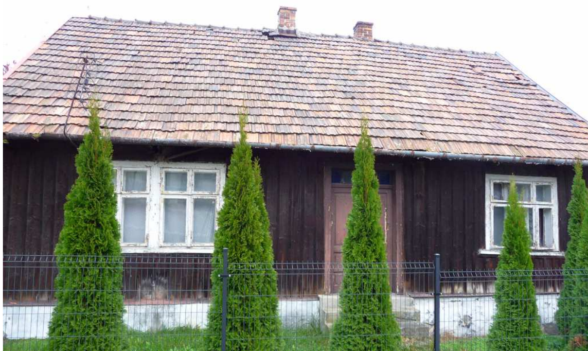
Fot. nr 346. Ciągłe oryginalne okna typu skrzynkowego. (10.11.2024)
