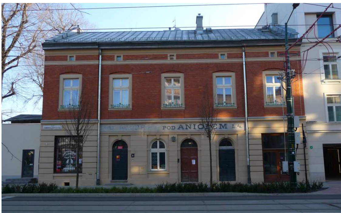
Fot. nr 38 (38-50). Wzdłuż ulicy Kościuszki. Dom pod nr 18, wybudowany w I. połowie XIX wieku, przebudowany w roku 1890. (26.12.2024)
