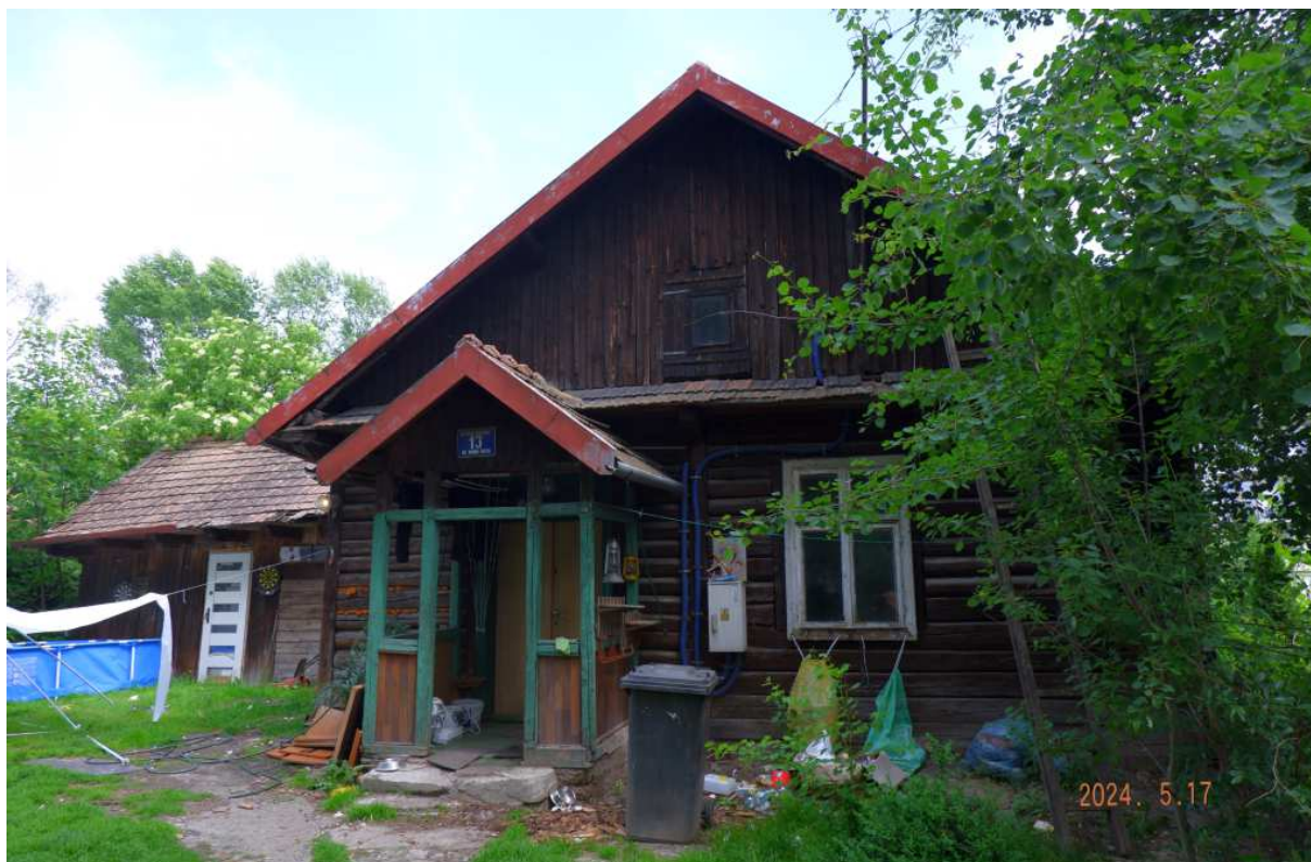
Fot. nr 242. Ściana boczna z odkrytym gankiem.
