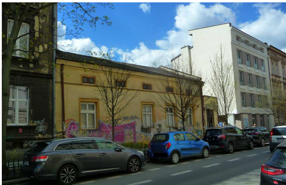
Fot. nr 17 (17-18). Powstały w roku 1867 budynek dawnej ochronki prowadzonej przez Siostry Miłosierdzia, zwane Szarytkami, przy ulicy Krowoderskiej 38 na etapie remontu. Czy ten relikw parterowej zabudowy Piasku zachowa swój dawny wygląd? (03.04.2024)
