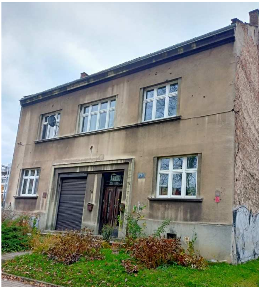
Fot. nr 281. Międzywojenna kamieniczka z ulicy Bocznej 7. (14.11.2024)
