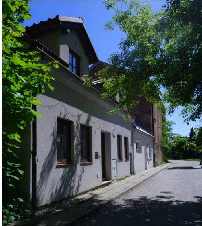
Fot. nr 310. Zabudowa ulicy powyżej nr 12. (12.05.2024)
