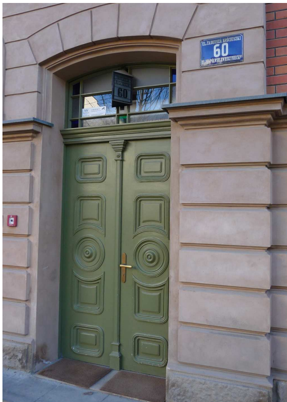
Fot. nr 48. Drzwi domu pod nr 60. (26.12.2024)
