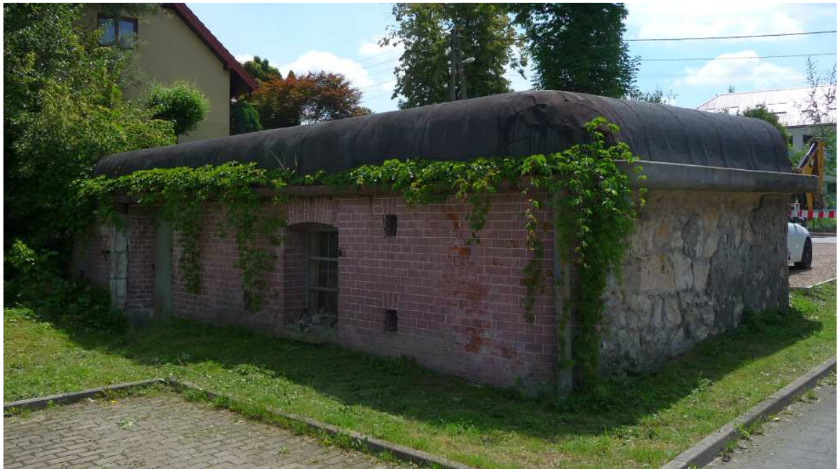
Fot. nr 410 (410-412). Schron amunicyjne Swoszowice z lat 1913-14 pod nr 106. (14.06.2024)
