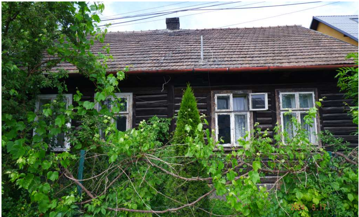
Fot. nr 244. Fasada domu z oryginalnymi oknami typu skrzynkowego.
