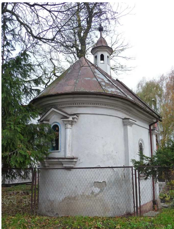
Fot. nr 283. Widok na absydę. (07.11.2024)
