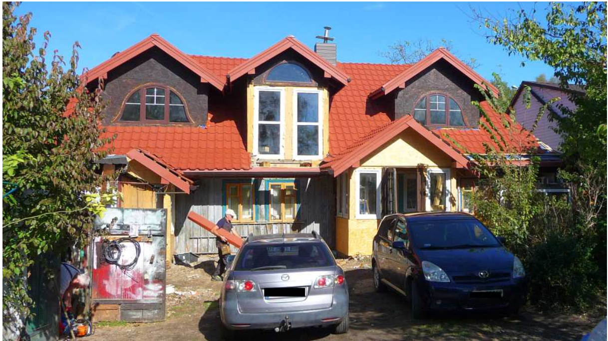
Fot. nr 381. Zapewne blisko 100-letni dom z ulicy Zbrojarzy 55 na etapie przebudowy. (08.10.2024)
