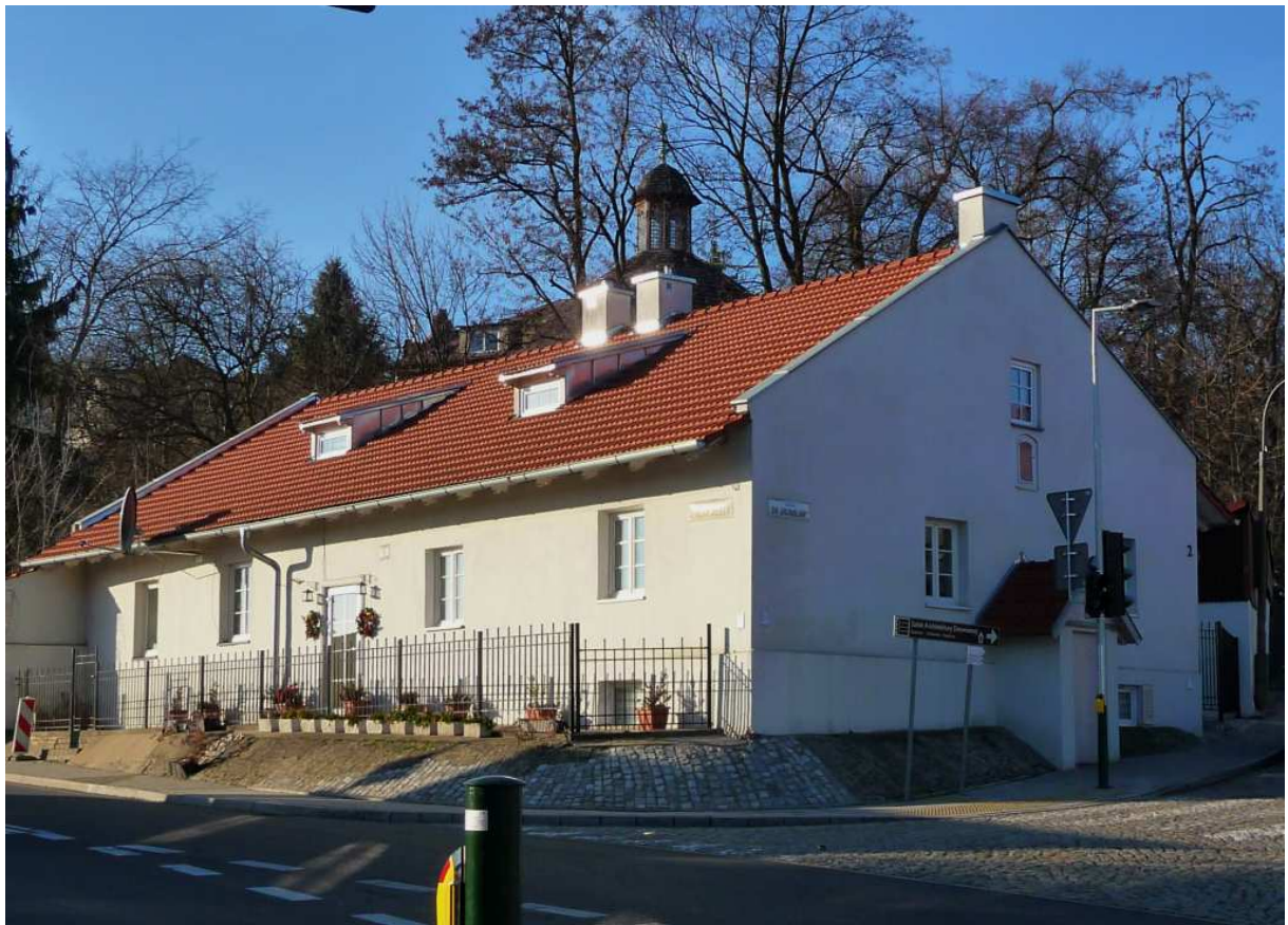
Fot. nr 53. Dawna karczma pod nr 2, wybudowana w okolicy połowy XIX wieku. (26.12.2024)
