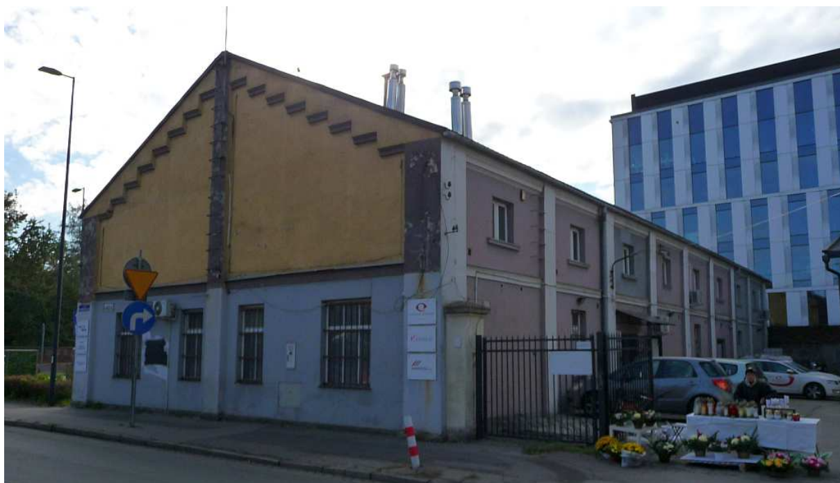
Fot. nr 134. 100-letni budynek dawnego magazynu pod nr 45, róg z aleją 29-Listopada. (26.10.2024)
