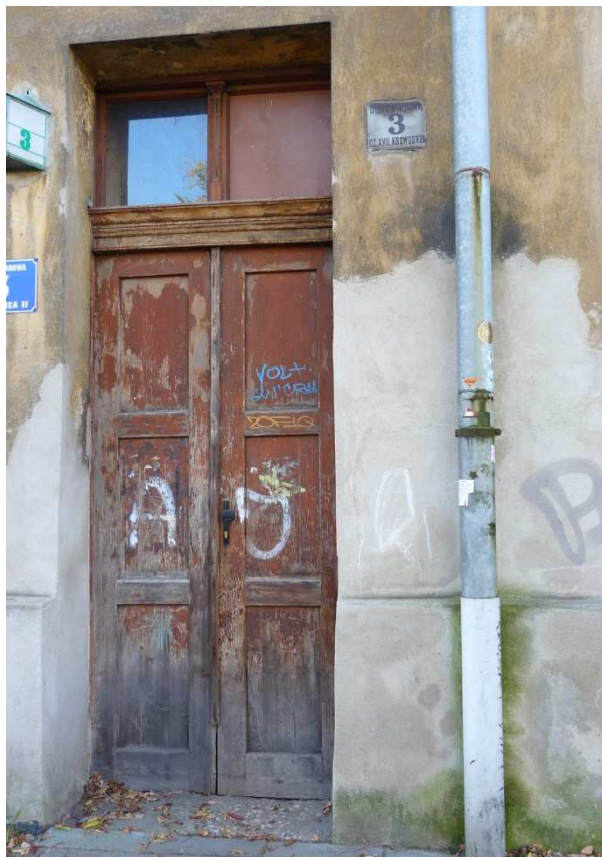
Fot. nr 122. Drzwi domu pod nr 3. (26.10.2024)
