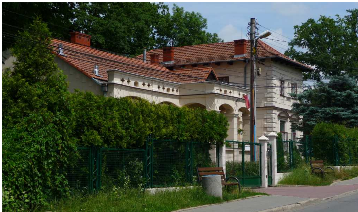
Fot. nr 416 (416-418). Fasada obiektu. (14.06.2024)
