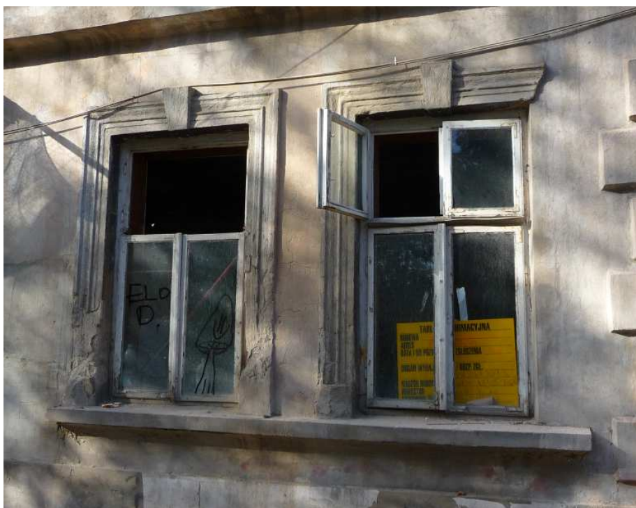
Fot. nr 115. Oryginalne okna na etapie przebudowy. (26.10.2024)
