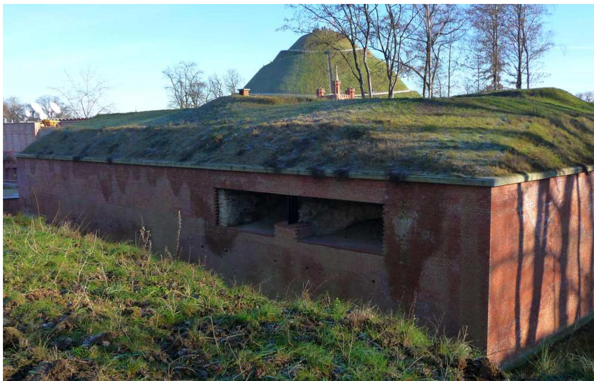
Fot. nr 61. Detale schronu głównego. (26.12.2024)
