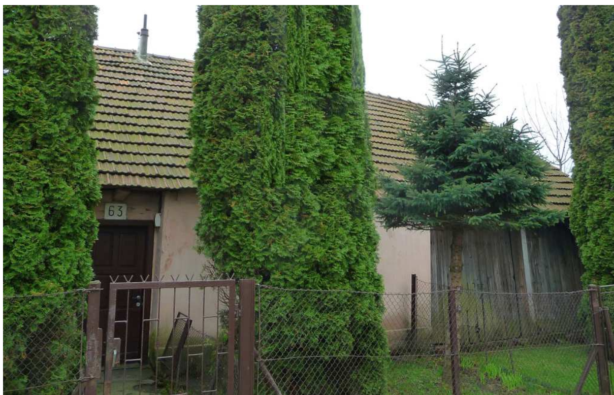
Fot. nr 331 (331-332). Dawna chałupa ze stodołą we wspólnym korpusie pod nr 63, której większość fasady znikła pod tynkiem. (02.03.2024)
