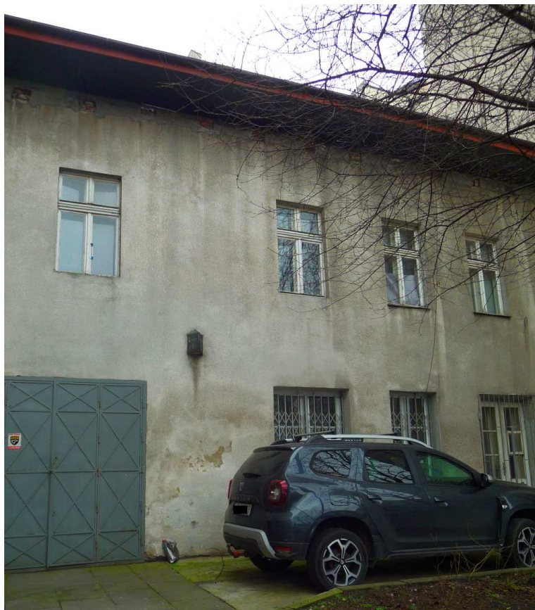
Fot. nr 197. Cofnięty w stosunku do ulicy dom z ostatniej ćwierci XIX wieku z Rynku Kleparskiego 1. (01.03.2024)
