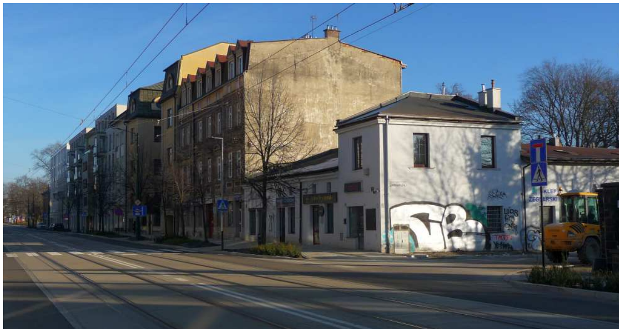
Fot. nr 40. Fragment zabudowy poniżej ulicy Jaskółczej i niskiego domu o numerze 28, powstałego na przełomie XIX i XX wieku. (26.12.2024)
