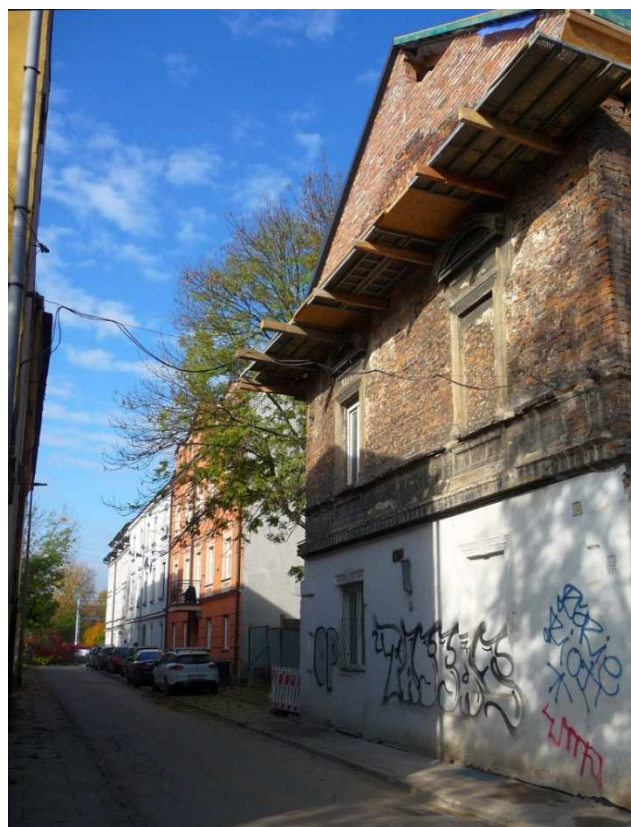
Fot. nr 111 (111-113). Pierzeja o nieparzystych numerach. Zabudowa w większości z końca XIX wieku. Widok z ulicy Murowanej. (26.10.2024)
