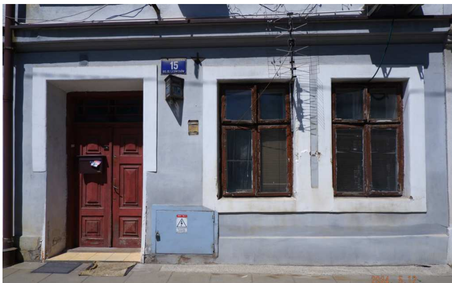
Fot. nr 300. Oryginalne detale domu pod nr 15 z ok. roku 1910-15.
