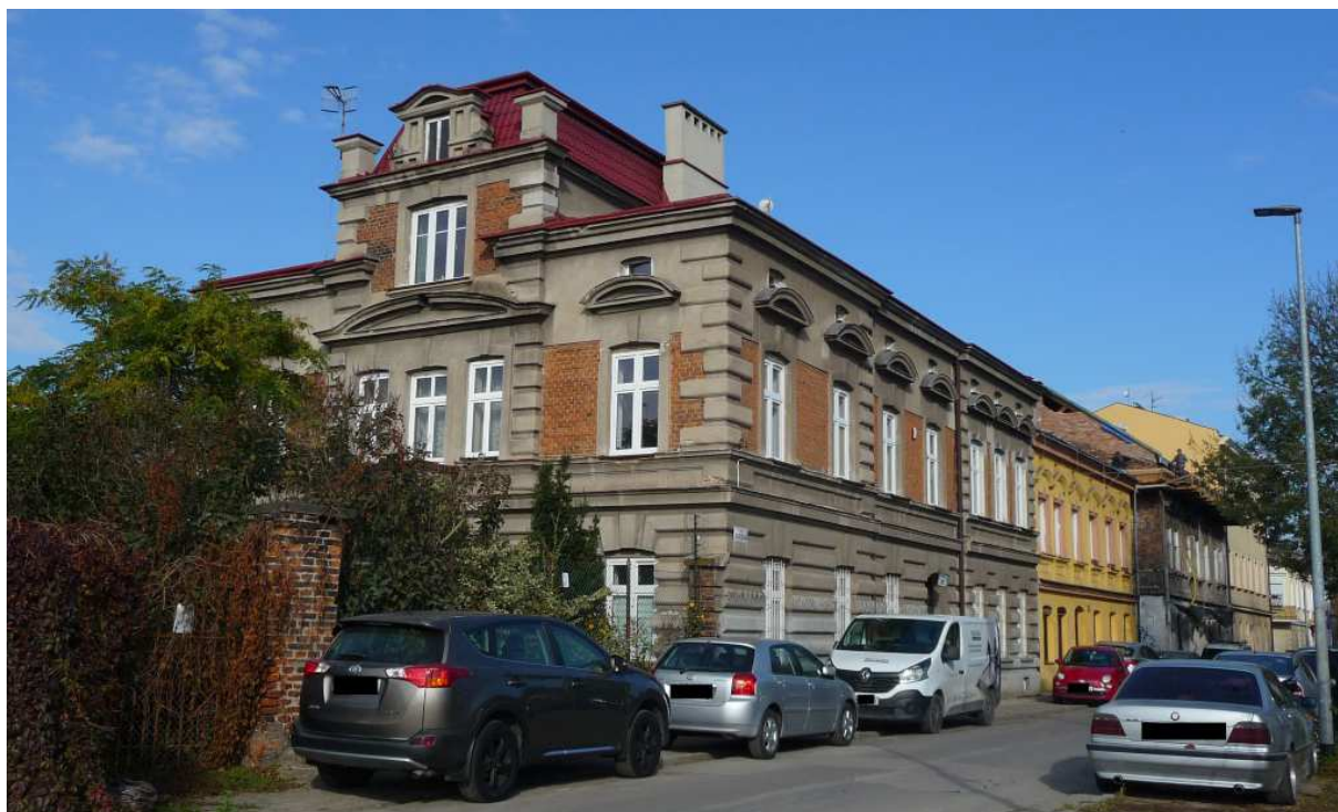
Fot. nr 106 (106-109). Wzdłuż ulicy Murowanej. Osada, zwana Krowodrzą Murowaną, powstała po roku 1890 na potrzeby rozwijającego się w sąsiedztwie węzła kolejowego. Fot. nr: 106-108. Kamienica z końca XIX wieku pod nr 2. (26.10.2024)
