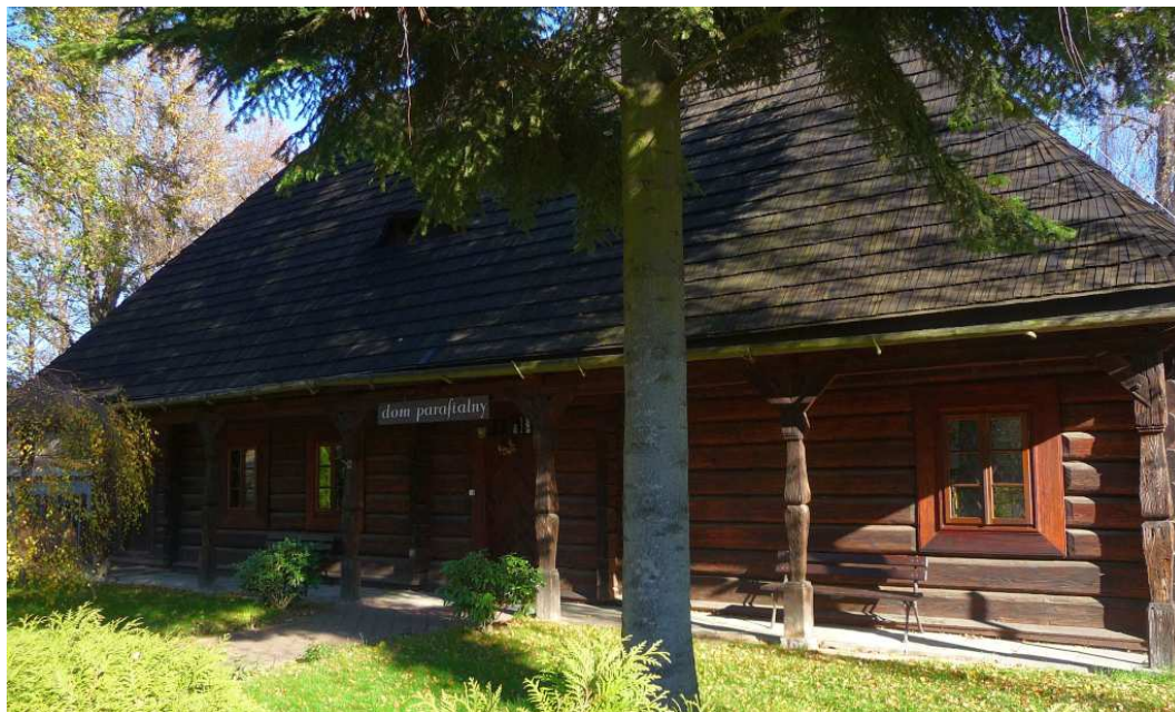
Fot. nr 192. Podcieniowa fasada (01.11.2024)
