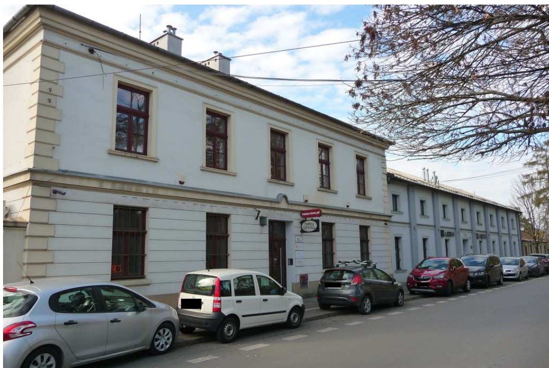
Fot. nr 133. Fabryka czekolady Charliego przy ulicy Kamiennej 45/4, powstała w pomieszczeniach po dawnych magazynach. (26.10.2024)
