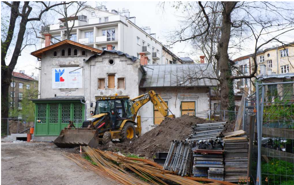
Fot. nr 31. Remont dworku Kossaków posuwa się do przodu. Przebudowany w roku 1910 przez T. Stryjeńskiego powstał w roku 1851 wg projektu Karola Kremera. (04.04.2024)
