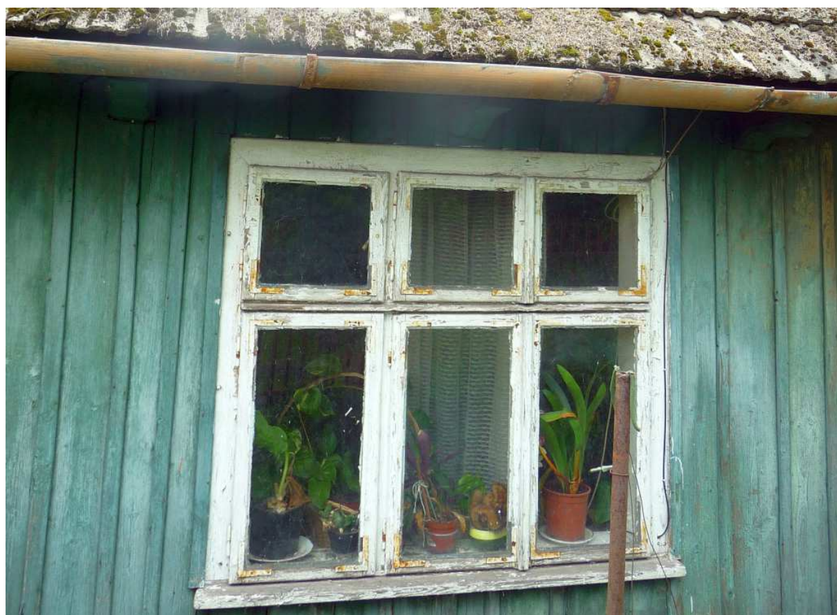
Fot. nr 372. Okno typu weneckiego zapewne z lat 30. XX wieku. (16.04.2024)
