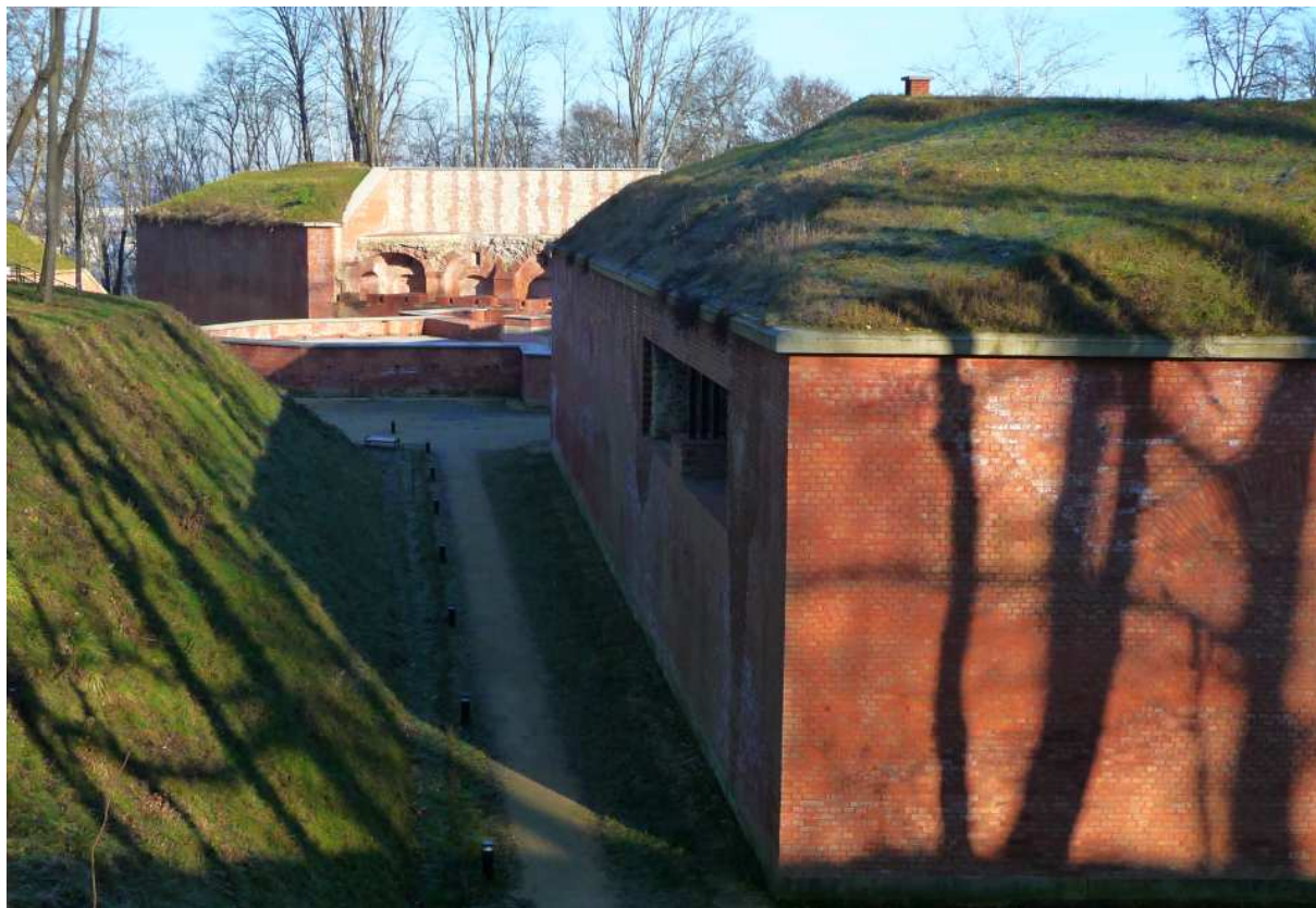
Fot. nr 60 (60-61). Zrekonstruowany mur oporowy bastionu nr II. (26.12.2024)
