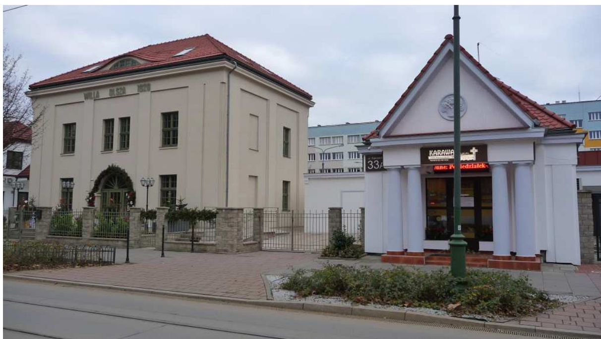
Fot. nr 220. Zabudowa ulicy Rakowickiej pod nr: 33 (kiosk z końca XIX wieku) i 35 (willa Olsza z roku 1928). (24.12.2024)
