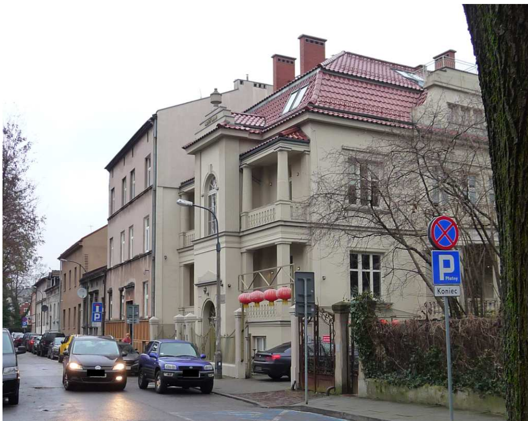
Fot. nr 262. Wzdłuż ulicy Zduńskiej, z zabudową w większości z początku XX wieku. (12.12.2024)
