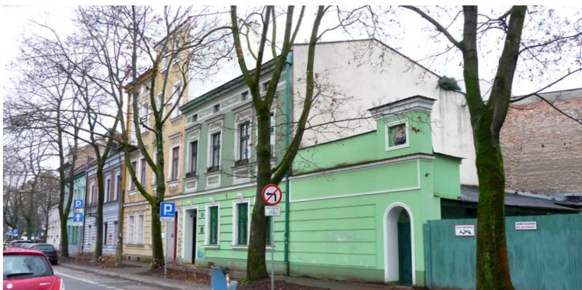
Fot. nr 259. Fragment zabudowy powyżej nr 29. (12.12.2024)
