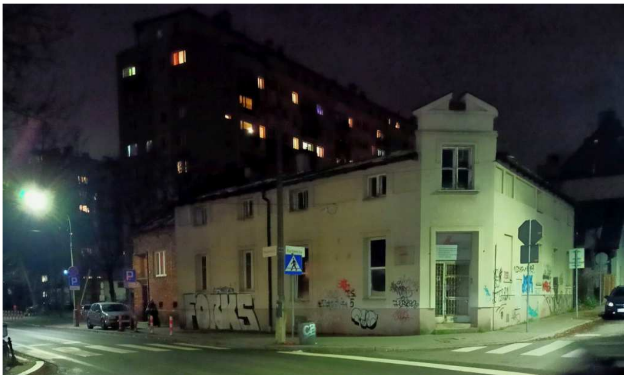
Fot. nr 99. Dawny Dom Michała Ezenkiera, krowoderskiego szopkarza i murarza, zwany też „Pod Orłem”, z ulicy Mazowieckiej 113, wybudowanego w roku 1911, który niebawem zniknie. (22.11.2024)
