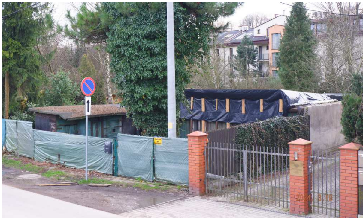
Fot. nr 70 (70-71). Rozbiórka zwierzynieckiej chatki z ulicy Emaus 39, jednego z ostatnich reliktów sielskiej zabudowy Zwierzyńca z II. połowy XIX wieku.
