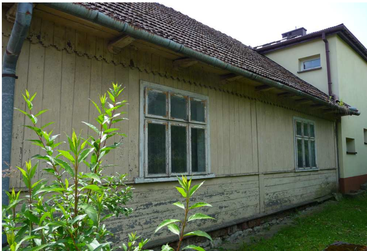
Fot. nr 427. Tylny fragment od strony podwórka z oknami typu weneckiego. (14.06.2024)
