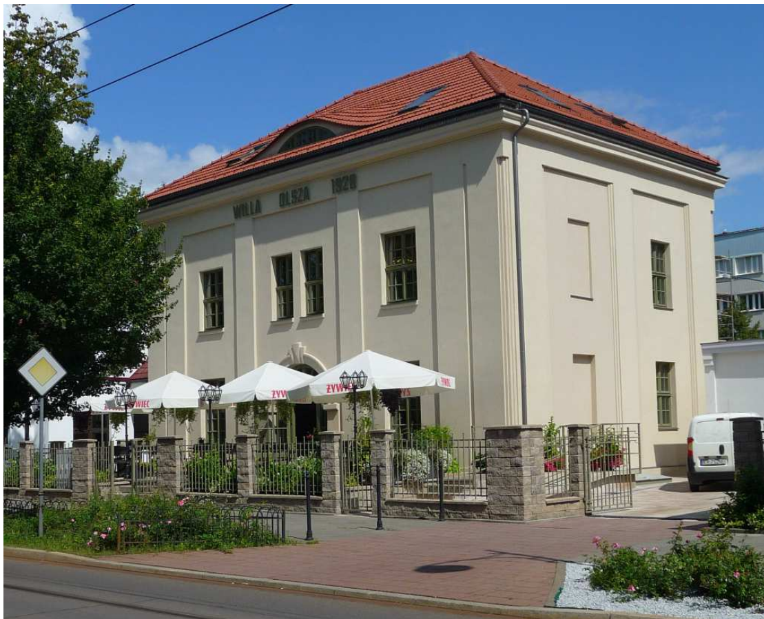
Fot. nr 221 (219-222). Solidnie wyremontowana willa Olsza nr 35. (25.07.2024)
