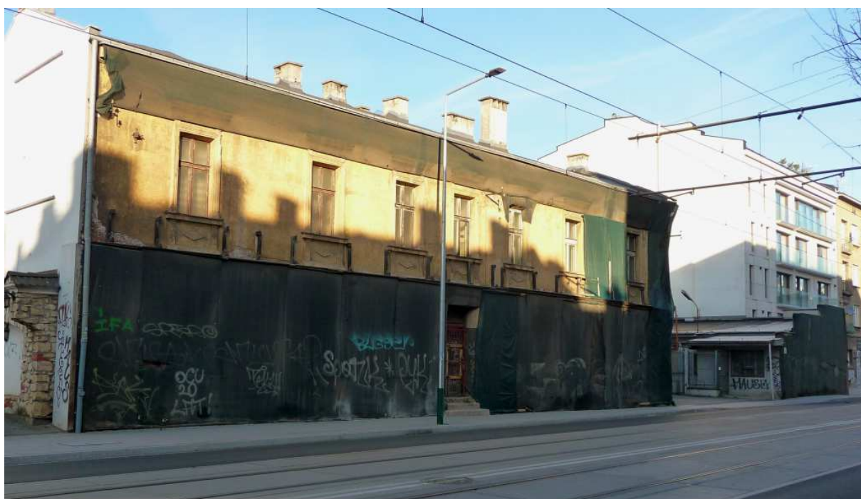
Fot. nr 45. Dom pod nr 51 z początku XX wieku w klimacie dawnego przedmieścia. (26.12.2024)
