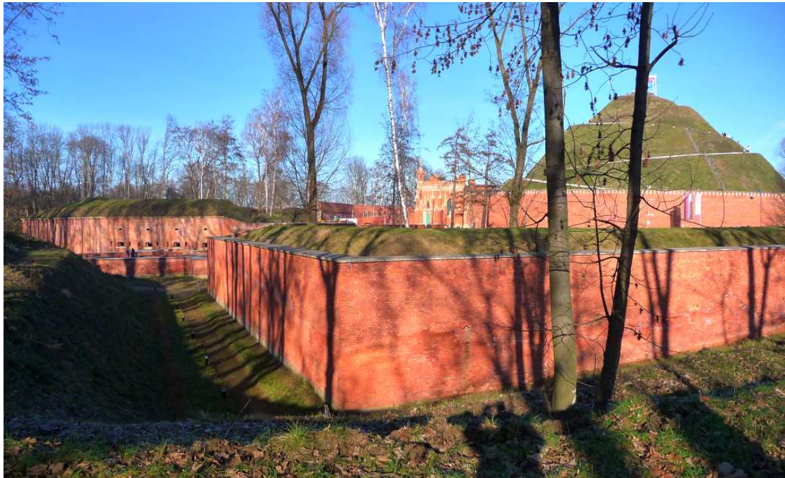
Fot. nr 49 (49-67). Wokół zrewitalizowanego fortu nr 2 Kościuszko, powstałego w latach 1850-56 wg projektu Feliksa Księżarskiego Częściowo zrekonstruowany bastion nr I, który po II wojnie uległ splantowaniu. Wybudowany od nowy mur oporowy. (26.12.2024)
