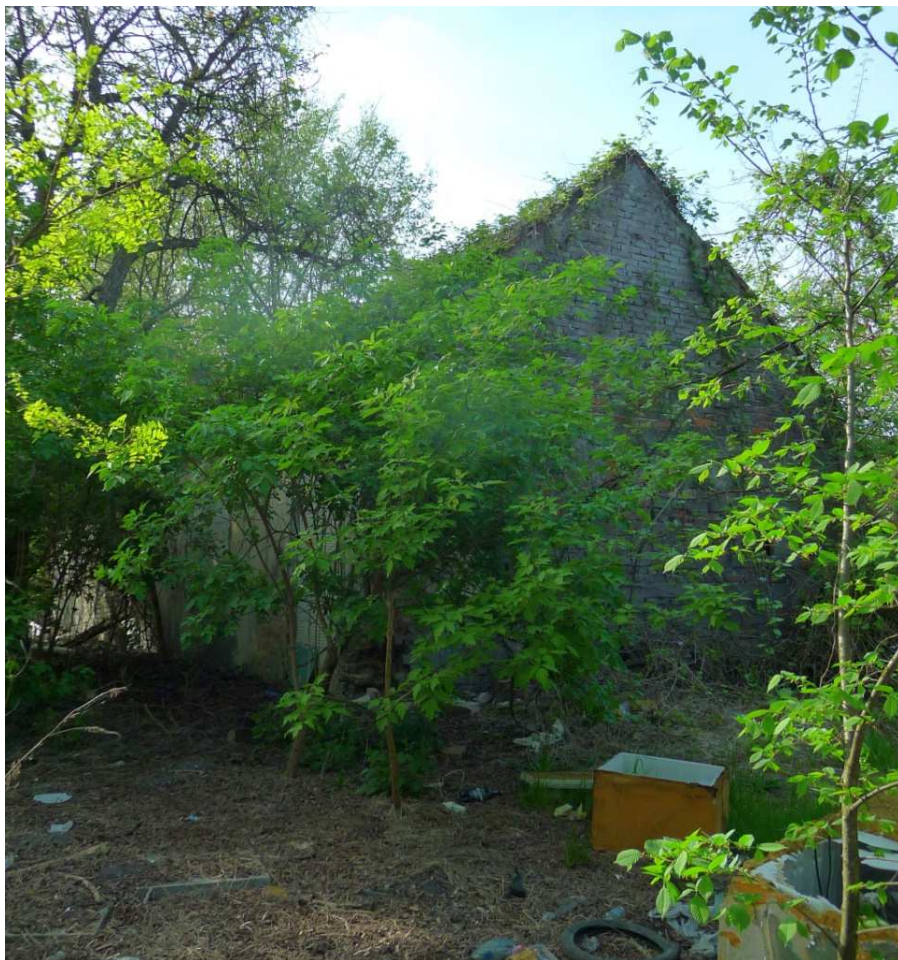
Fot. nr 325. Ruina domu pod nr 49, znikająca w zaroślach. (13.04.2024)
