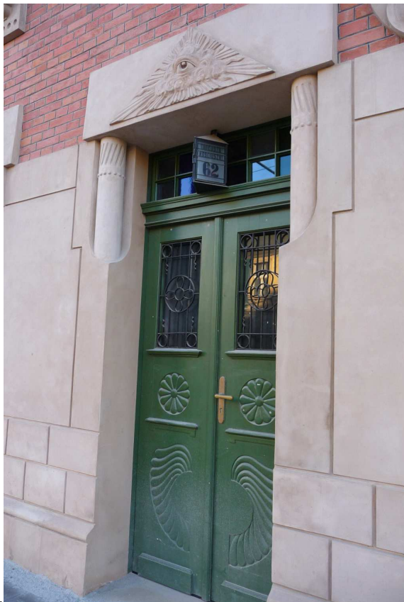
Fot. nr 49. Drzwi byłego domu „Pod Opatrznością” pod nr 62. (26.12.2024)
