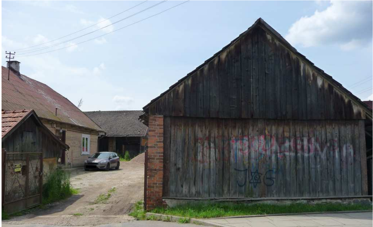
Fot. nr 422 (422-427). Wzdłuż ulicy Chałubińskiego. Fot. nr: 422-425. Zabudowania gospodarcze i dom pod nr 42. Data ich powstania (wg GEZ) to rok 1924. (14.06.2024)
