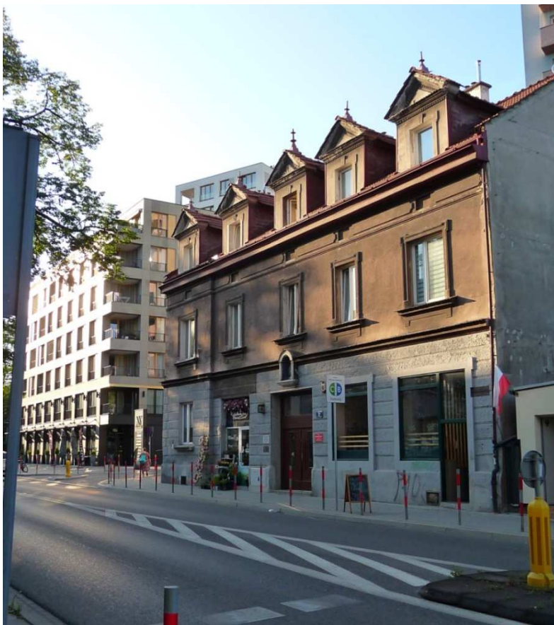
Fot. nr 94 (94-95). Nieco zniekształcona już fasada domu z ulicy Wrocławska 31, wybudowanego ok. roku 1910. (30.07.2024)
