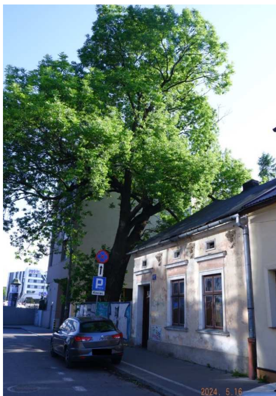
Fot. nr 255. Końcowy fragment zabudowy ulicy Kilińskiego,
