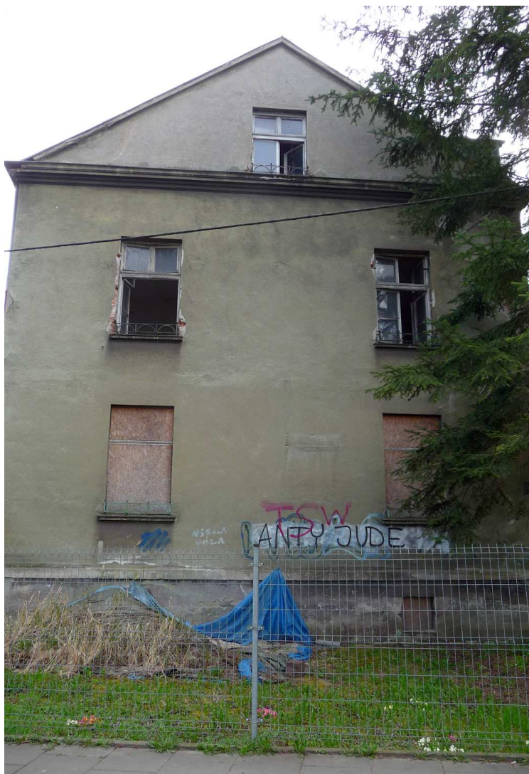
Fot. nr 294. Ściana szczytowa od strony ulicy Korzeniowskiego.(13.04.2025)
