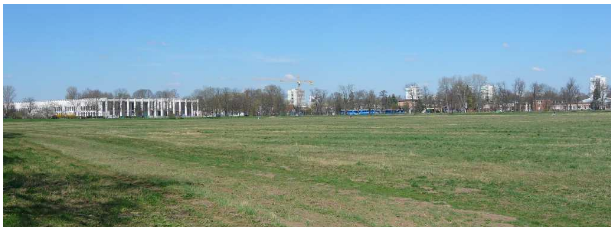
Fot. nr 236. Z ulicą Piastowską i Cichym Kąciem w tle. Trwa budowa Centrum Muzyki. (03.04.2025)
