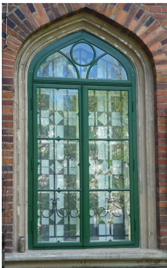
Fot. nr 154. Oryginalne okno w fasadzie. (19.04.2025)
