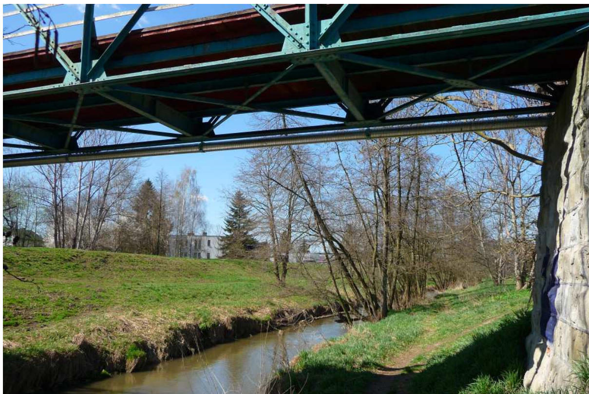
Fot. nr 241. Widok w górę rzek spod IV. mostu. (03.04.2025)
