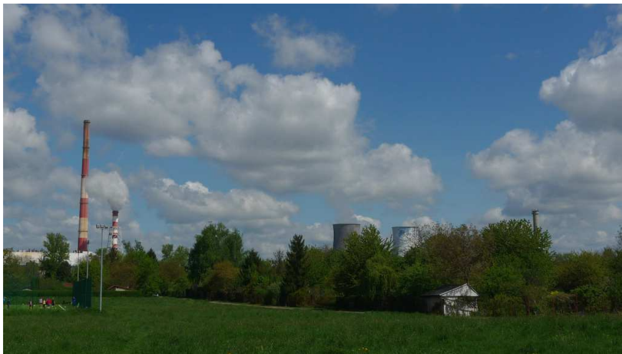
Fot. nr 433. Widok od strony pętli tramwajowej ku elektrociepłowni w Łęgu. (26.04.2025)
