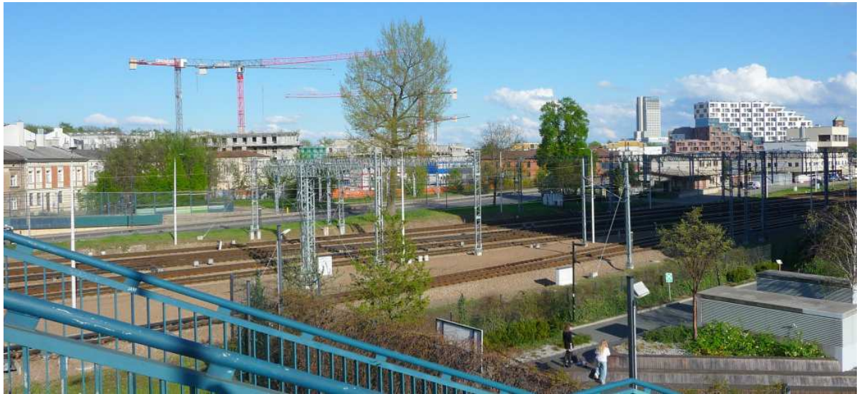
Fot. nr 130 (130-131). Widoki z wiaduktu nad ulicą Warszawską. W stronę Grzegórzek. (19.04.2025)
