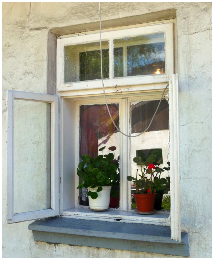
Fot. nr 340. Trójskrzydłowe okno, typowe dla czasów międzywojennych. (21.05.2025)
