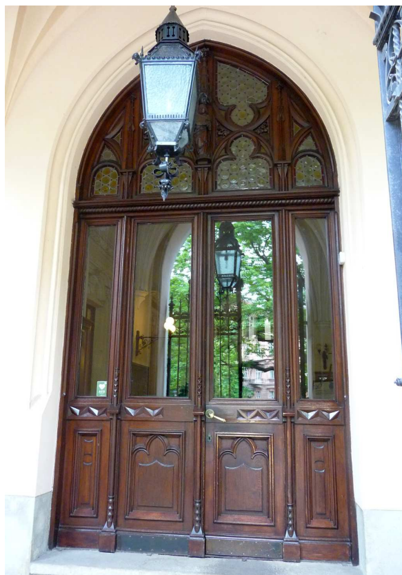
Fot. nr 106 (106-107). Drzwi w Collegium Novum. (16.05.2025)
