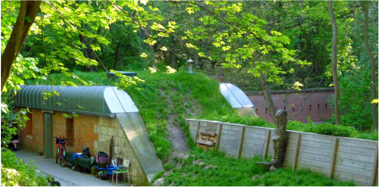
Fot. nr 288. Schron w zespole bramnym 3a fortu Kościuszko. FS-3 (27.04.2025)
