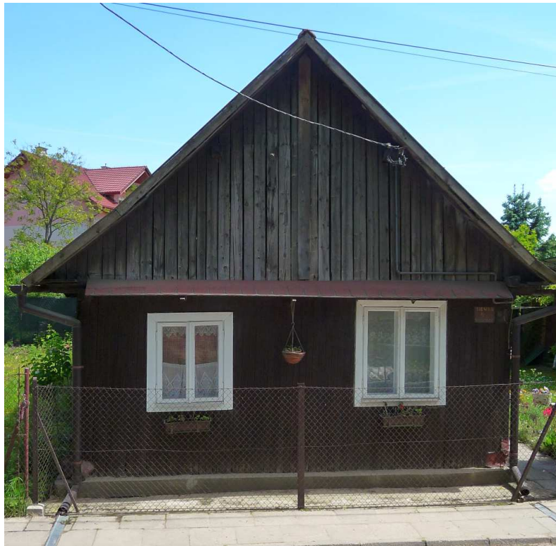
Fot. nr 320a. Ściana szczytowa. (21.05.2025)
