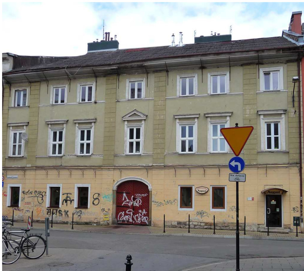
Fot. nr 373 (373-374). Dwustuletnia kamieniczka z ulicy Augustiańskiej 26, w której fasadzie zostały już wymienione wszystkie oryginalne ośmiopolowe okna. (15.05.2025)
