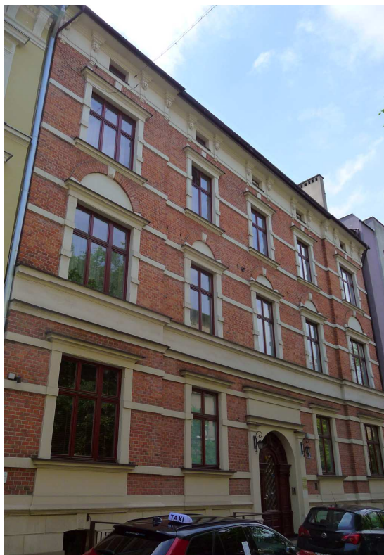
Fot. nr 223 (223-224). Odrestaurowana fasad kamienicy z ulicy Zegadłowicza 4, wybudowanej na przełomie wieków: XIX i XX. (16.05.2025)
