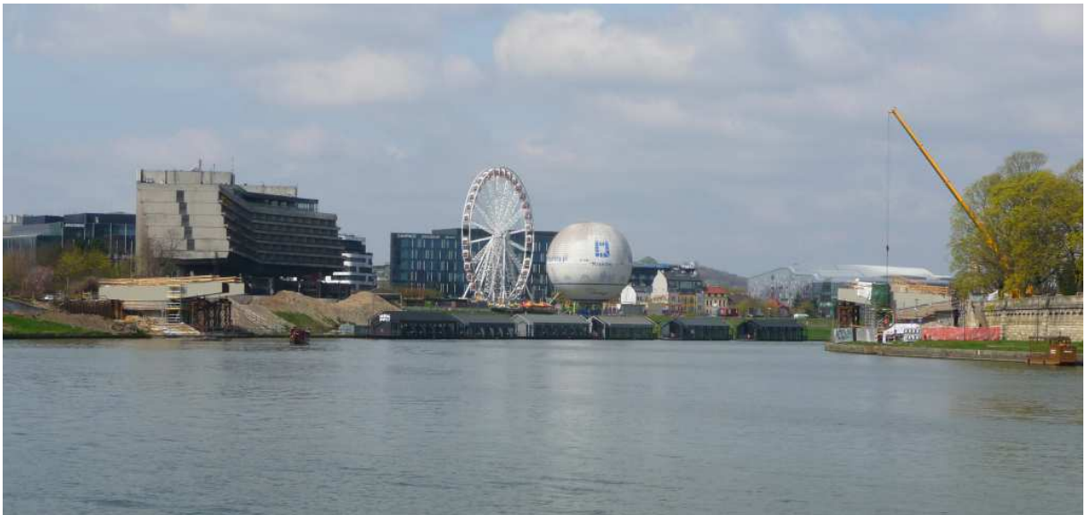
Fot. nr 6 (6-10). Widoki Ludwinowa w okolicy dawnego Hotelu Forum w trakcie budowy nowej kładki. (12.04.2025)
