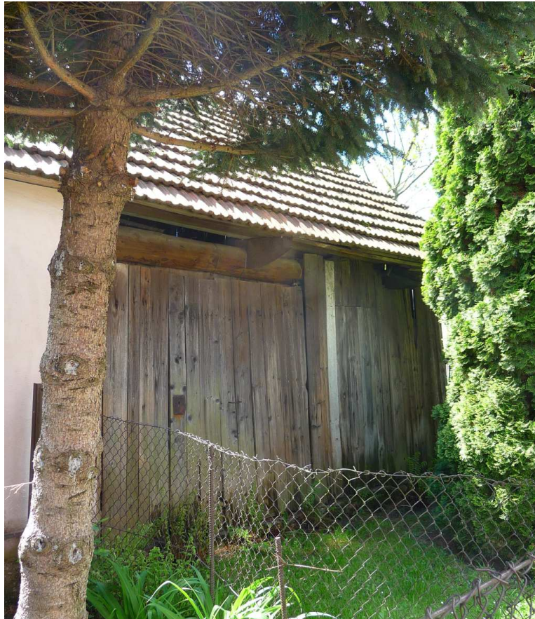
Fot. nr 449. Niewielka stodoła w jednym korpusie z częścią mieszkalną. (26.04.2025)
