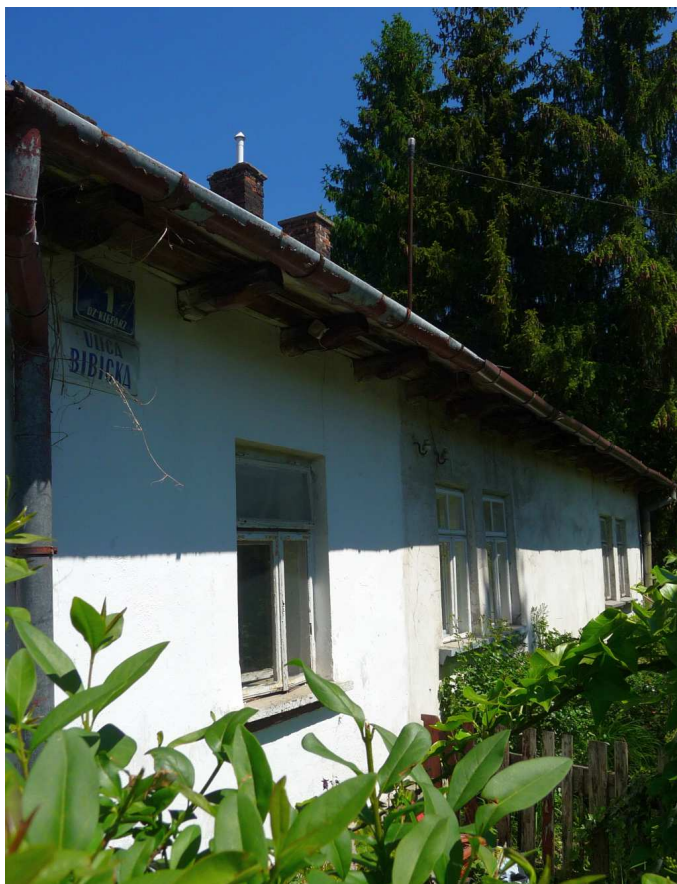
Fot. nr 341. Widok od strony ogrodu. (21.05.2025)
