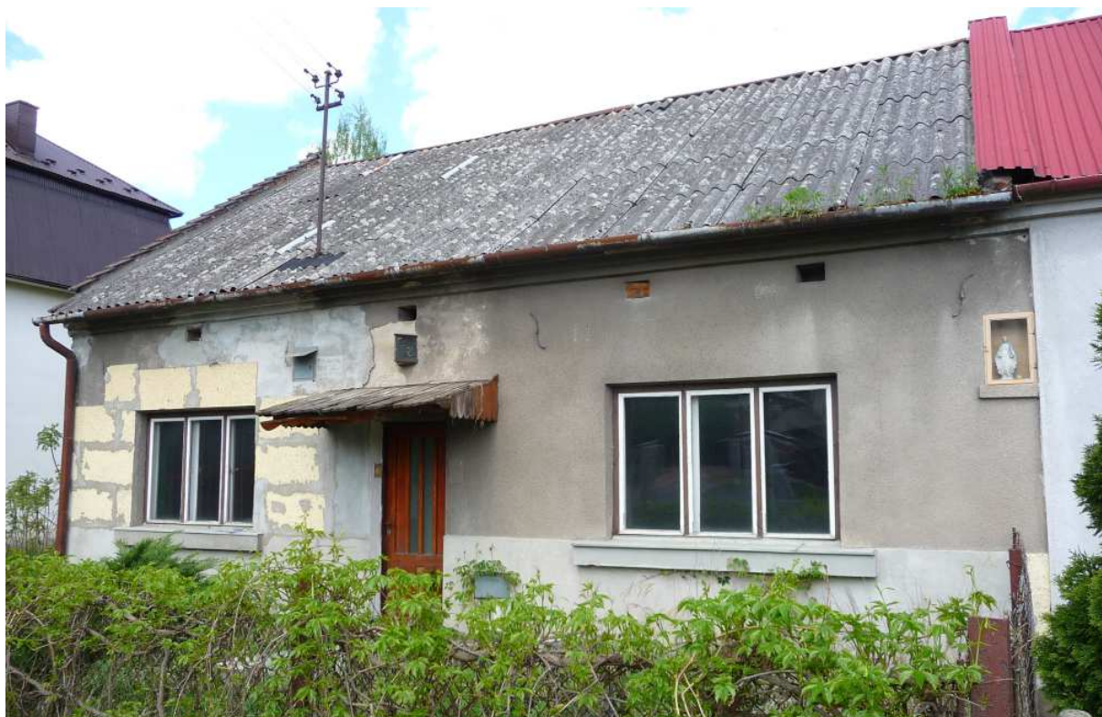
Fot. nr 487. Zapewne już powojenny dom, z niewielką kapliczką w fasadzie, pod nr 47. (26.04.2025)
