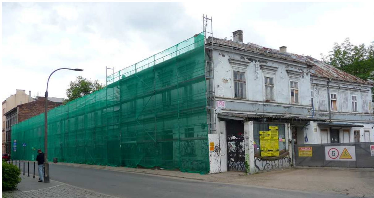
Fot. nr 197 (197-198). Dawna rządowa Cygar Fabryka z ulicy Dolnych Młynów 10-12 na etapie przebudowy w komercyjne blokowisko. Zabudowania socjalne. (24.05.2025)
