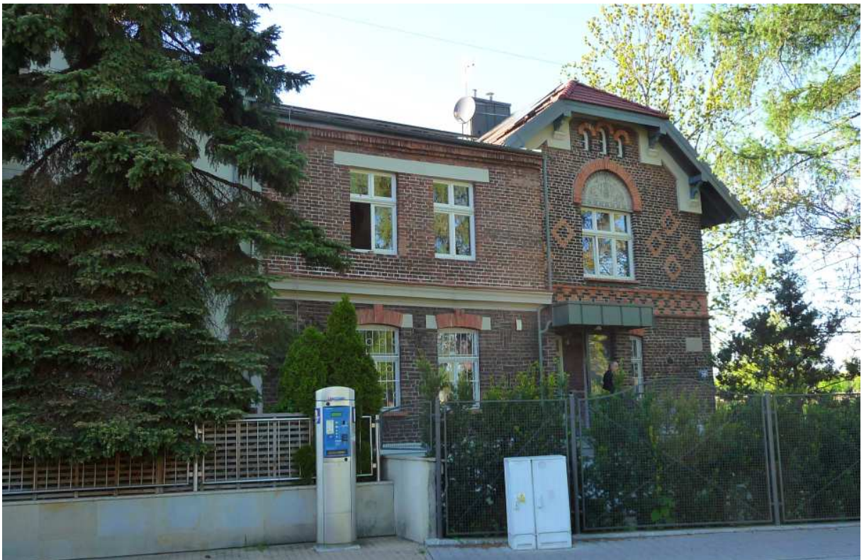
Fot. nr 289 (289-290). Willa z ogrodem, wybudowana w roku 1895, z naroża ulic: Emaus 30 i Przegon 22. (27.04.2025)
