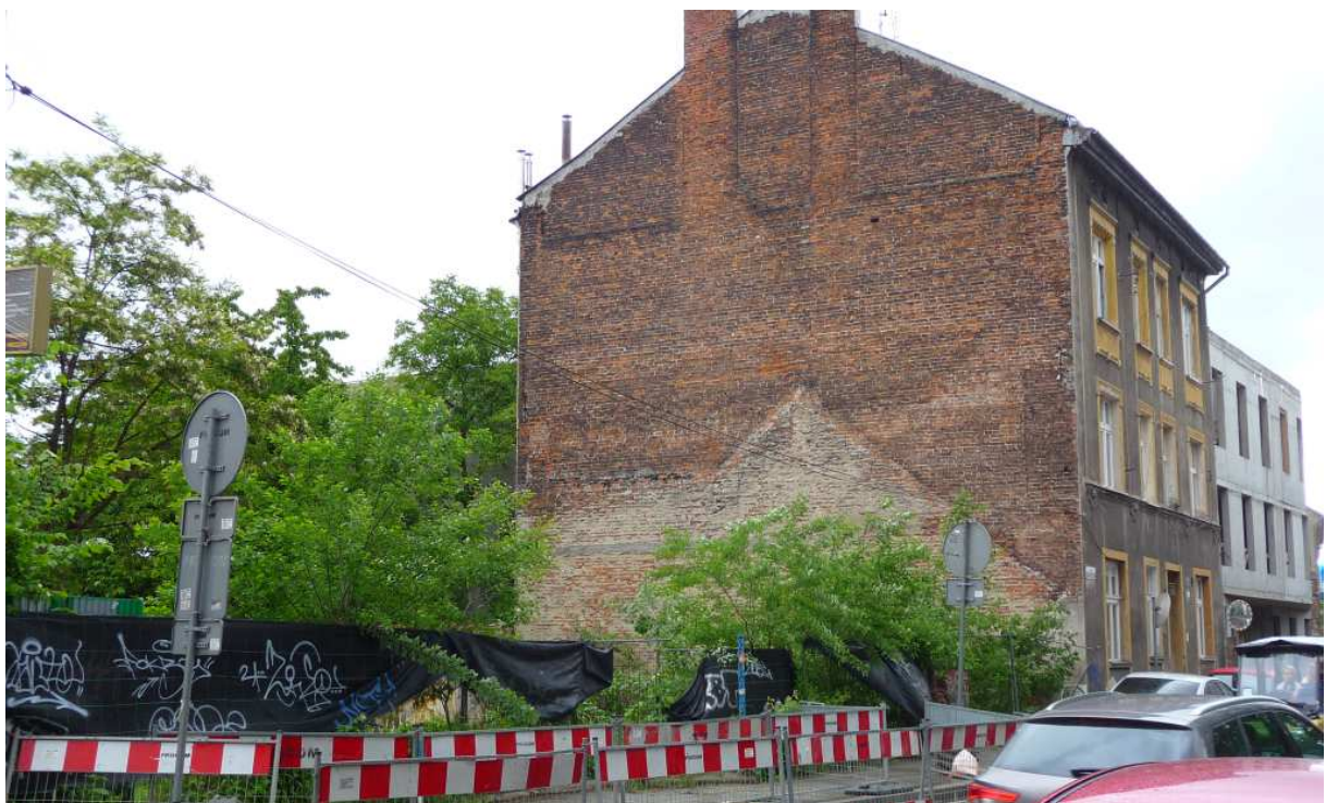
Fot. nr 396. Tyle pozostało po niedawno wyburzonym, urokliwym podmiejskim domku pod nr 12 – narys dachu na ścianie kamieniczki pod nr 14. (18.05.2025)
