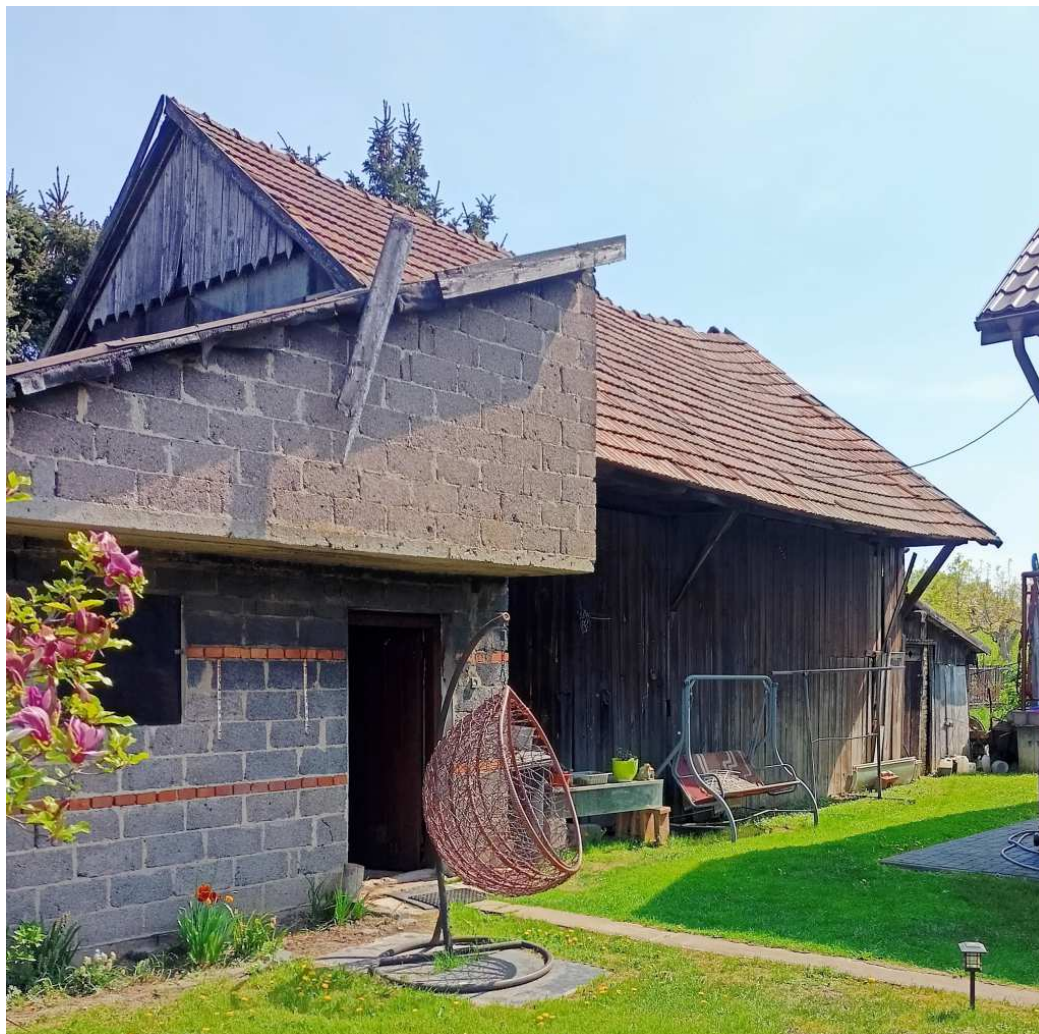
Fot. nr 459. Kolejna stodoła na posesji pod nr 95. (24.04.2025)
