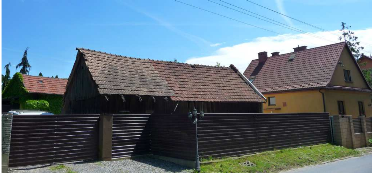
Fot. nr 319 (319-320b). Wzdłuż ulicy Siewnej. Dawna zagroda pod nr 72, z oryginalnymi zabudowaniami gospodarczymi. (21.05.2025)
