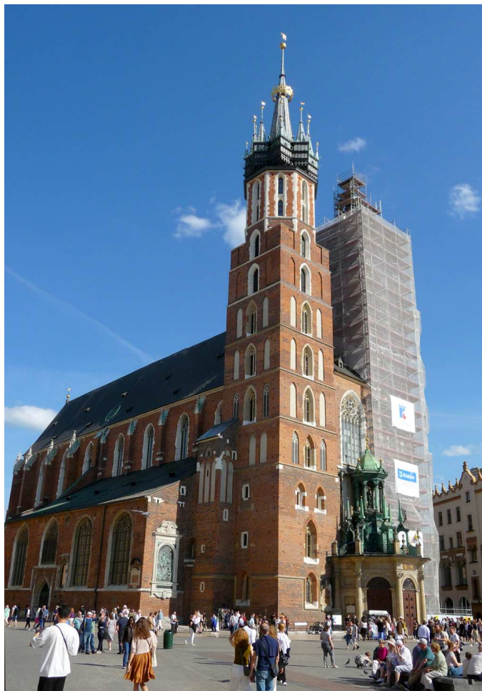
Fot. nr 84 (83-84). Kościół Mariacki w trakcie remontu Hejnalicy. (01.05.2025)
