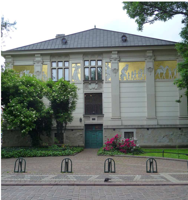
Fot. nr 110. Północna ściana Pałacu Sztuki. (24.05.2025)
