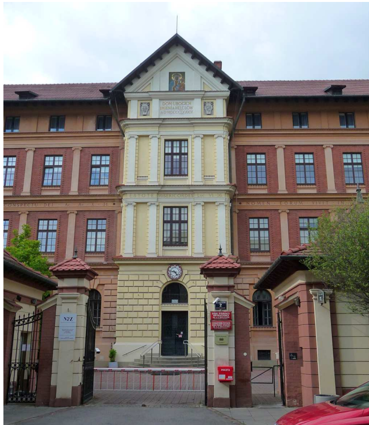
Fot. nr 126. Ryżalit zakładu Helclów przy ulicy Helclów 2. (19.05.2025)
