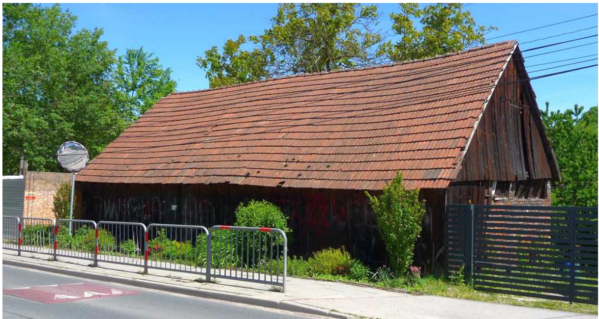
Fot. nr 323a. Stodoła przy zagrodzie. (21.05.2025)
