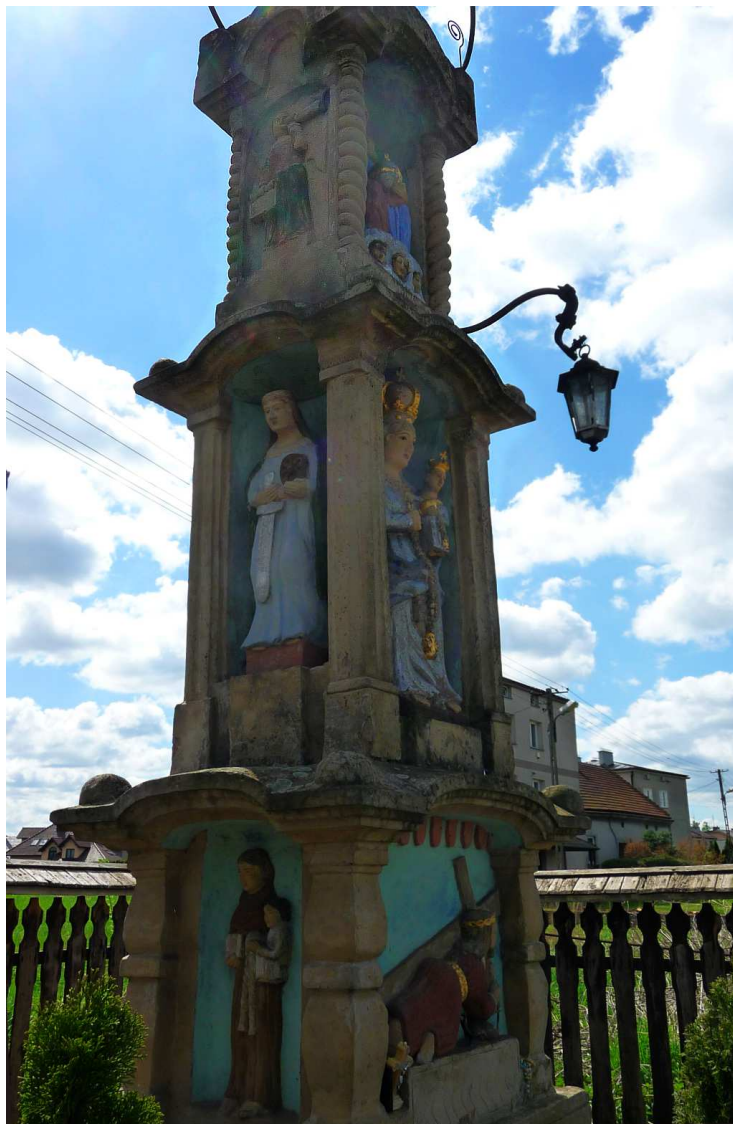
Fot. nr 479 (479-482). Lewy bok i posadowione w jego wnękach figury. (26.04.2025)
