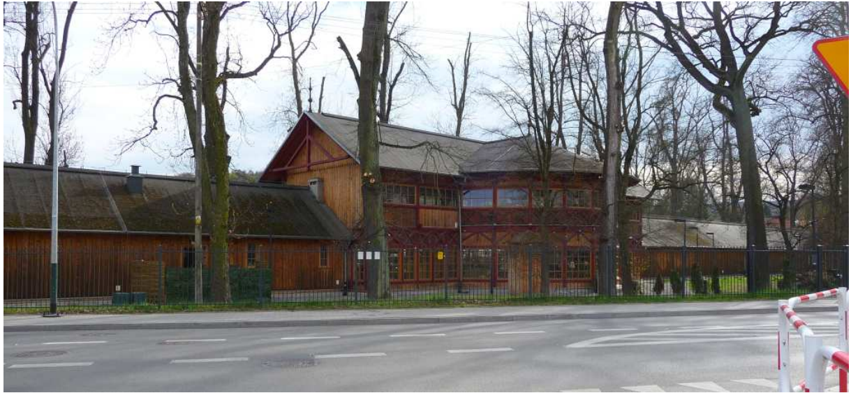
Fot. nr 300 (300-303). Fronton zrewitalizowanej, dawnej strzelnicy, wybudowanej na potrzeby Twierdzy Kraków, potem sportowej, przy ulicy Królowej Jadwigi 220. (13.04.2025)
