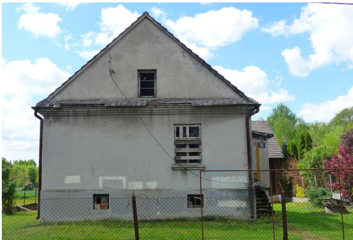
Fot. nr 467. Ściana szczytowa domu. (26.04.2025)
