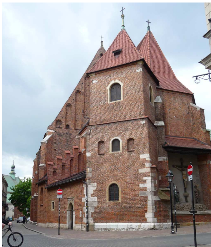
Fot. nr 113. Kościół św. Marka. (24.05.2025)
