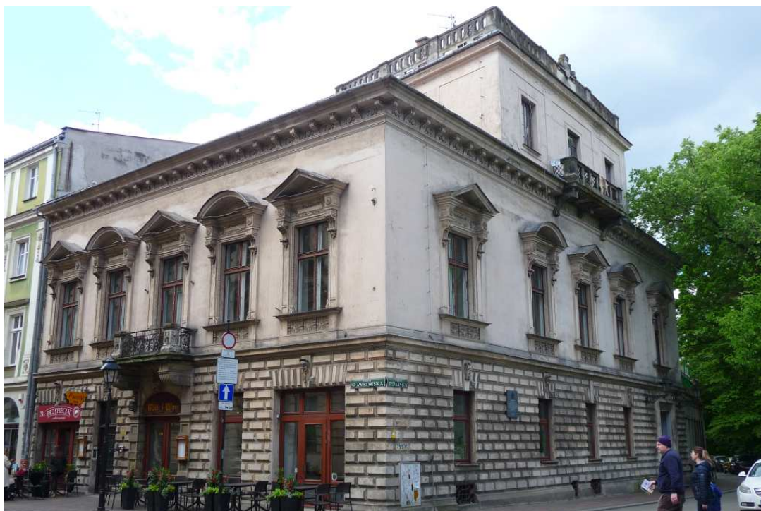
Fot. nr 114. Pałac Badenich przy ul. Sławkowskiej 30 tuż przed remontem. (11.05.2025)
