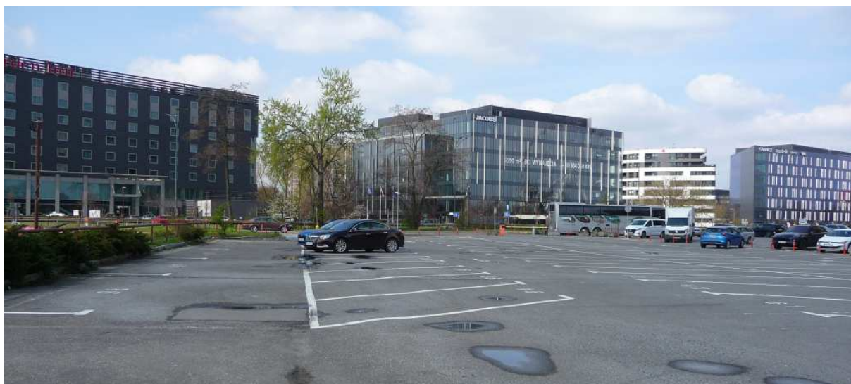
Fot. nr 357 (357-358). Współczesna zabudowa na pograniczu z Zakrzówkiem wzdłuż fragmentu ulicy Konopnickiej. (12.04.2025)
