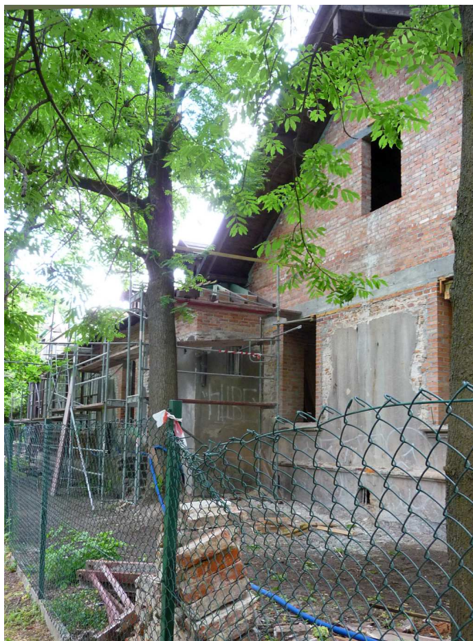
Fot. nr 171 (171-173). Wreszcie rozpoczął się remont, a przy tym rozbudowa Modrzejówki przy ulicy Grottgera 11. (19.05.2025)
