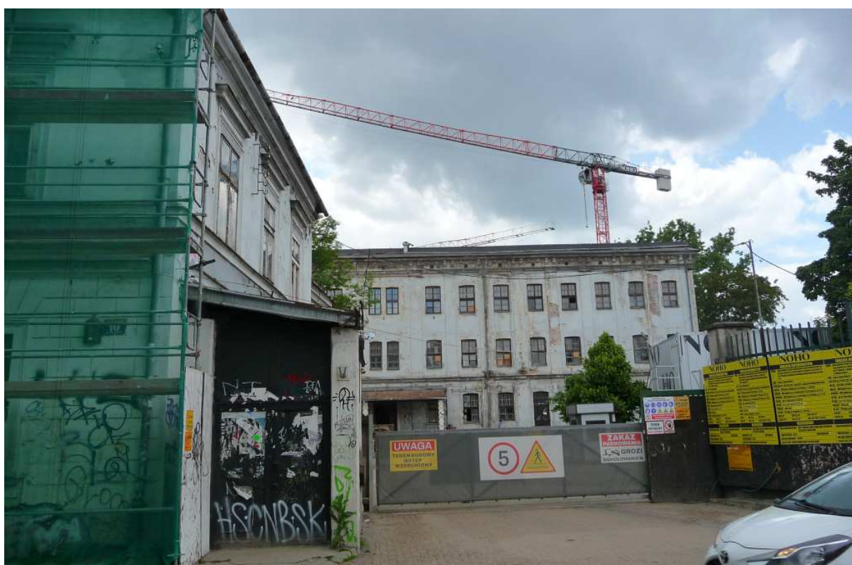
Fot. nr 198. Dawny wjazd na teren fabryki. (24.05.2025)
