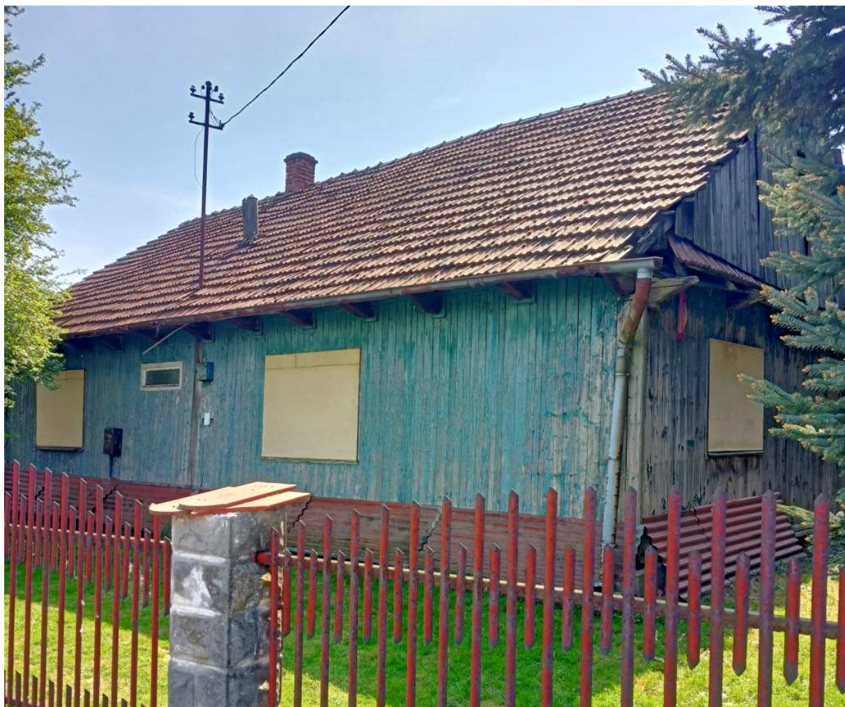
Fot. nr 445 (445-446). Opuszczona od lat chałupa w zagrodzie pod nr 59. (24.04.2025)
