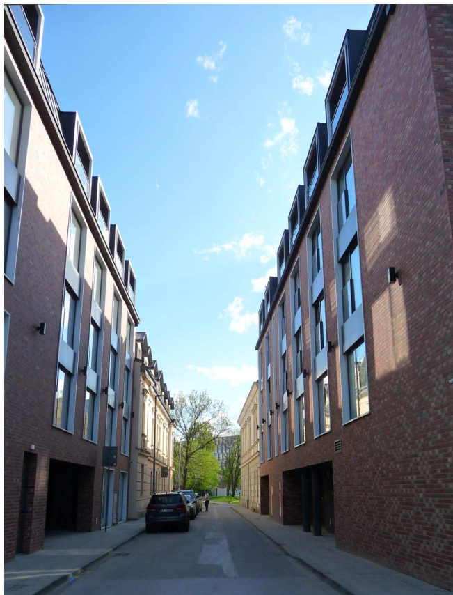
Fot. nr 136 (136-144). Wzdłuż ulicy Kątowej. Widok z ulicy Żelaznej (19.04.2025)
