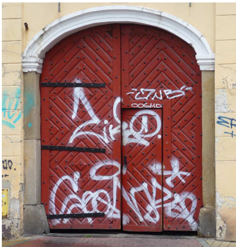
Fot. nr 374. Oryginalna drzwi i portal w bramie wjazdowej. (15.05.2025)
