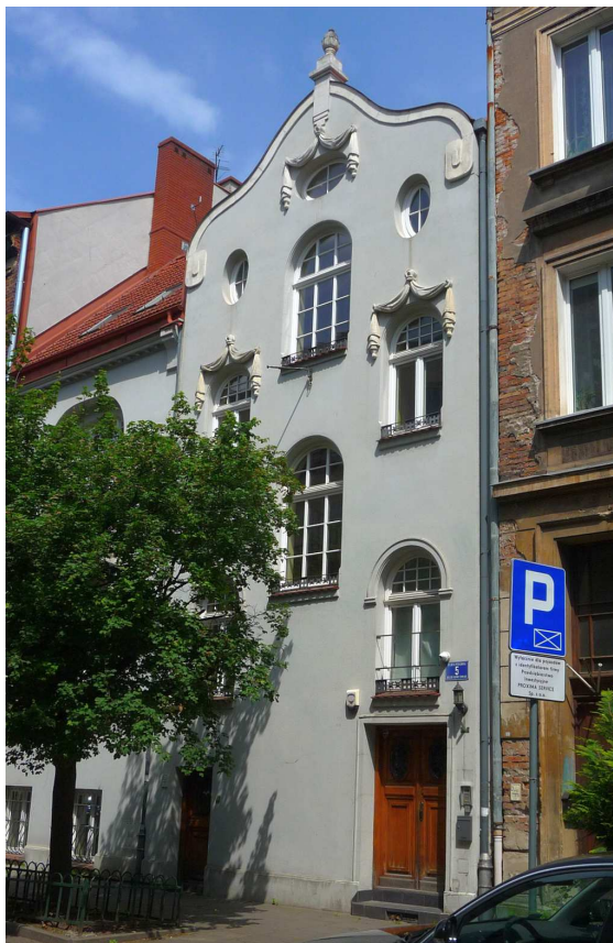
Fot. nr 222. Wyremontowana fasada kamienicy wybudowanej około roku 1910. z ulicy Wygoda 5. (16.05.2025)
