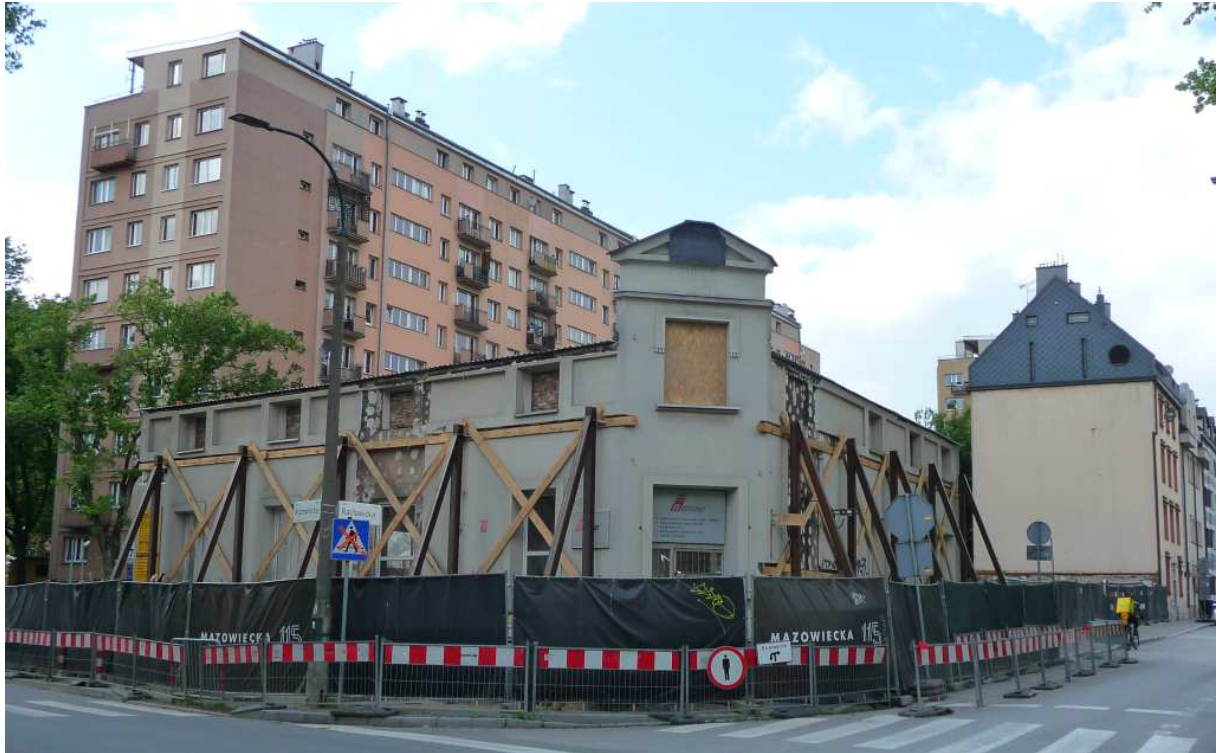
Fot. nr 175. Po kamieniczce, zwanej też od dawnego emblematu w zwieńczeniu narożnika „pod orłem”, przy ulicy Mazowieckiej 113 pozostanie tylko ściana fasadowa. (19.05.2025)
