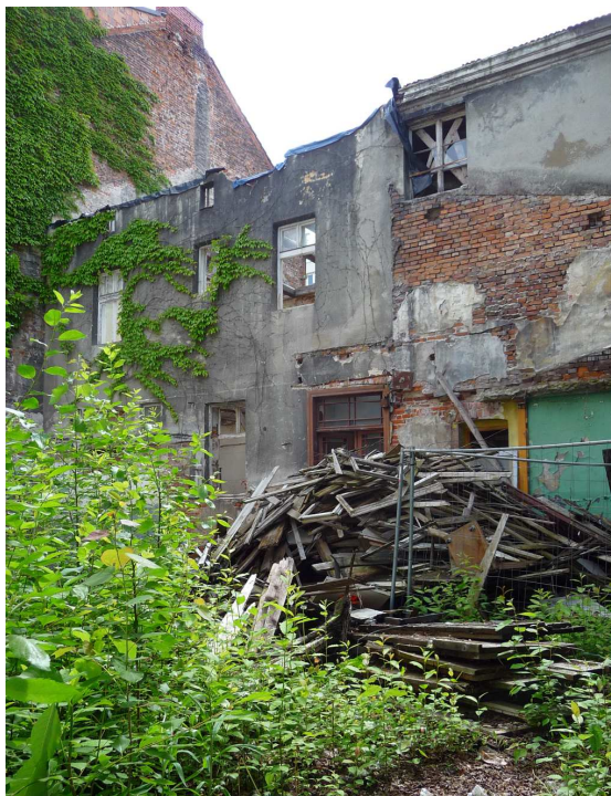
Fot. nr 255. Wyburzone zabudowania fabryczne dawnej wytwórni wód gazowanych Jaworskiego od strony ulicy Filareckiej 1. (27.05.2025)
