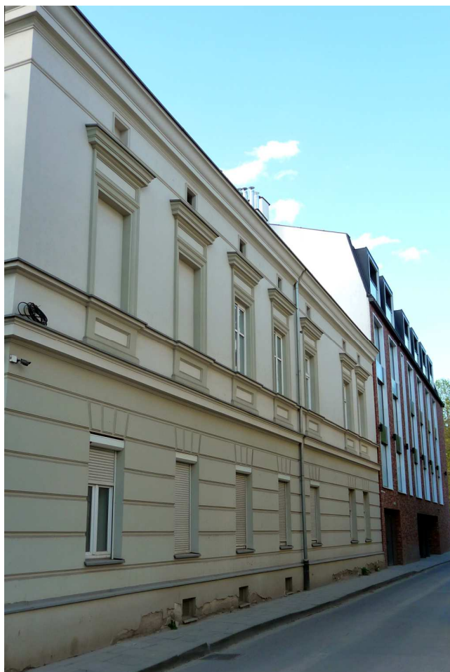
Fot. nr 140 (140-141). Wyremontowana narożna kamieniczka pod nr 6. (19.04.2025)
