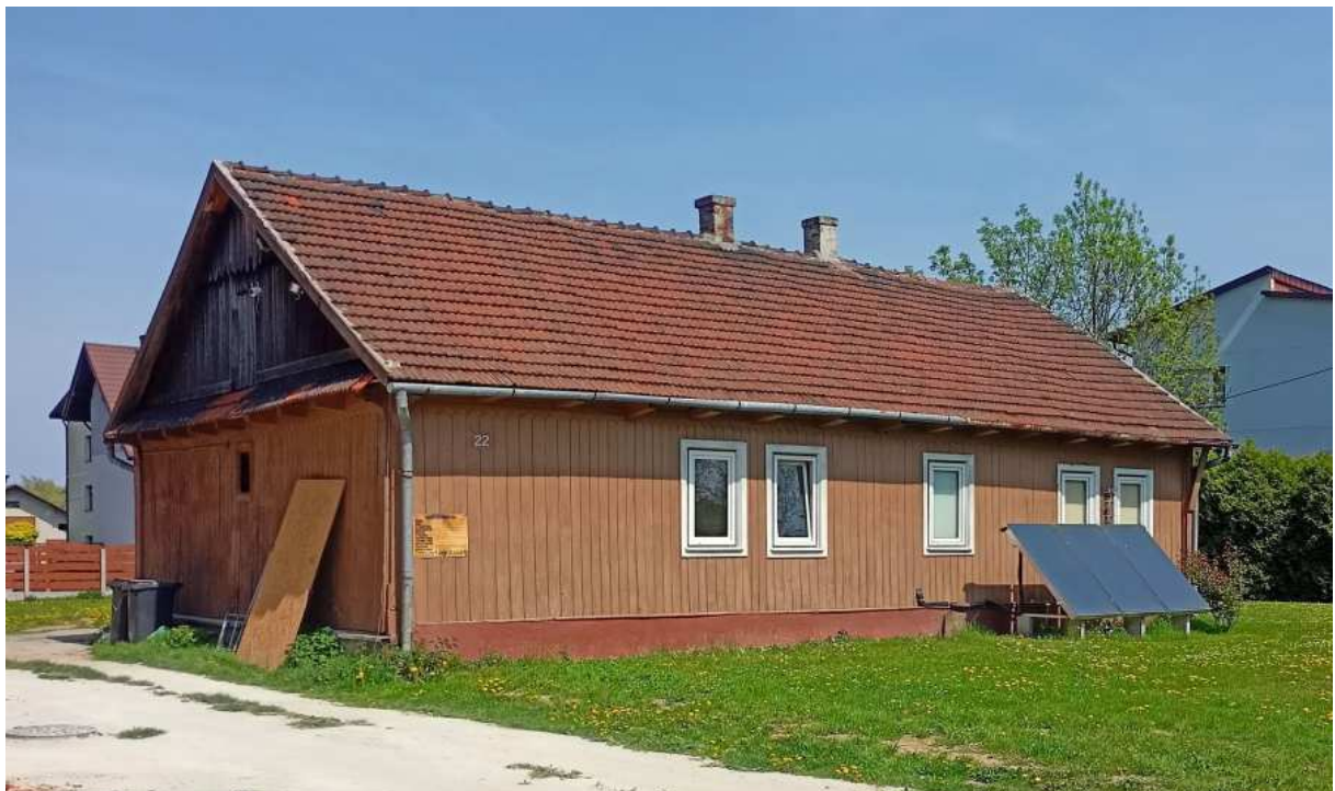
Fot. nr 450. Do niedawna oryginalny dom, zapewne blisko 100-letni, pod nr 22. Dziś wygląd jego fasady zaburzyły bezpodziałowe okna plastikowe. (24.04.2025)
