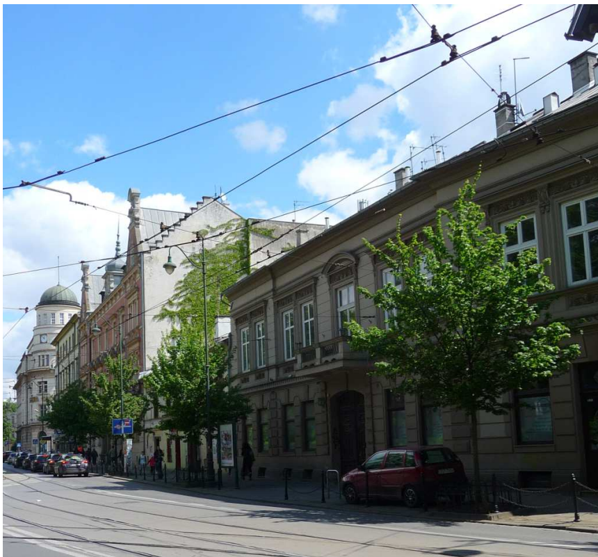
Fot. nr 161 (161-162). Wzdłuż ulicy św. Gertrudy. Fragment zabudowy poniżej nr 5. (11.05.2025)
