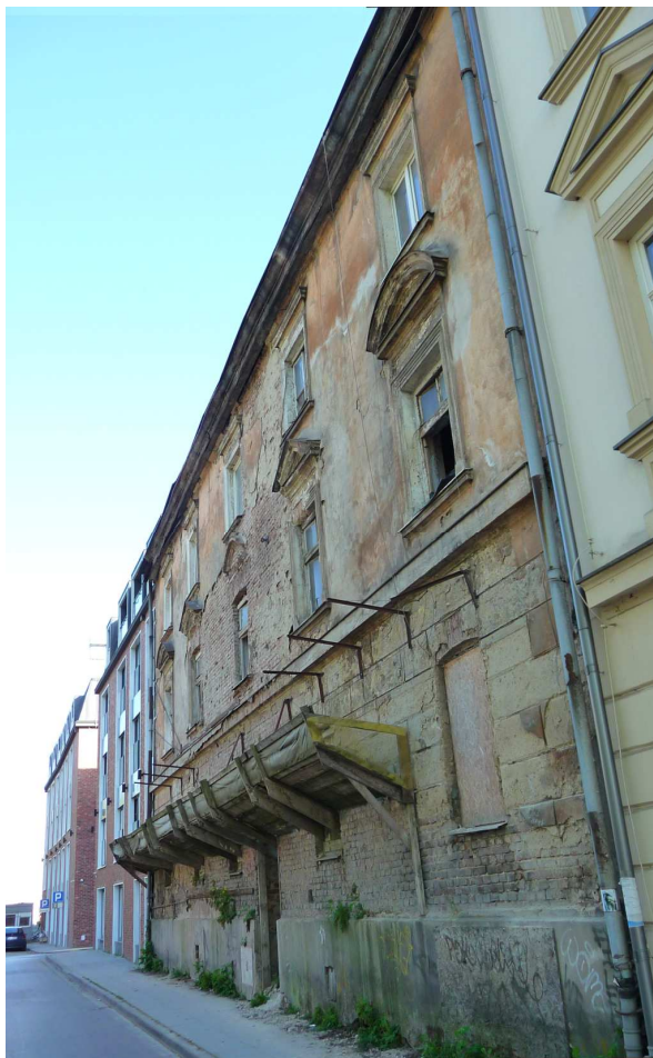
Fot. nr 134 (134-135). Przygotowana do remontu kamienica pod nr 3 (19.04.2025)
