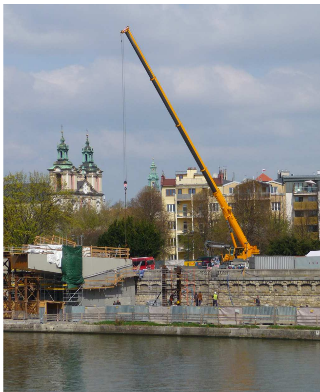
Fot. nr 11. Przyczółek kładki ludwinowskiej od strony Bulwaru Inflanckiego. (12.04.2025)
