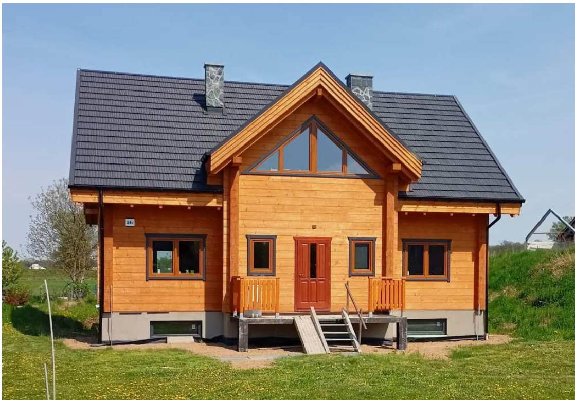
Fot. nr 456 (456-457). Odrestaurowany bądź raczej wybudowany w dawnej stylistyce dom pod nr 34c. (24.04.2025)
