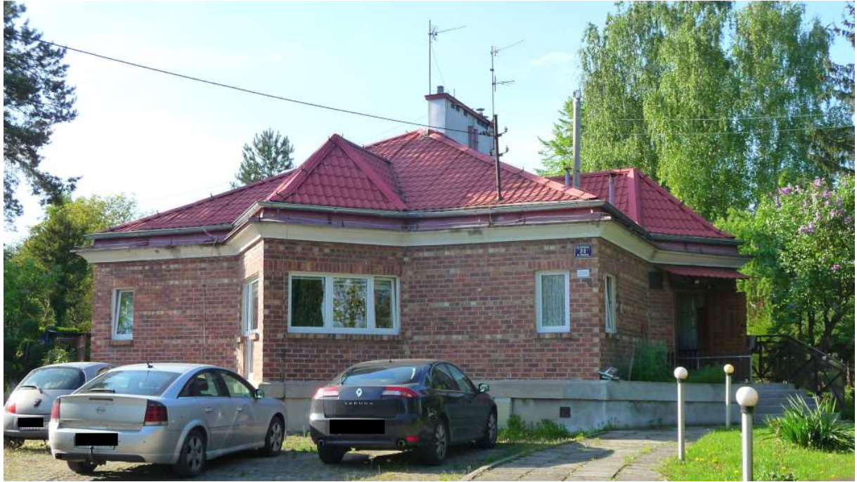
Fot. nr 550. Przerobiona na budynek mieszkalny dawna kaponiera obrony przy wjeździe do fortu. (30.04.2025)
