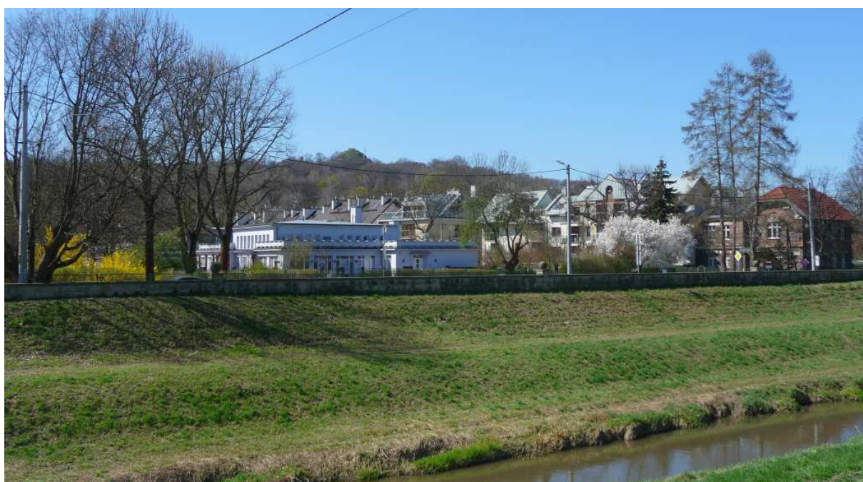
Fot. nr 233. W stronę ulicy Przegon. (03.04.2025)
