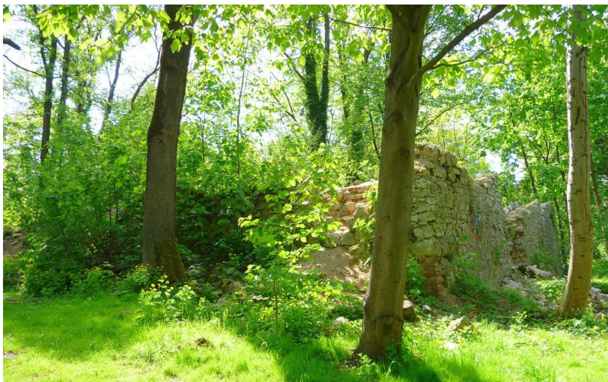
Fot. nr 416. Ruina zabudowania gospodarczego. (29.04.2025)
