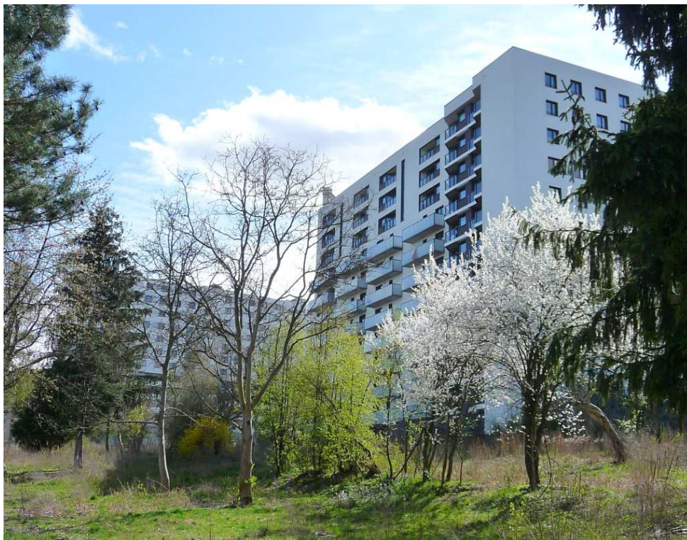
Fot. nr 498 (498-499). Ręce opadają patrząc na rozbudowę blokowiska przy ulicy Podedworze 9, które wręcz wlewa się na teren parku. (08.04.2025)
