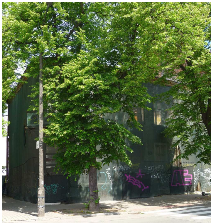
Fot. nr 254 (254-255). Z domu przy ulicy Senatorskiej 5 pozostały tylko ściany fasadowe. (27.05.2025)
