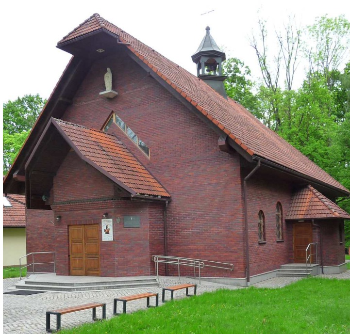
Fot. nr 523. Kaplica św. Teresy z Lisieux z ulicy Goryczkowej. (04.05.2025)
