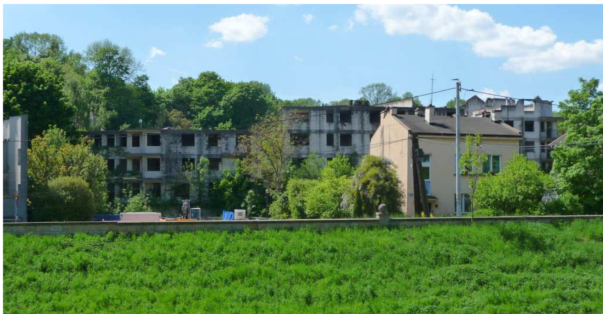
Fot. nr 277. Trzydziestoletnia już ruina nieukończonego blokowiska pod nr 71. (02.05.2025)
