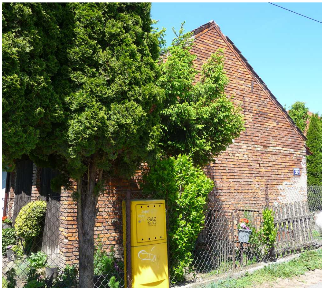
Fot. nr 312a. Widok od strony ulicy Natansona. (21.05.2025)
