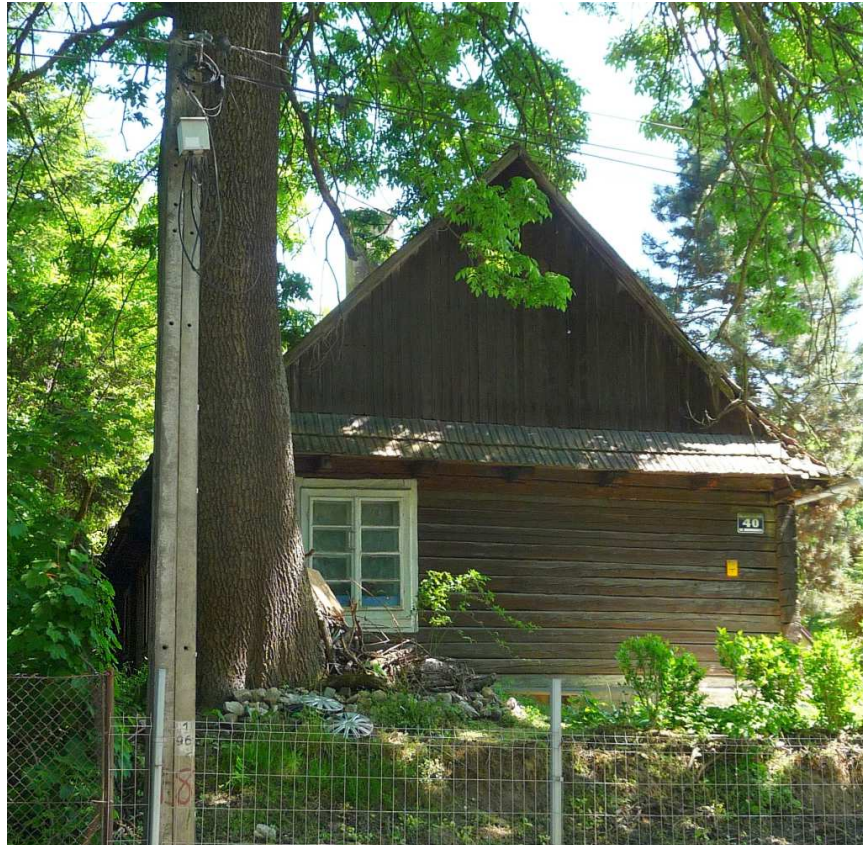
Fot. nr 331. Ściana szczytowa. (21.05.2025)
