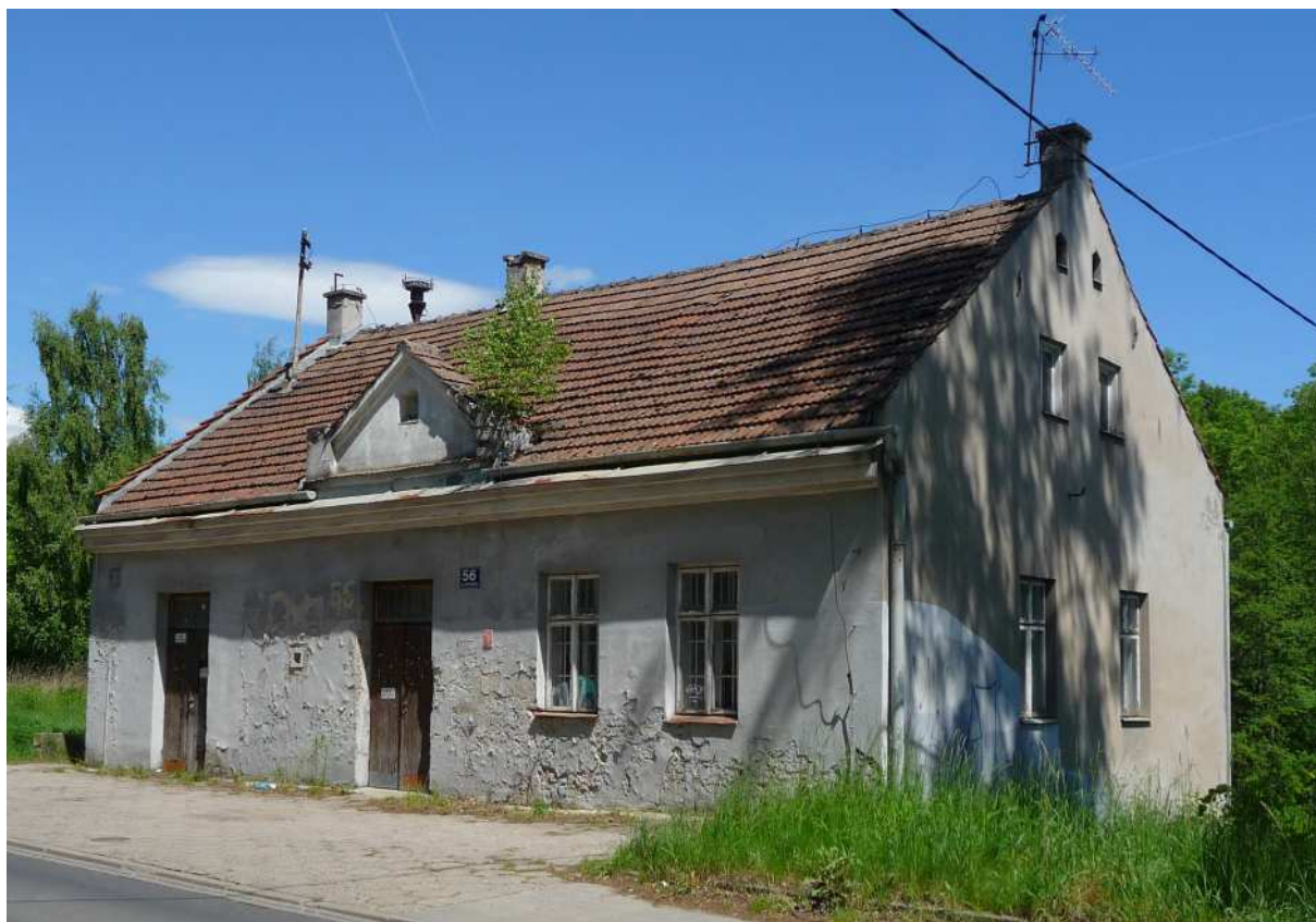
Fot. nr 336 (336-337). Murowany dom, prawdopodobnie dawna remiza, pod nr 56. (21.05.2025)
