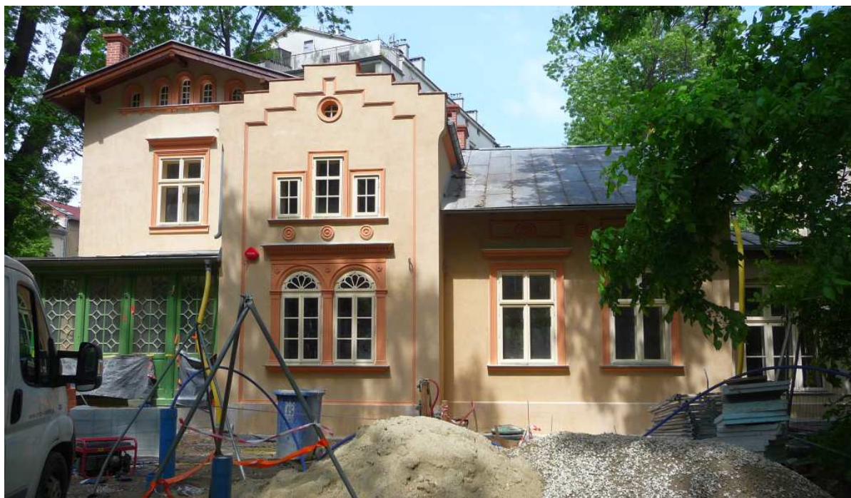
Fot. nr 221. Końcowy etap remontu Kossakówki. (16.05.2025)
