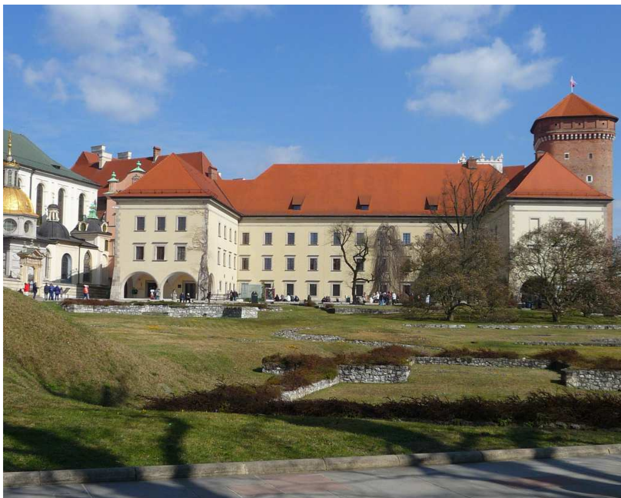
Fot. nr 42. Przebudowany po II wojnie światowej, w miejscu dawnych kuchni i wozowni królewskich, zewnętrzny fragment zachodniego skrzydła zamku królewskiego. (18.03.2025)
