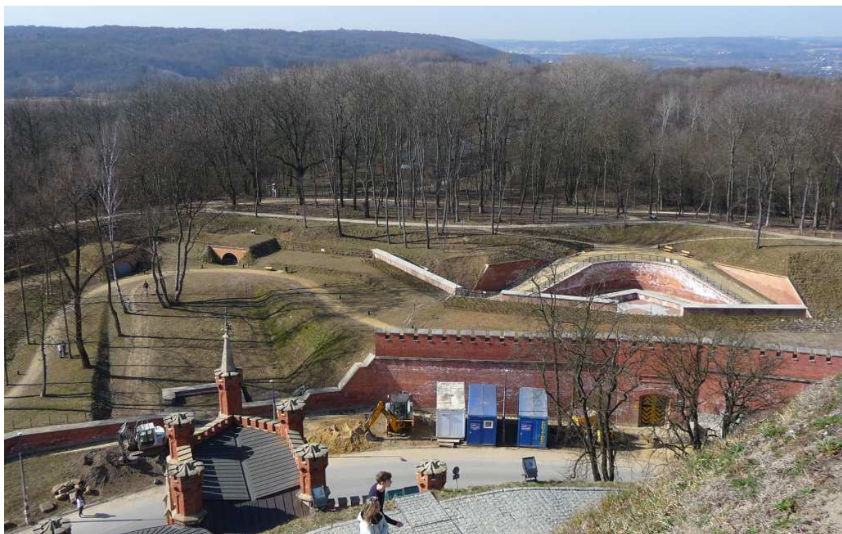
Fot. nr 132 (132-133). Bastion nr II (z lewej), kaponiera między bastionami nr I i II oraz częściowo zrekonstruowany mur wewnętrzny. Widoki z Kopca. (08.03.2025)
