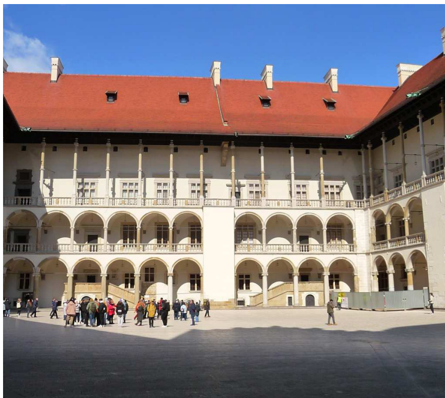
Fot. nr 52. Skrzydło północne. (18.03.2025)
