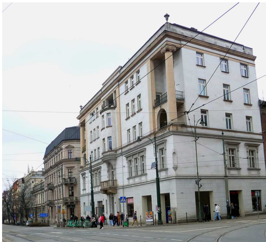
Fot. nr 173. Nadbudowana o trzy pietra kamienica z naroża ulic: Krowoderskiej i Basztowej 10. (01.03.2025)
