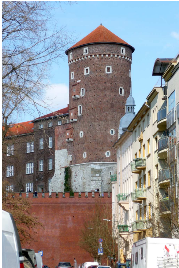
Fot. nr 4. Baszta Sandomierska w ujęciu z ulicy Smoczej. (18.03.2025)
