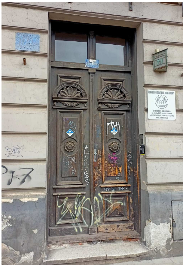
Fot. nr 187. Drzwi kamienicy z ulicy Dietla 71. (27.03.2025)
