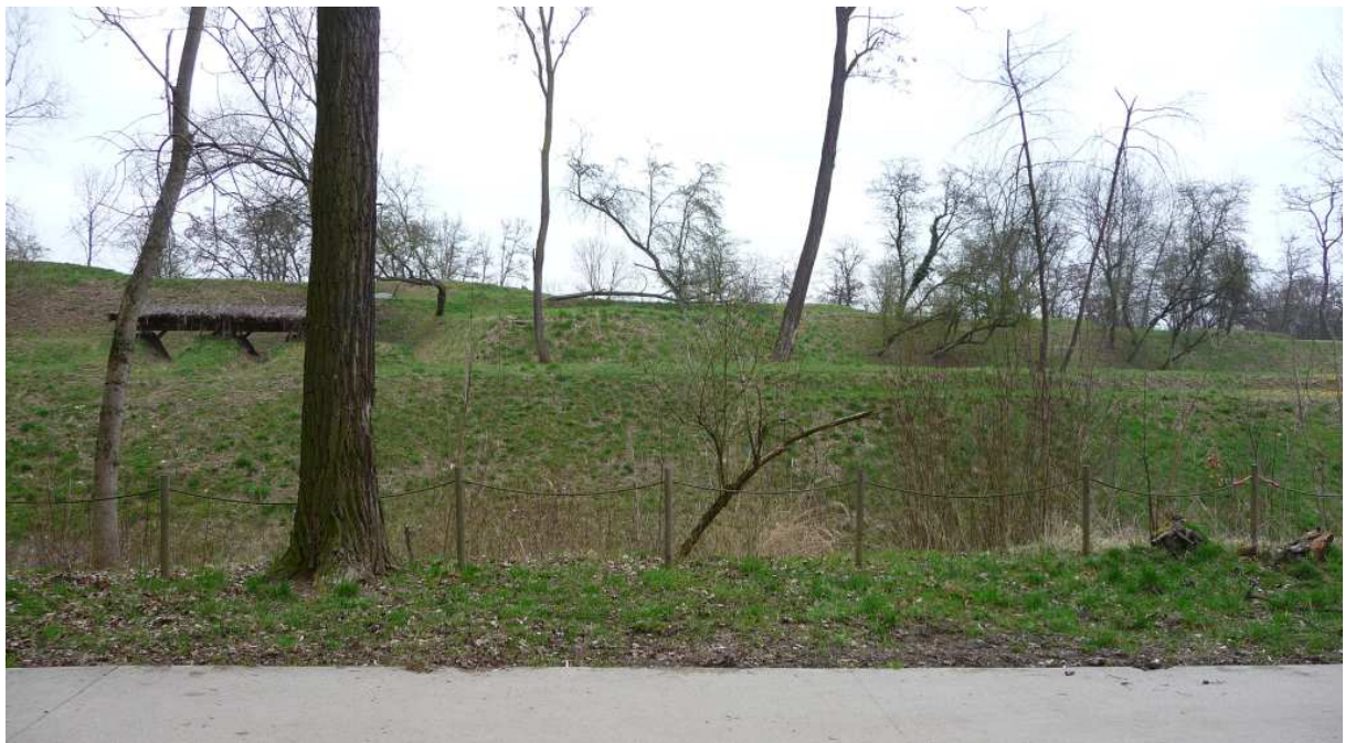
Fot. nr 377. Widok na wał główny. (28.03.2025)
