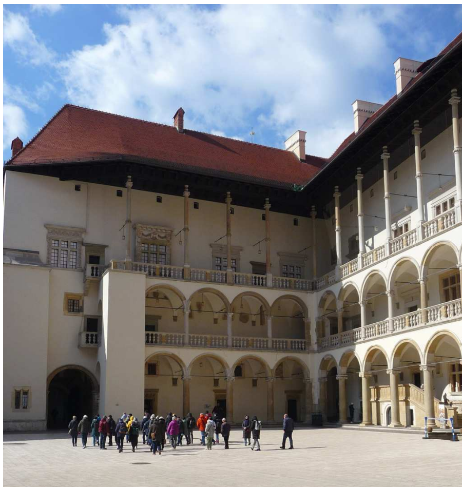
Fot. nr 51. Narożnik Północno-zachodni. (18.03.2025)
