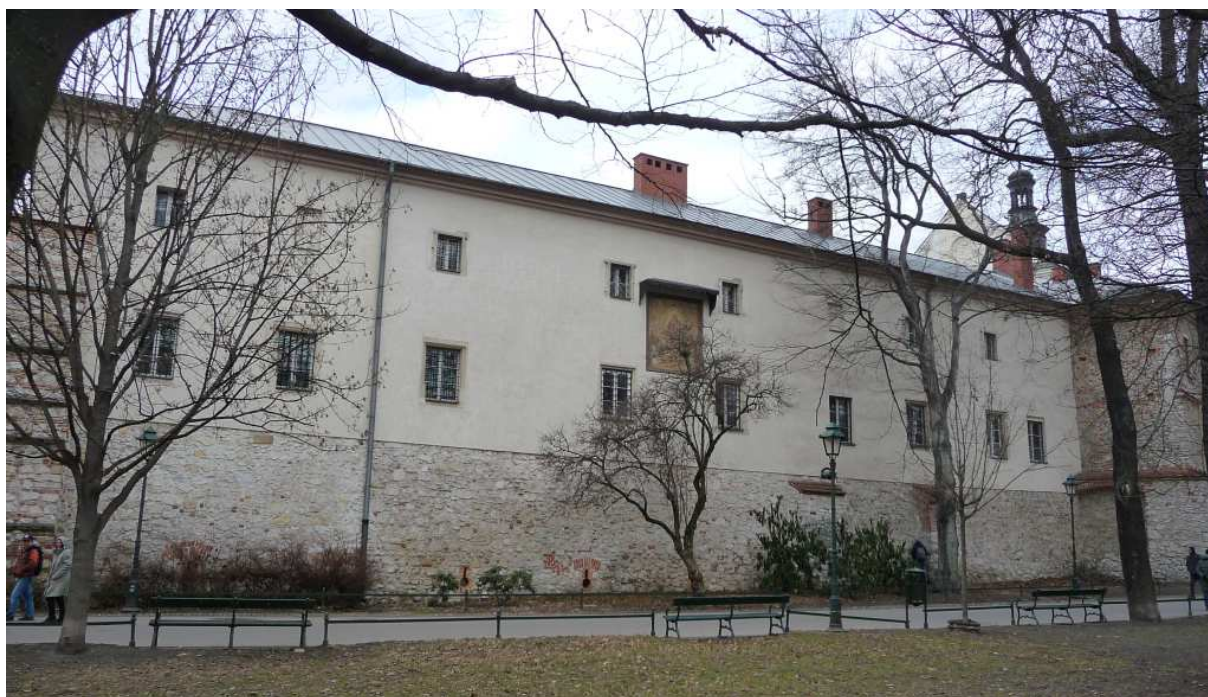
Fot. nr 76 (76-88). Wzdłuż Plant. Mur zewnętrzny klasztoru Dominikanek na Gródku. (03.03.2025)
