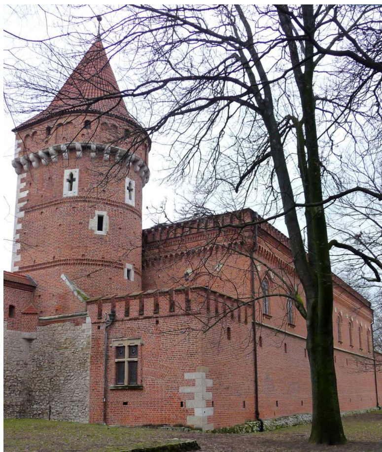
Fot. nr 86. Baszta Stolarska i arsenał miejski. (01.03.2025)
