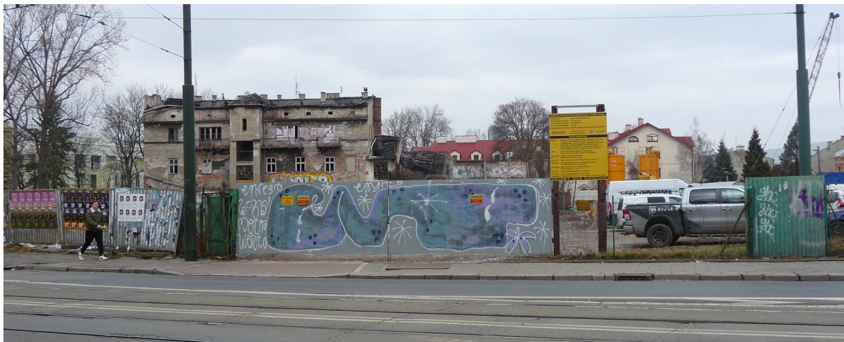
Fot. nr 192 (192-195). Ostatnie chwile zabudowy ulicy Grzegórzeckiej pod nr 32?. (03.03.2025)
