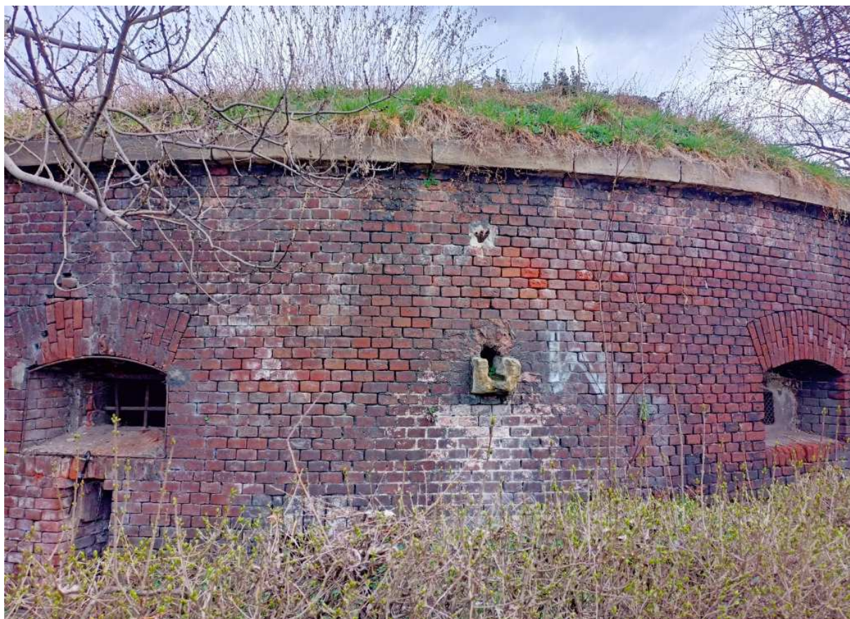
Fot. nr 156. Basteja przy wjeździe. (12.03.2025)
