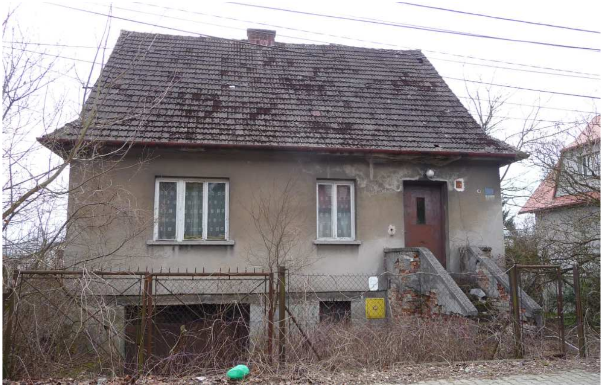
Fot. nr 394. Relikt powojennej zabudowy Klinów pod nr 17 (?). (28.03.2025)
