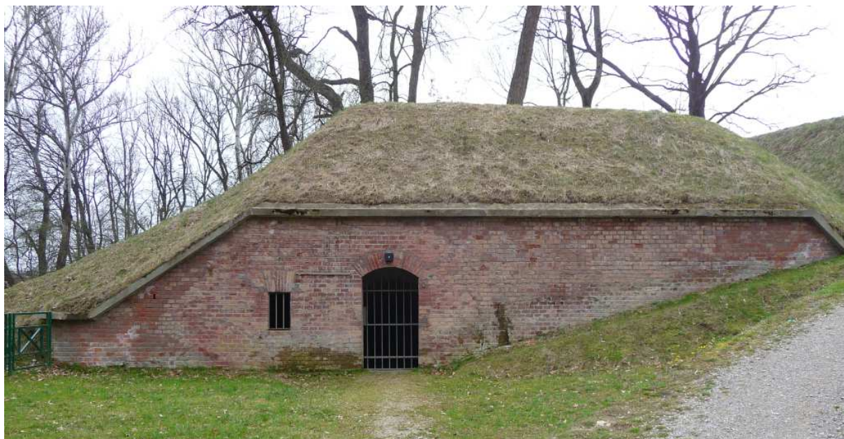
Fot. nr 380 (380-391). Stanowiska strzelnicze i schrony na wale górnym. Kaponiera barkowa w prawym fragmencie. (28.03.2025)
