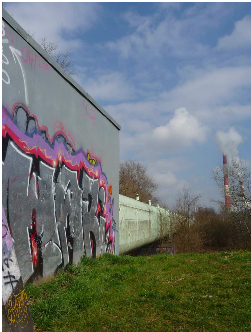
Fot. nr 303 (303-305). Fragment Płaszowa w sąsiedztwie ulicy Lasówka. Rurociąg ciepłowniczy, biegnący przez Wisłę z elektrociepłowni w Łęgu. (25.03.2025)
