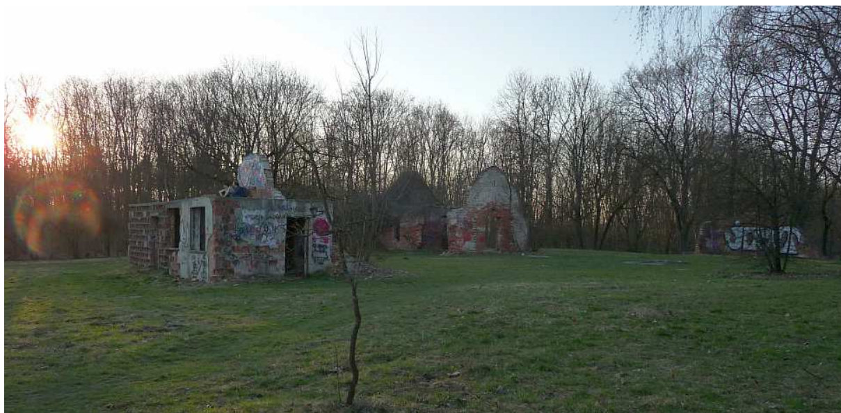
Fot. nr 275. Ruina starej prochowni na skraju ulicy Swoszowickiej. (20.03.2025)
