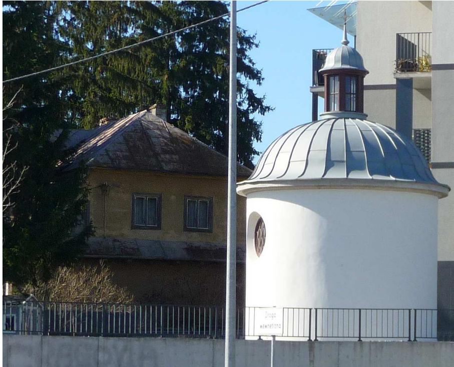
Fot. nr 436 (435-439). Kapliczka w kształcie rotundy w początkowym fragmencie ulicy. (19.03.2025)
