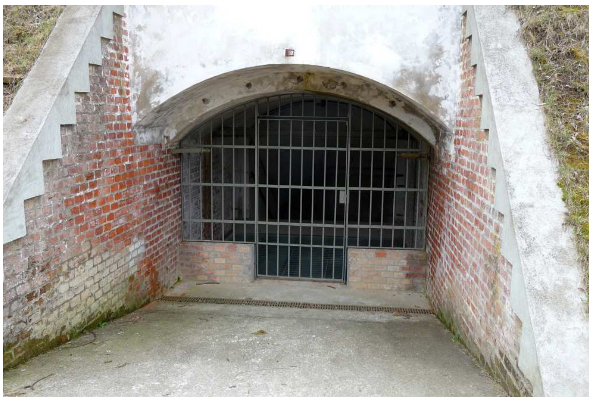
Fot. nr 381. Wejście do schronu. (28.03.2025)
