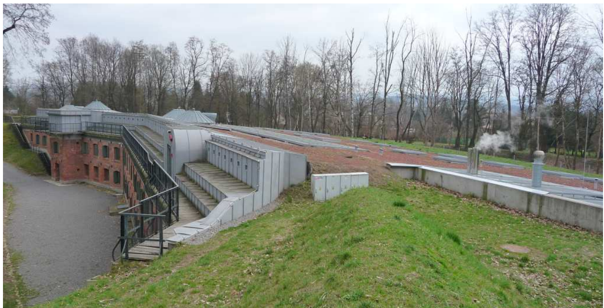
Fot. nr 397 (397-400). Zrewitalizowane koszary szyjowe, a w wale górnym schrony. (28.03.2025)
