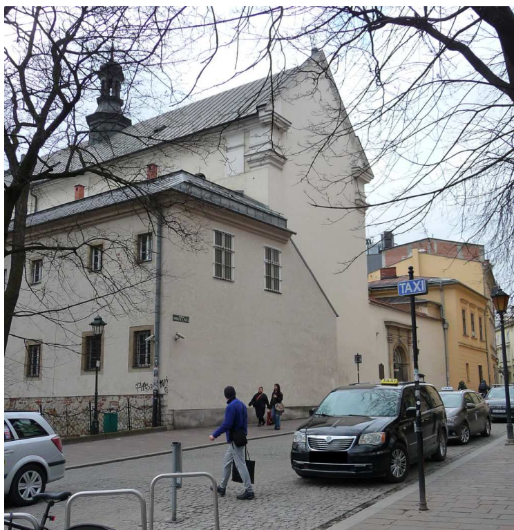
Fot. nr 78. Wzdłuż ulicy Mikołajskiej. (03.03.2025)
