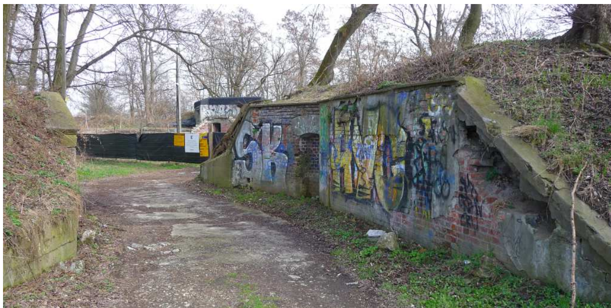
Fot. nr 317 (317-319). Fort Lasówka nr 50a na etapie przeciągającego się remontu. Wjazd do fortu. (25.03.2025)
