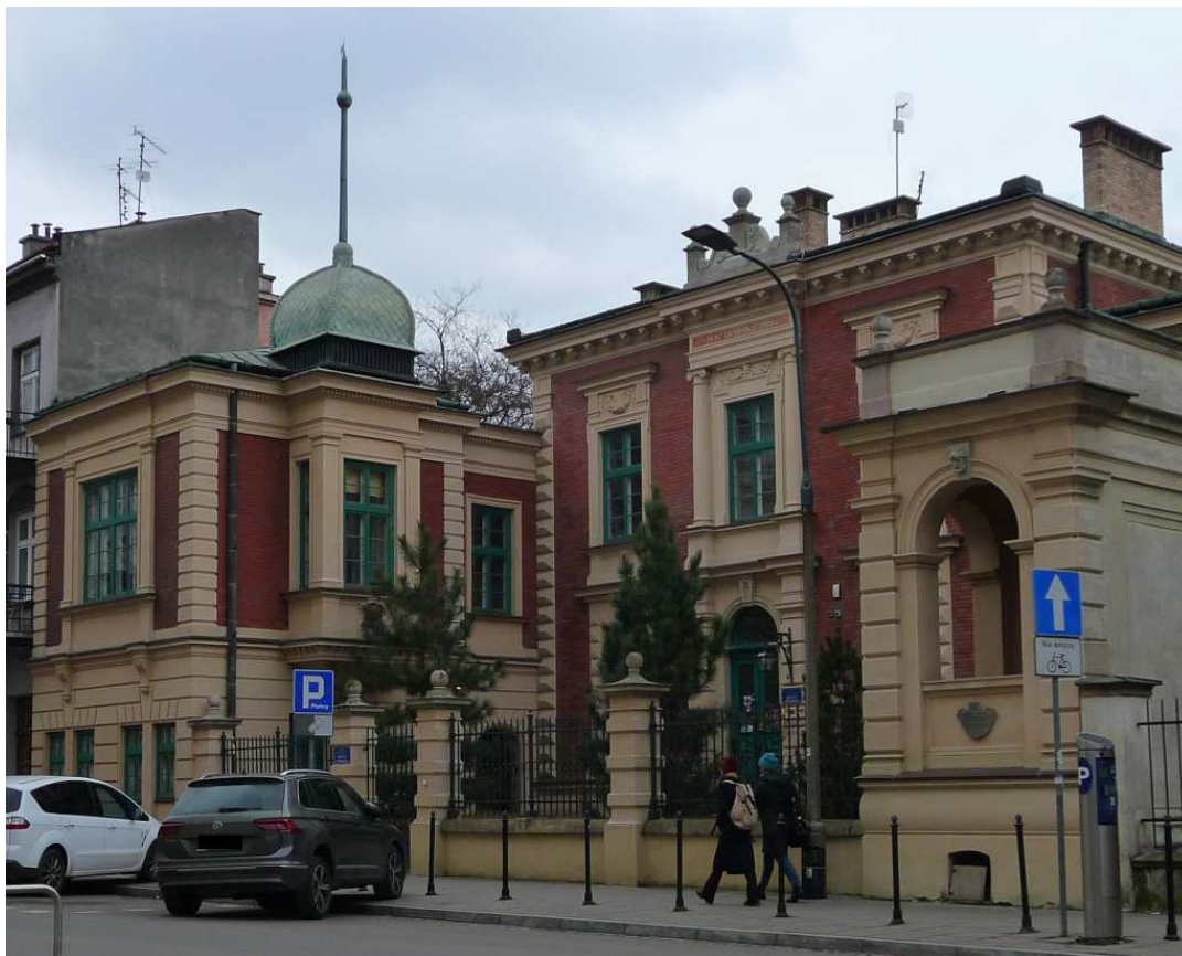
Fot. nr 109. Willa Pod Stańczykiem pod 12. (01.03.2025)
