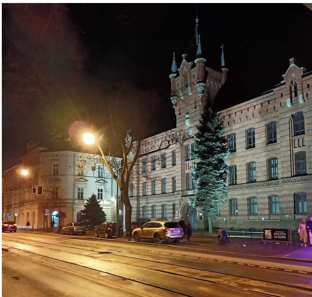
Fot. nr 178. Siedziba dawnej straży ogniowej, dziś Państwowej Straży Pożarnej, przy ulicy Westerplatte 19. (23.03.2025)
