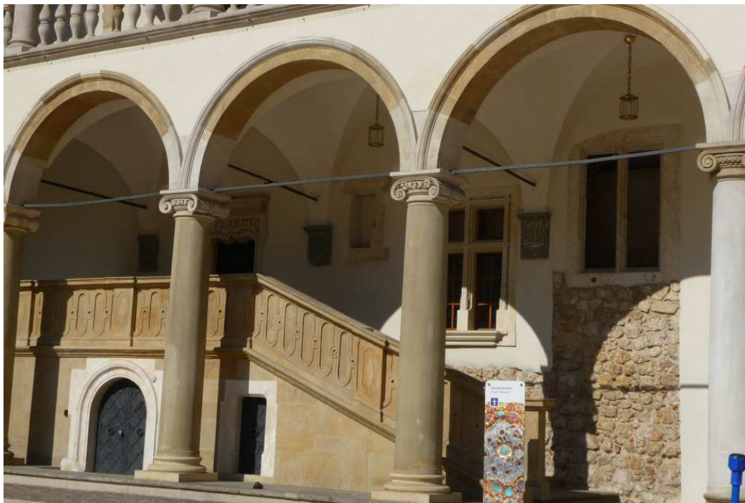
Fot. nr 53. Gotyckie detale w północnym skrzydle zamku. (18.03.2025)
