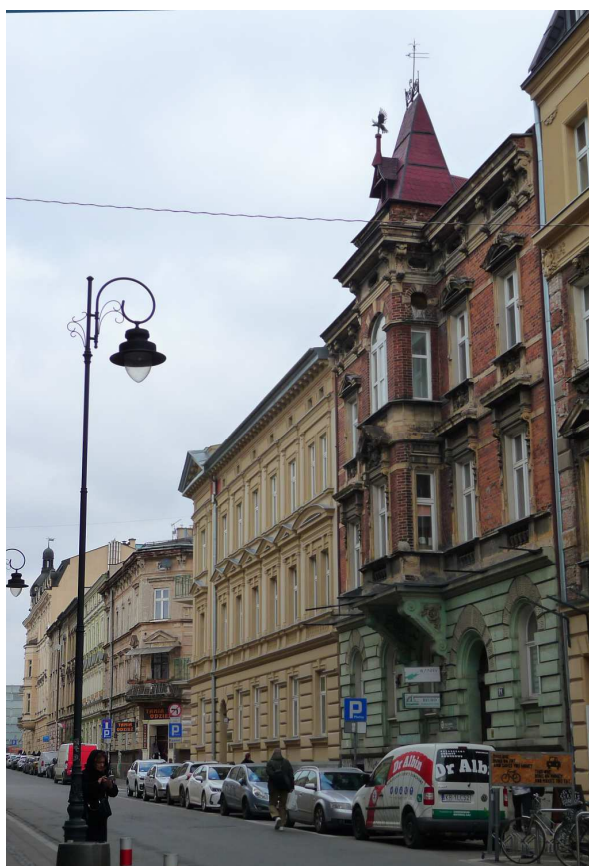
Fot. nr 182. Fragment zabudowy pow. eklektycznej kamienicy pod nr 21. (03.03.2025)
