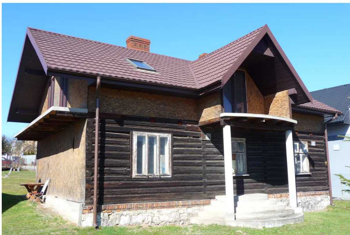
Fot. nr 443 (443-444). Około 90-letni dom pod nr 20 na etapie przebudowy. (19.03.2025)
