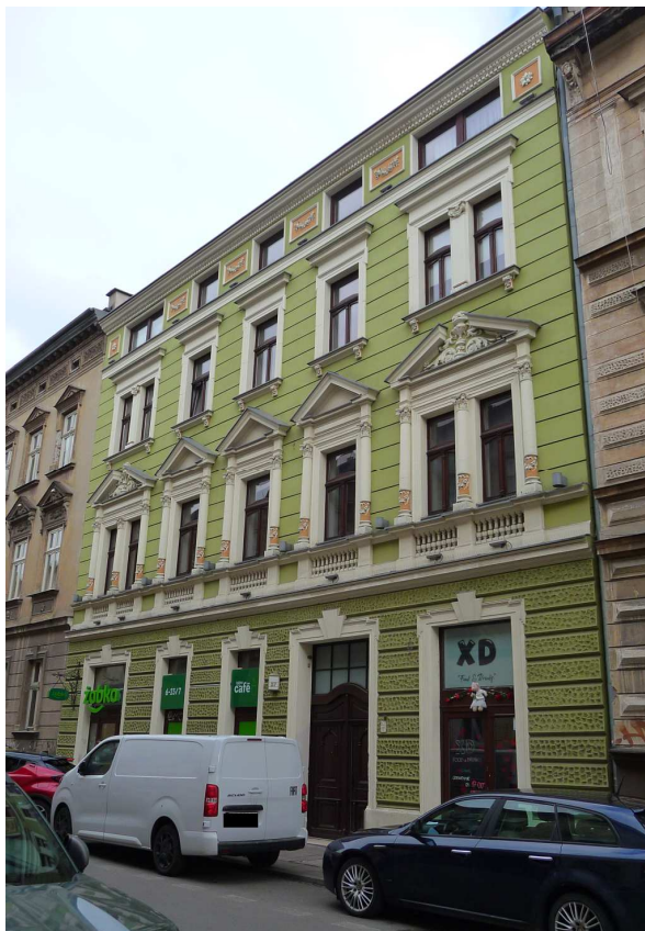
Fot. nr 183. Odnowiona kamienica pod nr 27. (03.03.2025)
