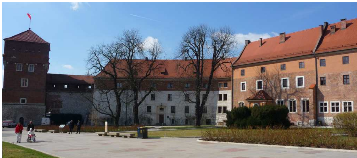
Fot. nr 36. Północno-zachodni narożnik. (18.03.2025)
