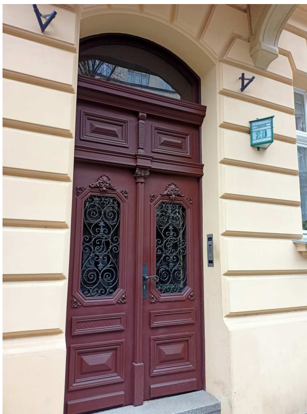
Fot. nr 188. Odnowione drzwi czynszówki z ulicy Sarego 20. (27.03.2025)
