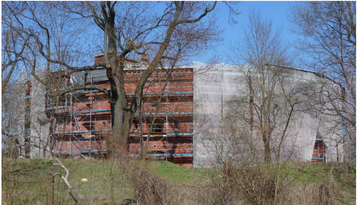
Fot. nr 232. Fort nr 31 – św. Benedykt na etapie remontu. (22.03.2025)
