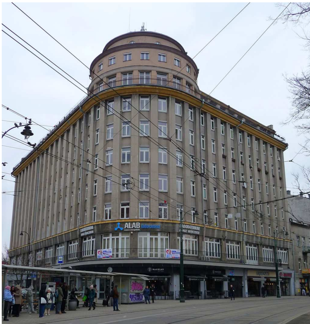
Fot. nr 175. Ponad 90-letni gmach TU Feniks przy ulicy Basztowej 15. (01.03.2025)
