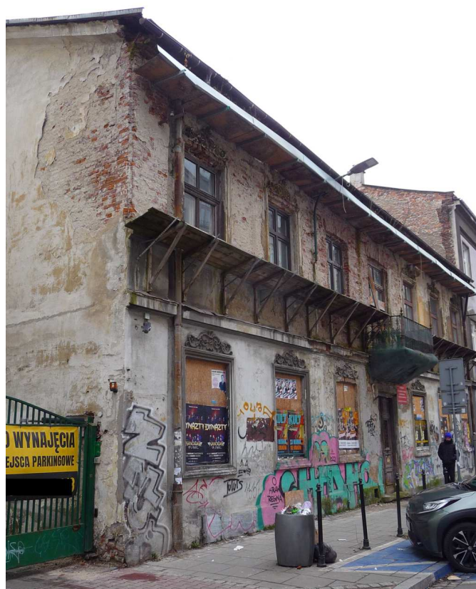
Fot. nr 110. Zrujnowany od lat dom pod nr 8. (01.03.2025)
