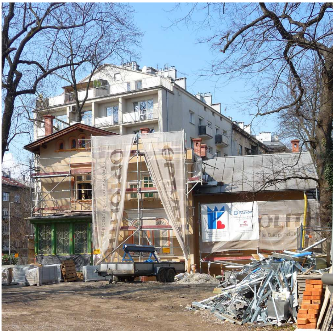
Fot. nr 119 (119-120). Kossakówka przy placu Kossaka 4 na etapie remontu. (28.03.2025)
