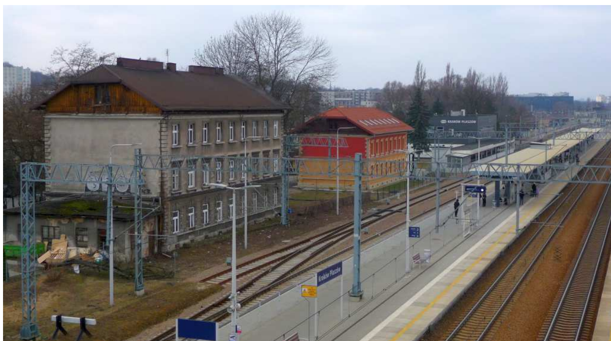
Fot. nr 297 (297-300). Panoramy z fragmentu estakady tramwajowej przy dworcu kolejowym w Płaszowie. Budynki przy stacji Kraków Płaszów. (02.03.2025)
