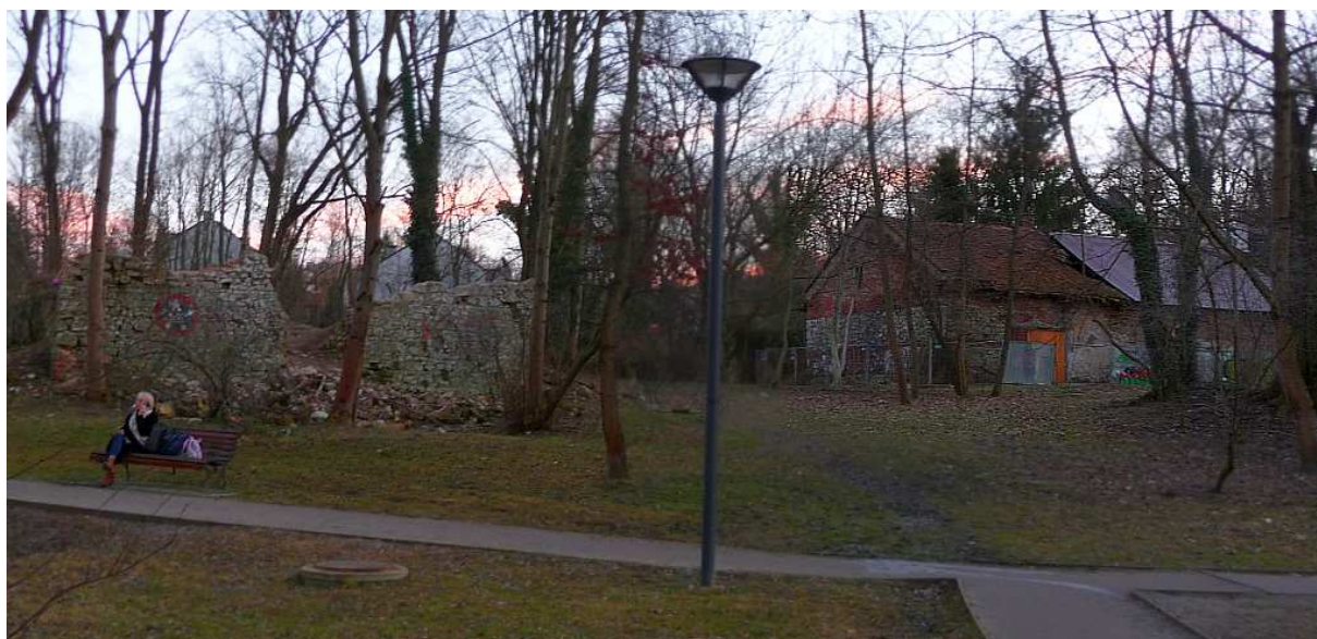
Fot. nr 335 (335-336). Stary dwór Bemów i ruina budynku gospodarczego. (07.03.2025)
