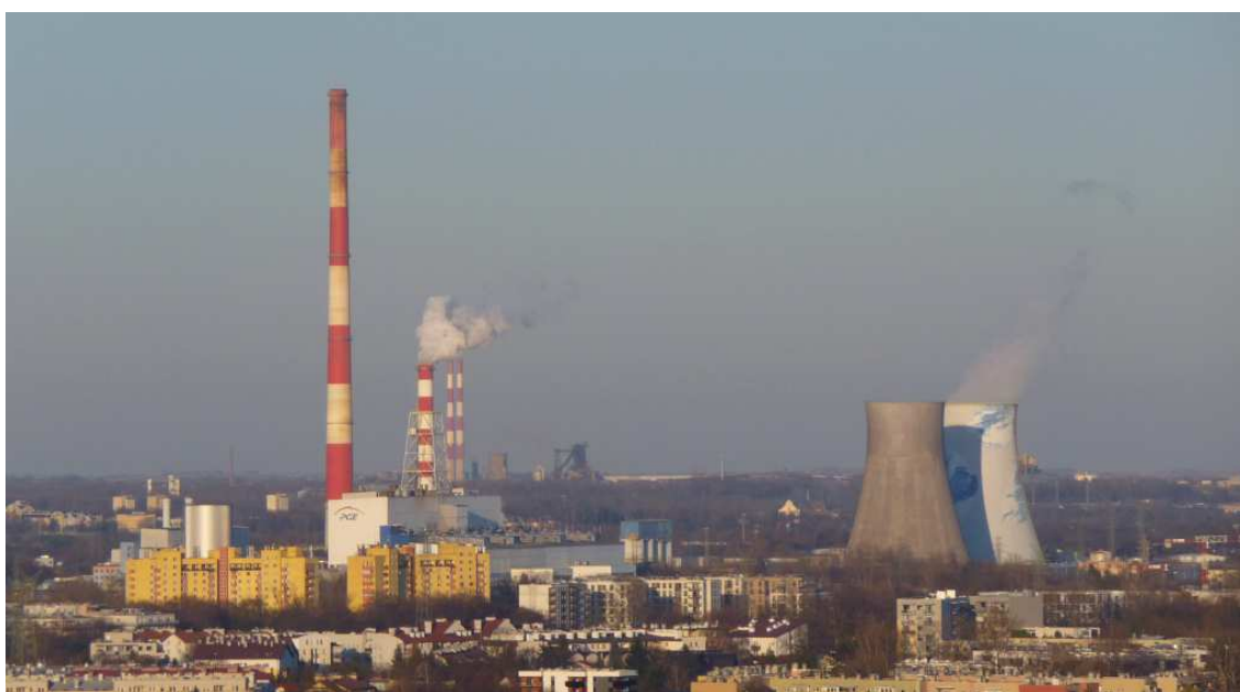
Fot. nr 267. Kominy elektrociepłowni w Łęgu. (20.03.2025)
