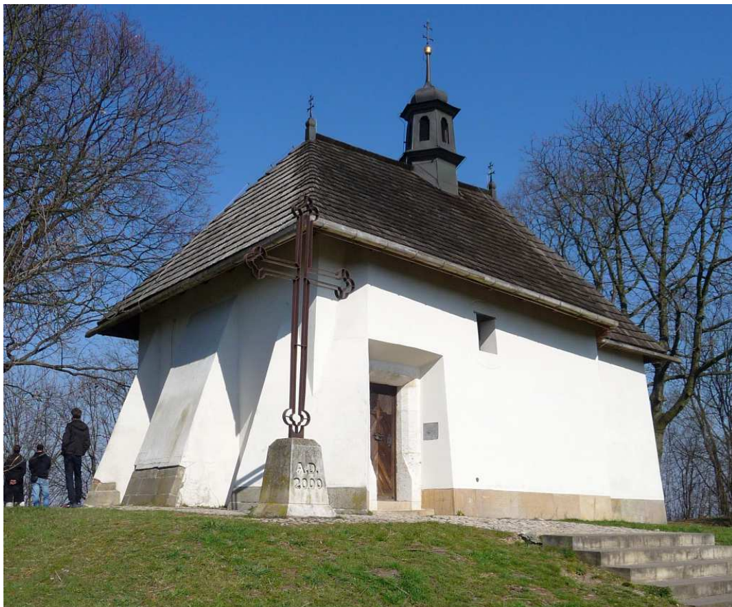
Fot. nr 233 (233-234). Kościółek św. Benedykta. (22.03.2025)
