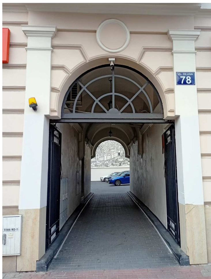
Fot. nr 163 (163-172). Wzdłuż ulicy Długiej. Sień kamienicy pod nr 78. (12.03.2025)
