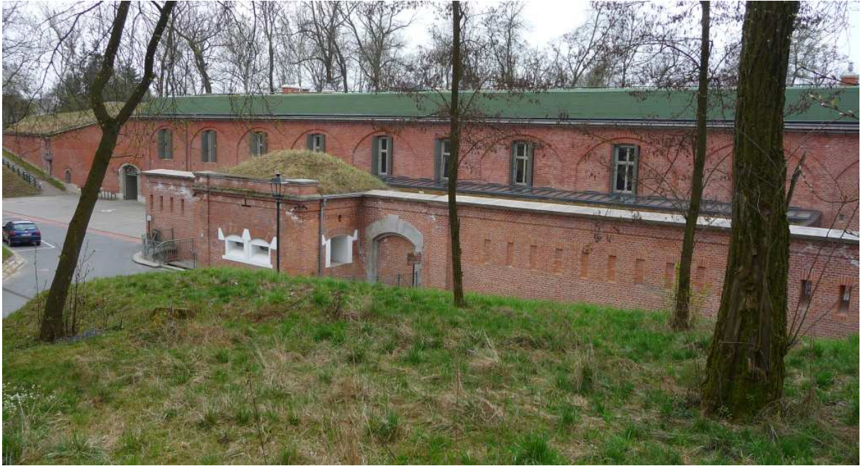
Fot. nr 364 (364-370). Koszary szyjowe od strony wjazdu do fortu. (28.03.2025)
