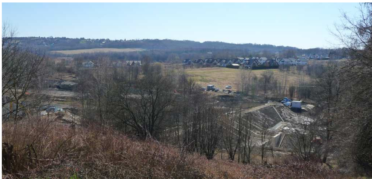
Fot. nr 460. Widok na dolinę Malinówki poniżej ulicy Modrzewiowej, gdzie również trwają prace hydrotechniczne. (19.03.2025)
