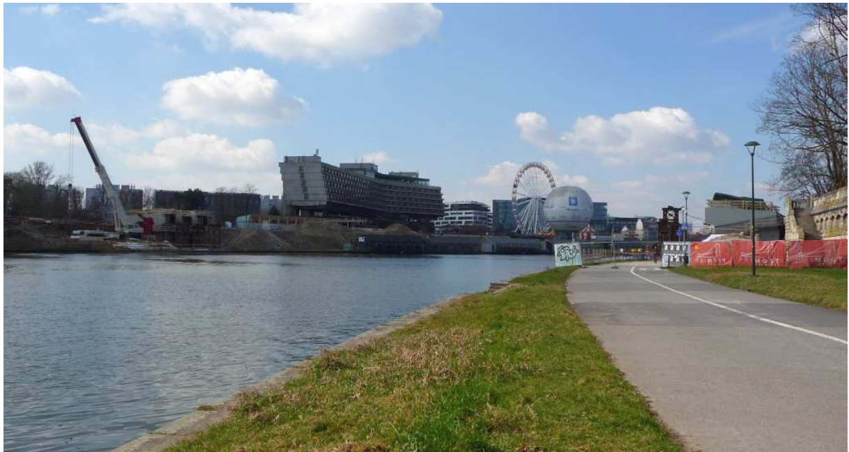
Fot. nr 224 (224-225). Widoki na Ludwinów i powstającą kładkę ludwinowską. (18.03.2025)
