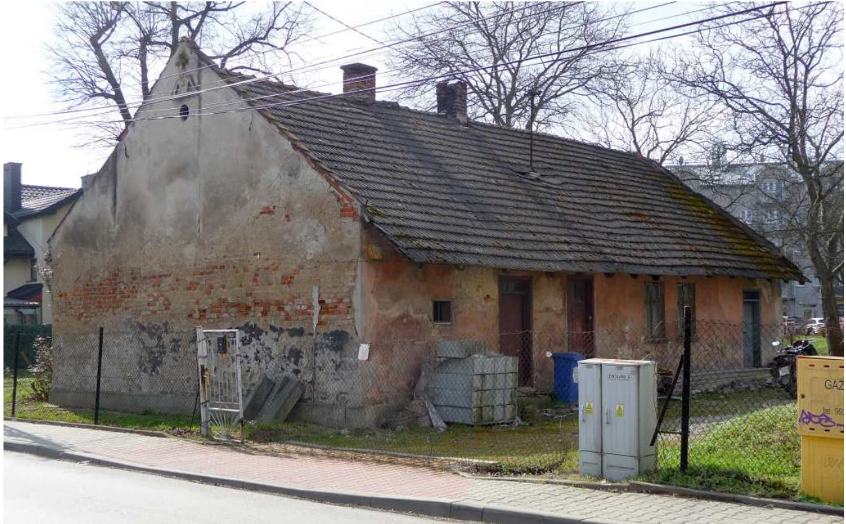
Fot. nr 309 (309-310). Murowana chałupa z roku 1912 z ulicy Koszykarskiej 16. Fragment od strony podwórka. (25.03.2025)
