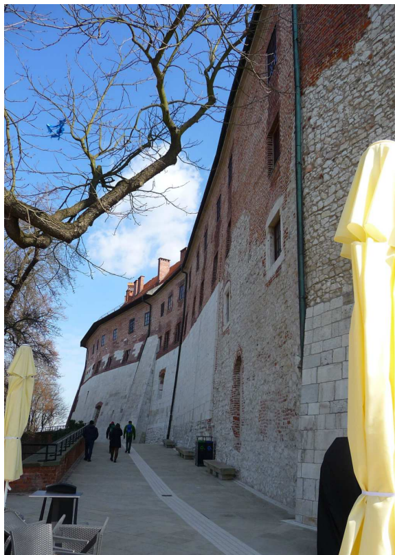
Fot. nr 25 (25-28). Fragment północnej pierzei z budynkami kanoników katedralnych. (18.03.2025)
