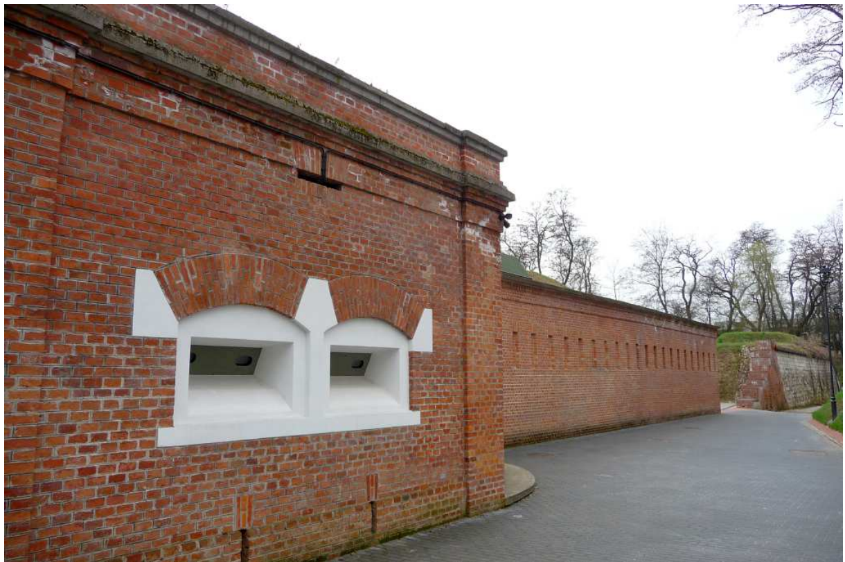
Fot. nr 366 (366-368). Plac broni i centralna kaponiera. (28.03.2025)
