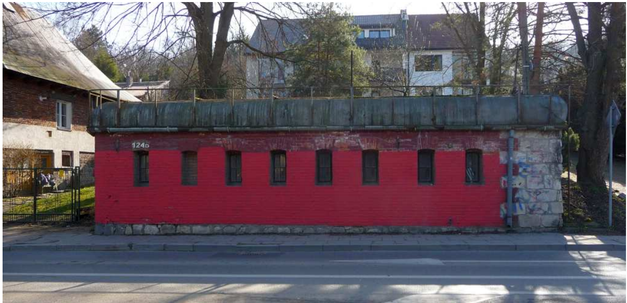
Fot. nr 152. Schron amunicyjny w dawnej bramie Wola Justowska przy ulicy Królowej Jadwigi 124, u wylotu ulicy Piastowskiej. (08.03.2025)
