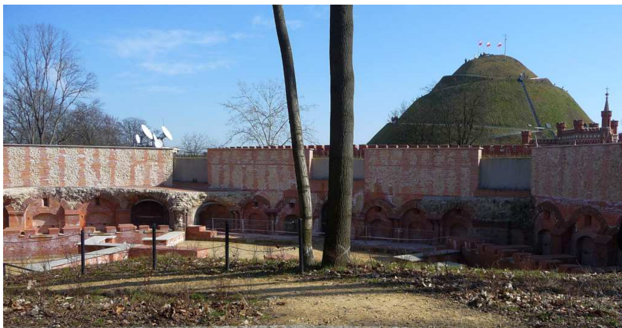
Fot. nr 131. Kaponiera między bastionami: II i III. (08.03.2025)
