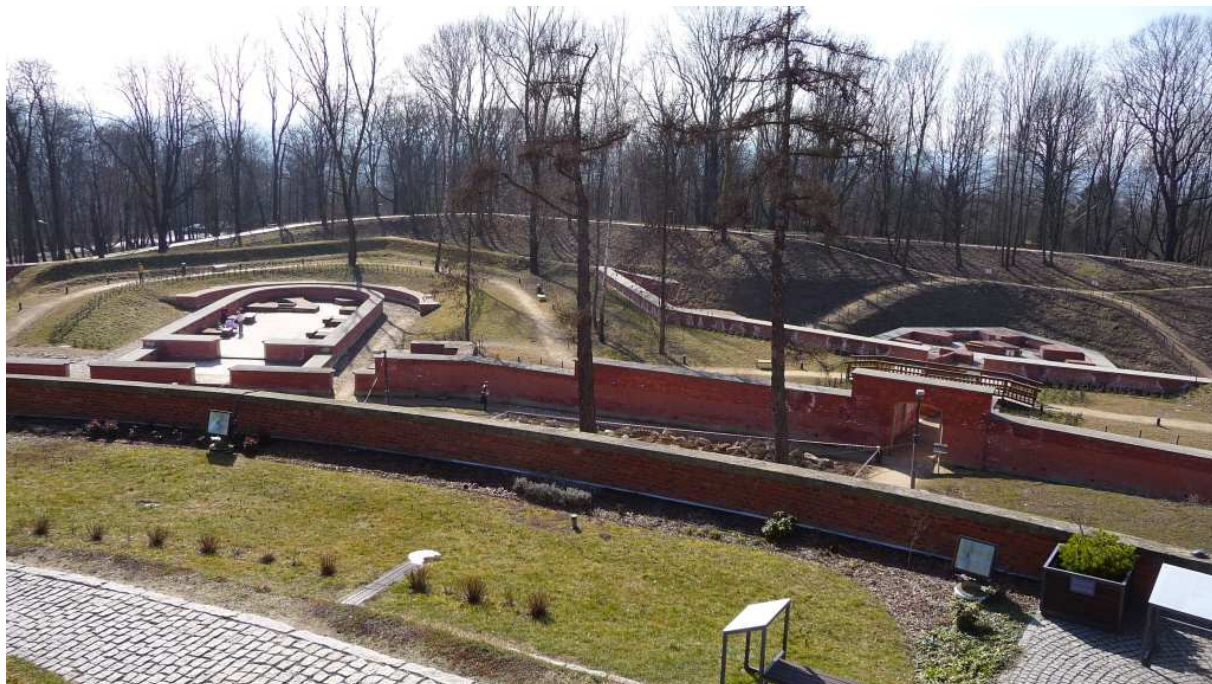
Fot. nr 128 (128-129). Bastion nr I i kaponiera pomiędzy bastionami I i II. (08.03.2025)
