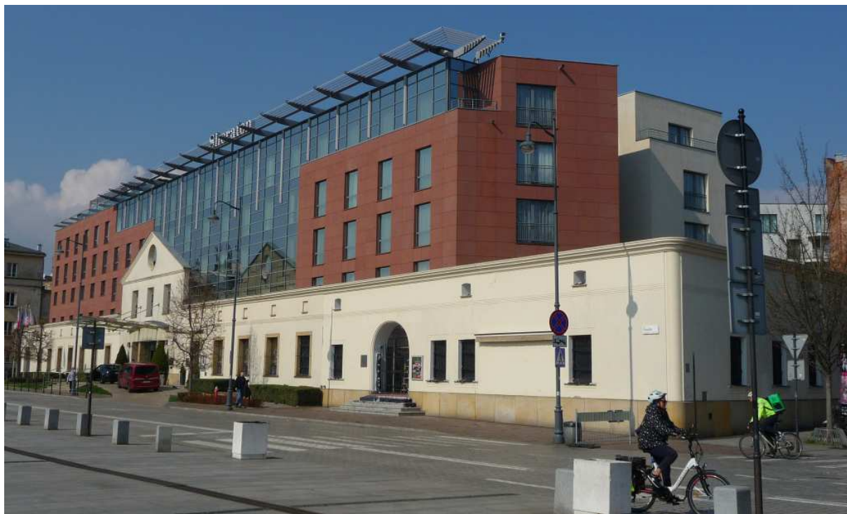
Fot. nr 115. Hotel Sheraton przy ulicy Powiśle. (28.03.2025)
