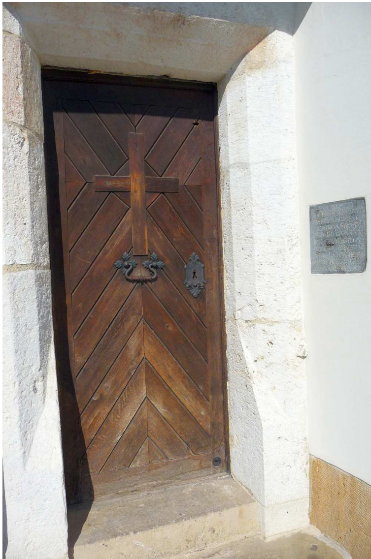
Fot. nr 234. Archaiczne drzwi. (22.03.2025)
