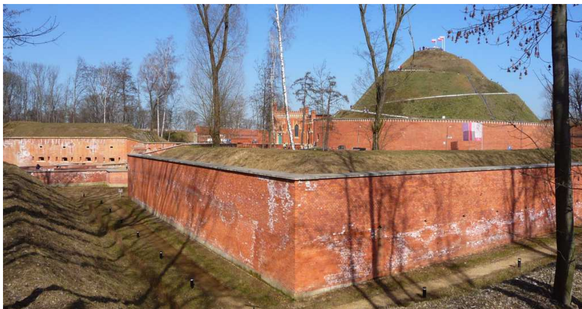
Fot. nr 127 (127-135). Częściowo zrekonstruowany zachodni fragment fortu. Całkowicie odtworzony mur oporowy bastionu nr I. (08.03.2025)
