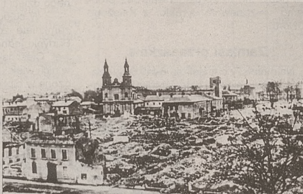
Gruzowisko po budynkach zbombardowanych 1 września 1939 r. Zdjęcie wykonane w marcu 1940 roku.
