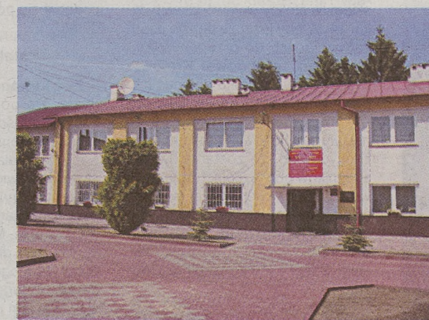
150-letni budynek CKU w Jasięcu od niedawna ma nową elewację.
