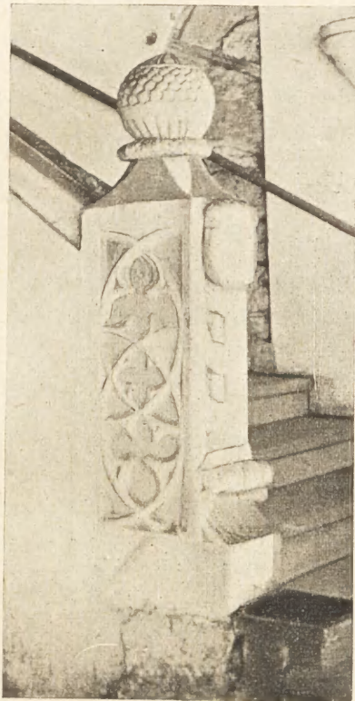
Fig. 36. Słupek gotycki przy schodach na I piętro.
