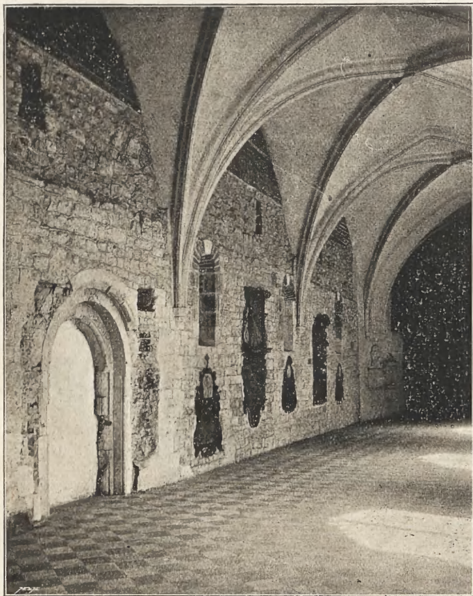
Fig. 18. Widok ściany romańskiej refektarza od zewnątrz.
