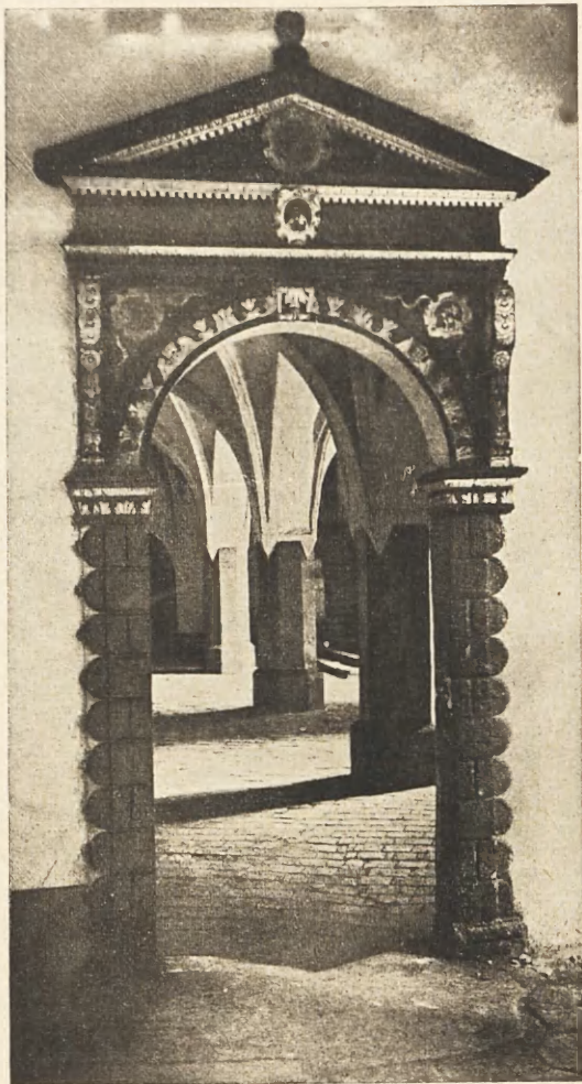
Fig. 37. Odrzwia zewnętrzne w północnej ścianie sieni gotyckiej.
