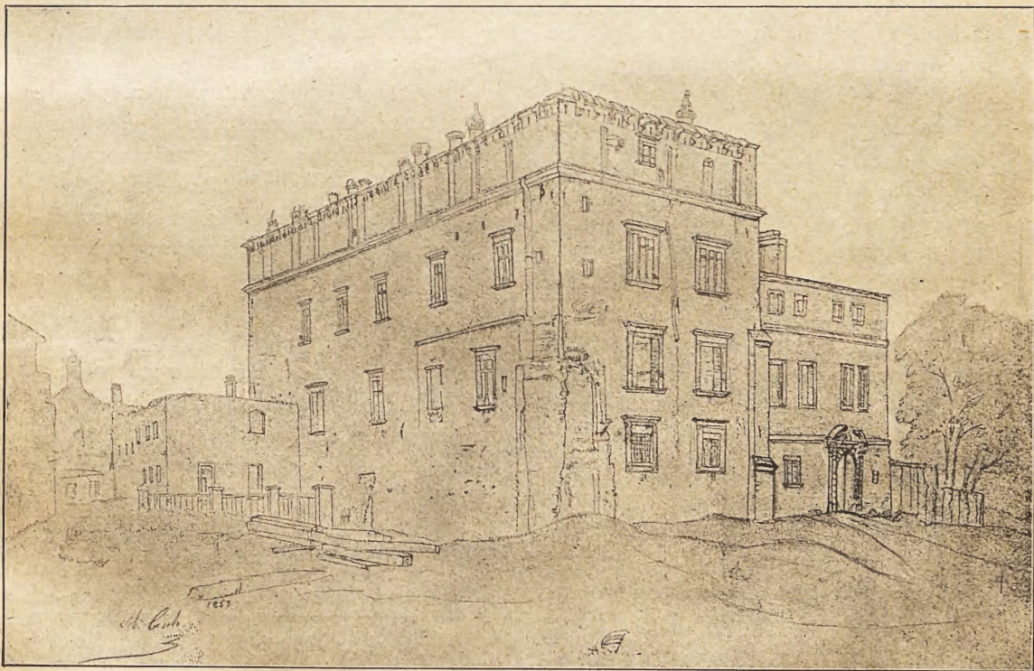
Fig. 6. Pałac Wielopolskich po pożarze, od północnego wschodu, (Rys. M. Cerchy z r. 1853. Własność autora)
