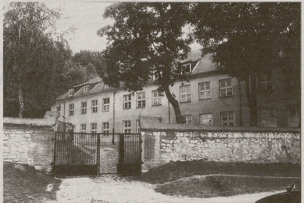
Wymagająca remontu siedziba szkoły podstawowej, gimnazjum i liceum w Kazimierzu Dolnym
