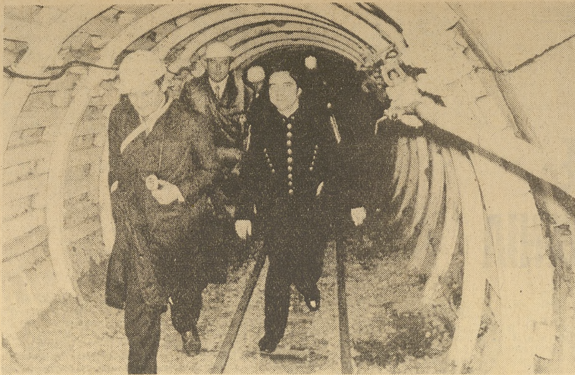
W kopalni ćwiczebnej uczniów Zasadniczej Szkoły Górniczej KWK „Makoszowy” w Zabrze. Na pierwszym planie dyrektor ZSG — kol. Fryderyk Niemiec.
