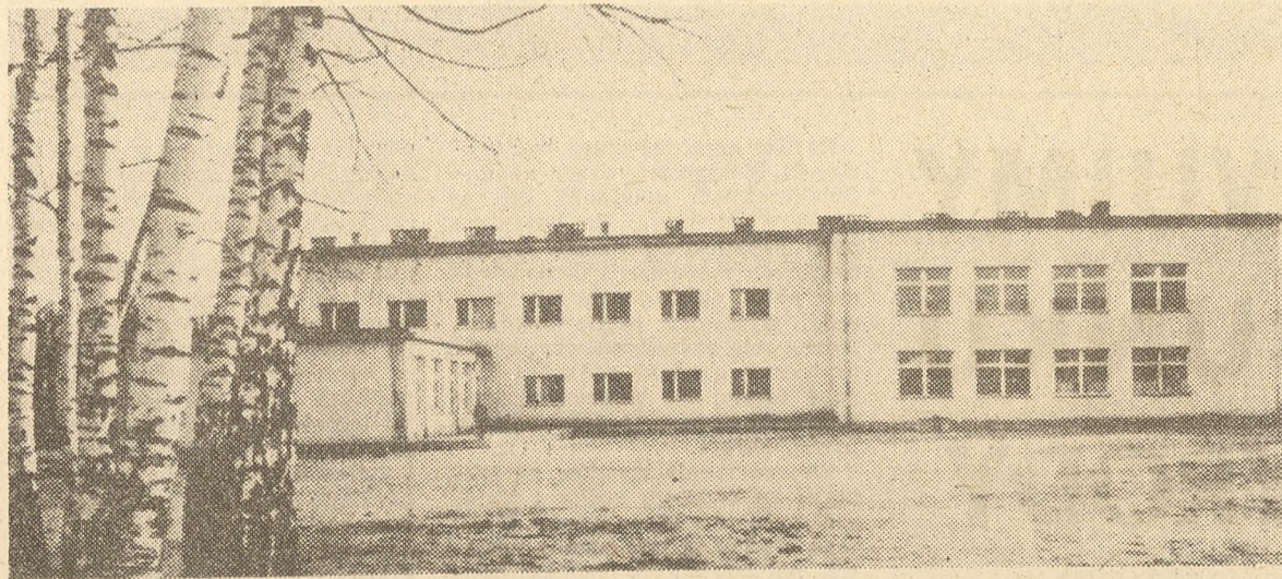
Tysiąclatka w Bielniech — jedna ze 101 szkół, wybudowanych przed 1966 r. w województwie rzeszowskim.
