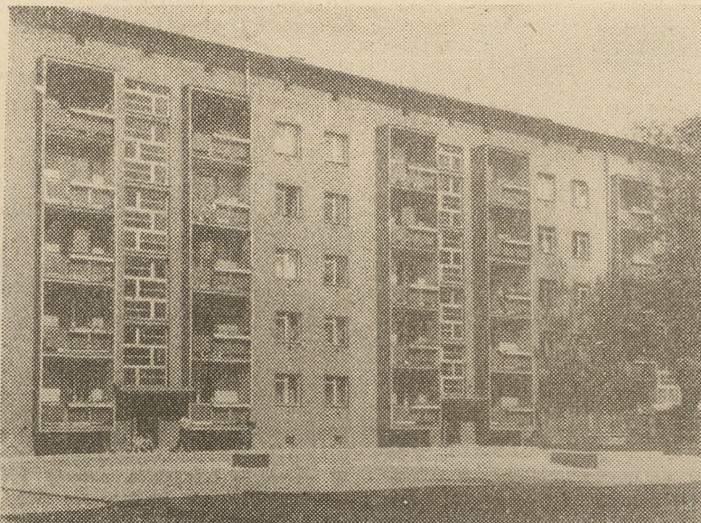
Pierwsze „dziecko” Spółdzielni „Znicz”, budynek przy ul. Libelta, oddany do użytku w 1962 roku Foto: P. Wiszniewski
