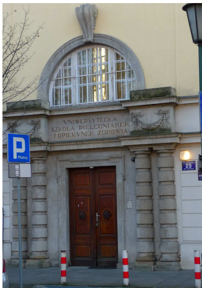
Fot. nr 77. Portal wejściowy. (29.12.2024)
