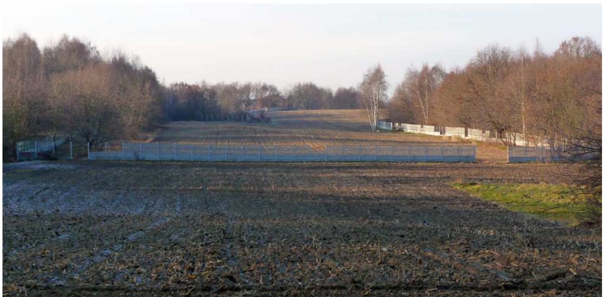
Fot. nr 321 (320-323). Ciągłe wygrodzona centralna połąć. (03.12.2024)
