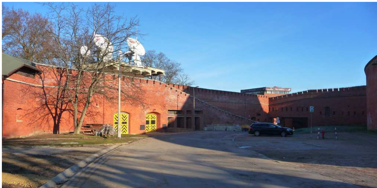
Fot. nr 246. Bastion nr III – widok z wewnątrz. (26.12.2024)
