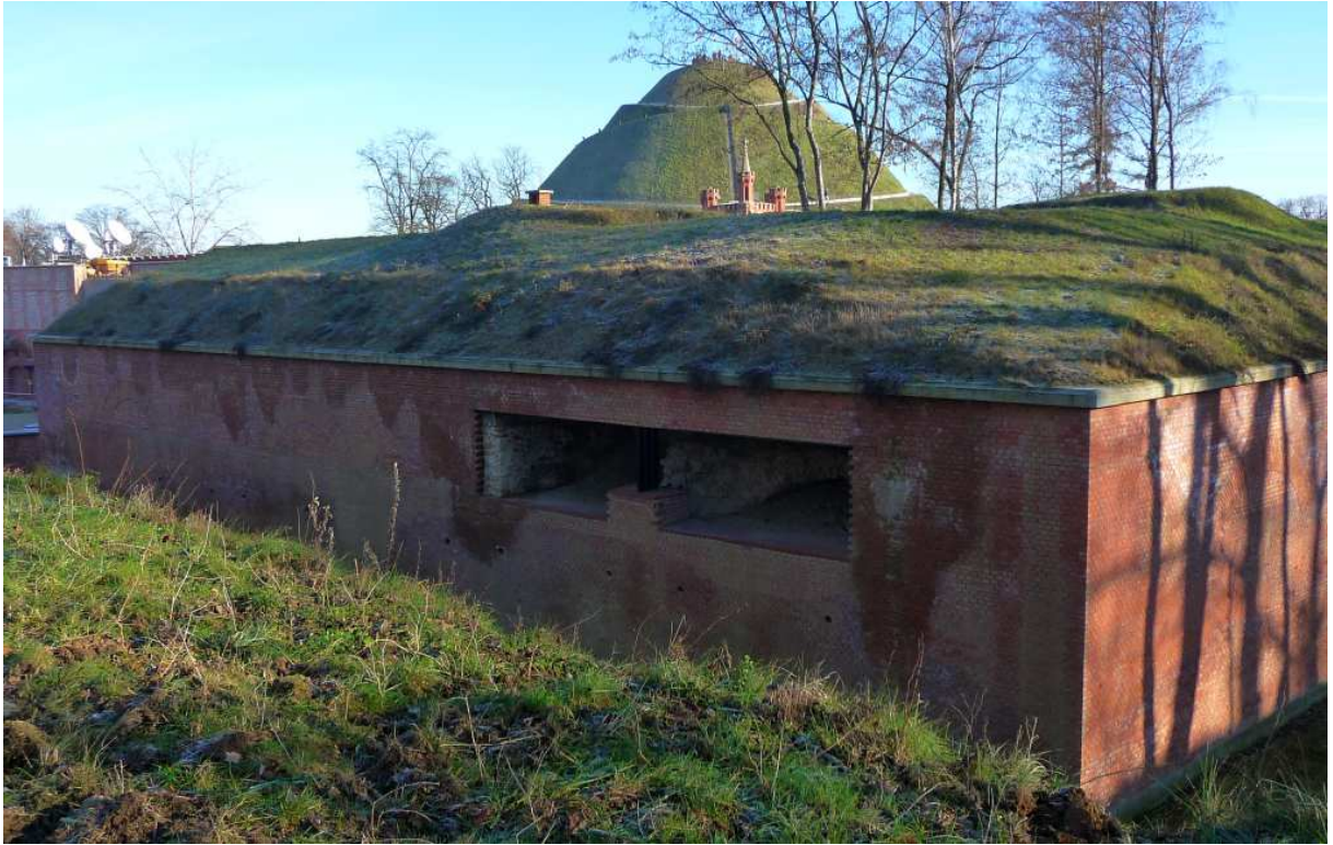
Fot. nr 236. Detale schronu głównego. (26.12.2024)
