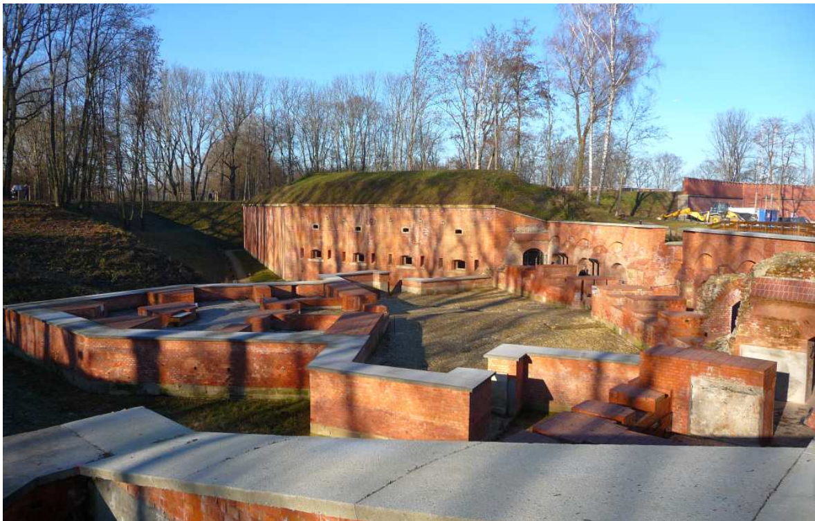
Fot. nr 231 (231-234). Zrekonstruowana do poziomu przyziemia kaponiera pomiędzy bastionami nr: I i II (w tle). (26.12.2024)
