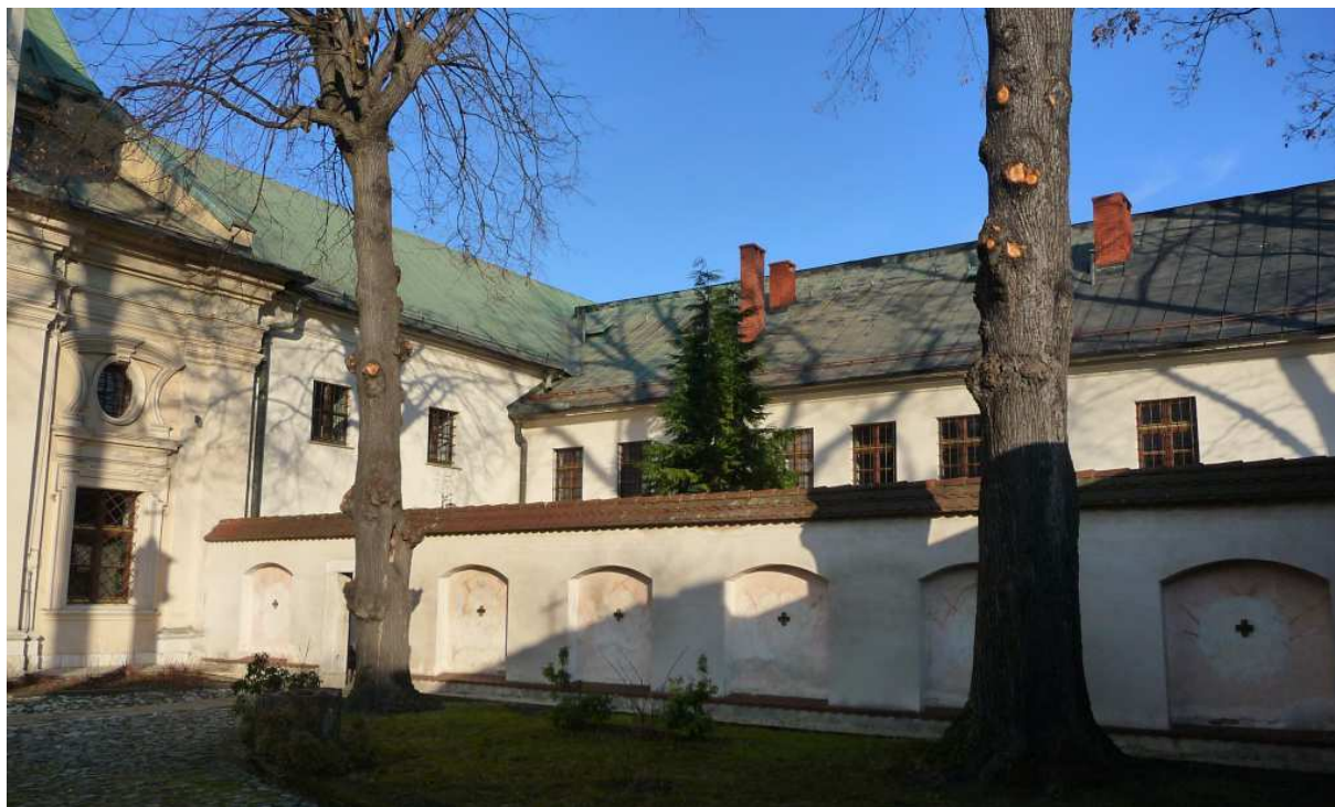
Fot. nr 83. Południowy budynek klasztorny. (29.12.2024)
