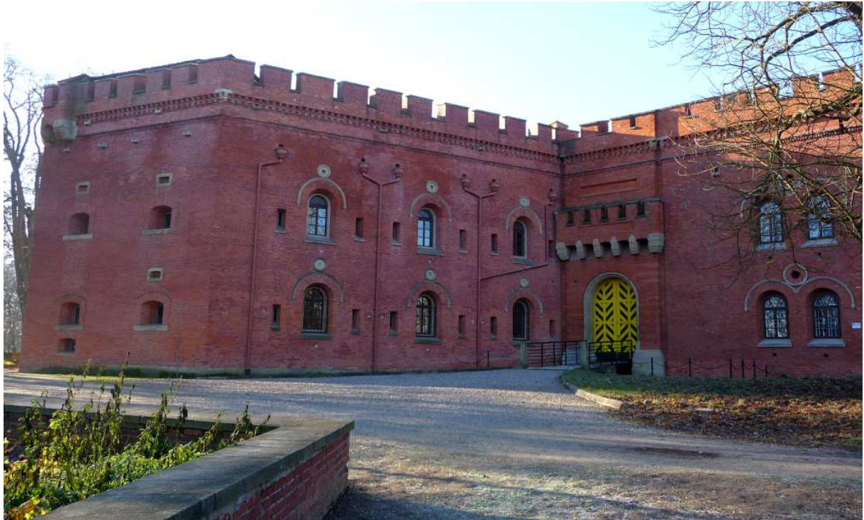
Fot. nr 257 (257-261). Bastion nr V. (26.12.2024)
