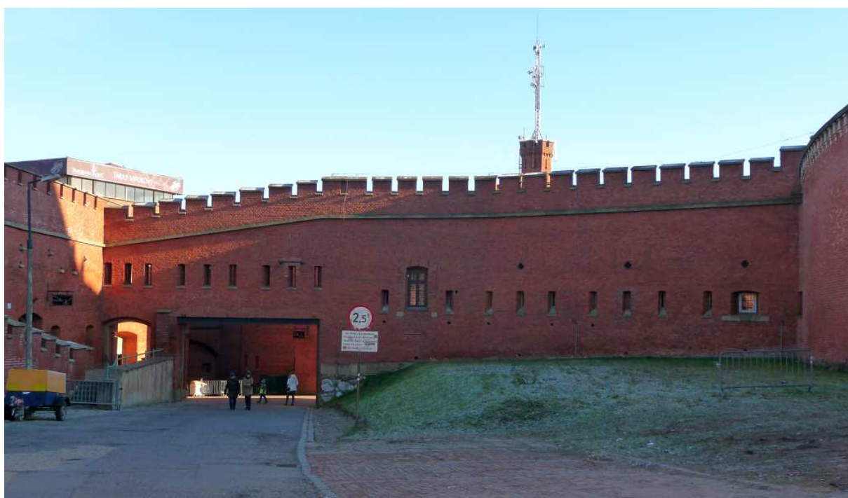
Fot. nr 247. Kaponiera wewnętrzna przy bramie wjazdowej na dziedziniec koszar. (26.12.2024)
