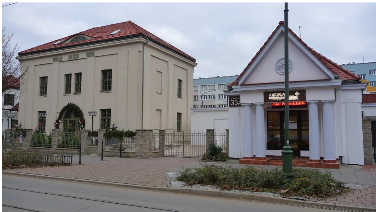
Fot. nr 142. Zabudowa ulicy Rakowickiej pod nr: 33 (kiosk z końca XIX wieku) i 35 (willa Olsza z roku 1928) (24.12.2024)
