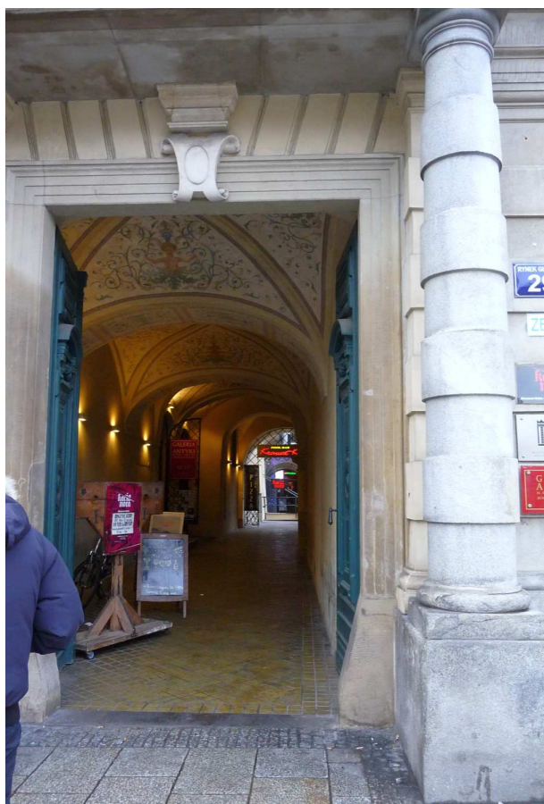
Fot. nr 36 (36-38). Detale kamienicy Pod Blachą pod nr 29. (07.12.2024)
