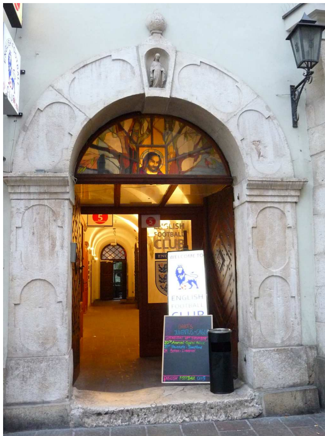
Fot. nr 12. Sień kamienicy pod nr 5. (18.12.2024)
