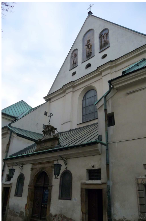
Fot. nr 55 (55-56). Fasada i kruchta kościoła Reformatów. (07.12.2024)
