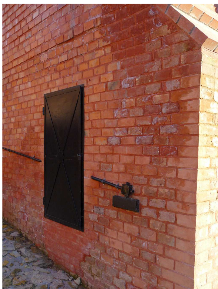
Fot. nr 229 (229-230). Detale wnętrza. (26.12.2024)
