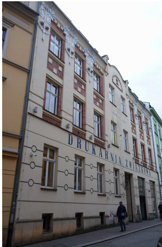
Fot. nr 9. Zdobiona motywami secesyjnymi fasada Drukarni Związkowej przy ulicy Mikołajskiej 13. (18.12.2024)
