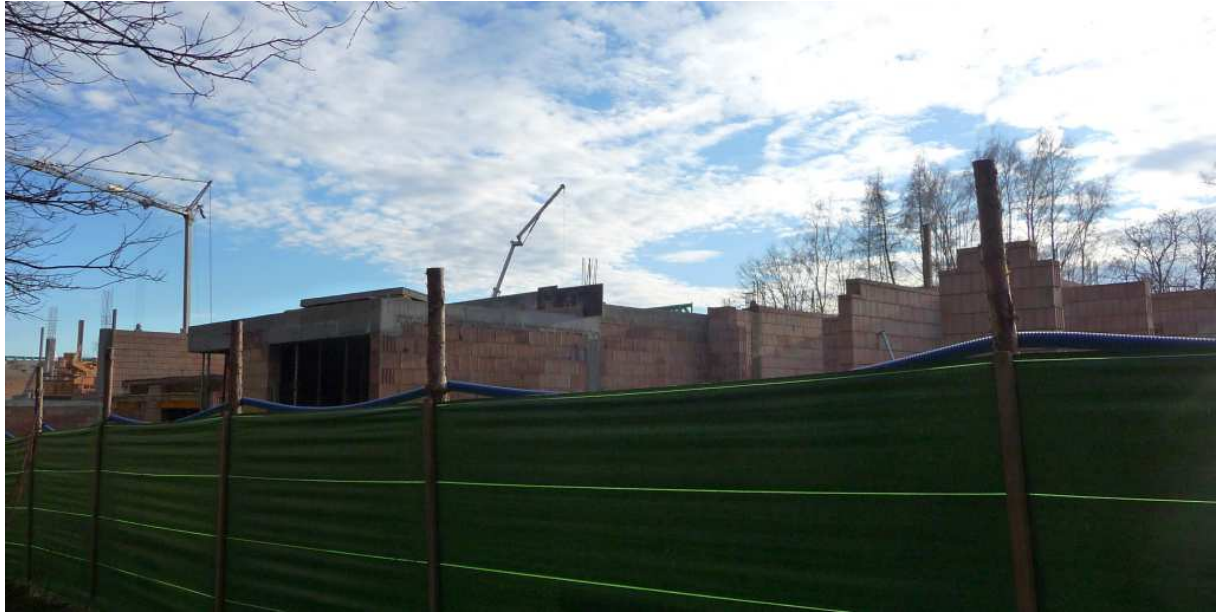
Fot. nr 325. Rośnie betonowa zabudowa obrzeża Użytku od strony ulicy Kosocickiej. (18.12.2024)
