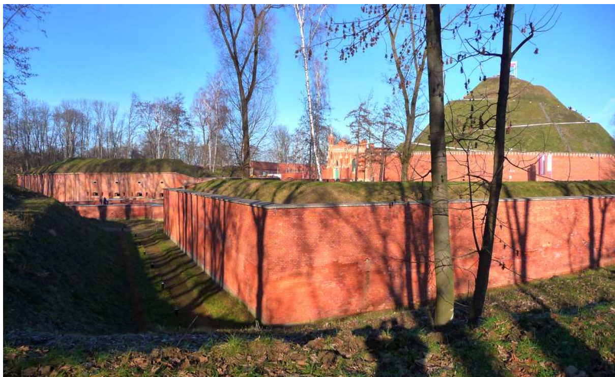
Fot. nr 222 (221-230). Częściowo zrekonstruowany bastion nr I, który po II wojnie uległ splantowaniu. Wybudowane od nowu mur oporowy. (26.12.2024)
