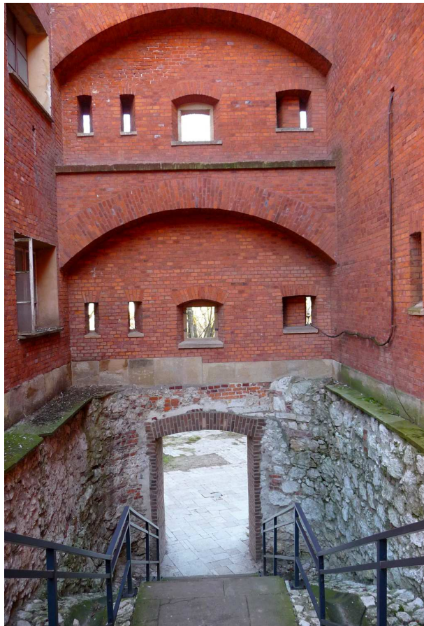
Fot. nr 250. Zejście do bastionu nr IV. (26.12.2024)
