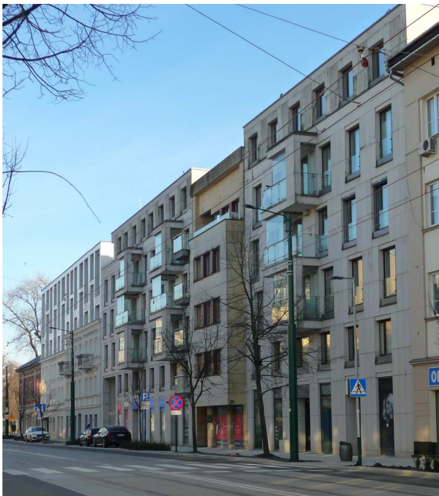
Fot. nr 160. Fragment zabudowy poniżej numeru 28. (26.12.2024)
