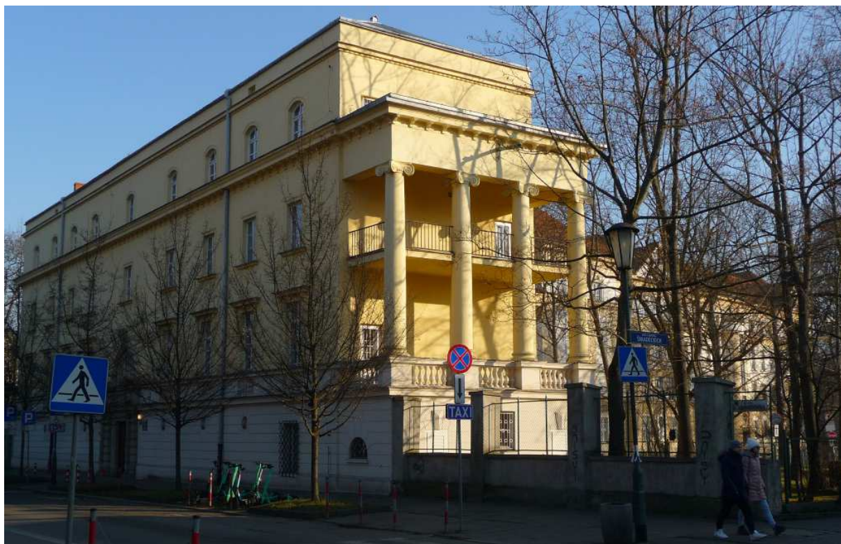
Fot. nr 76 (76-77). Stuletni budynek dawnej Szkoły Pielęgniarek pod nr 25. (29.12.2024)
