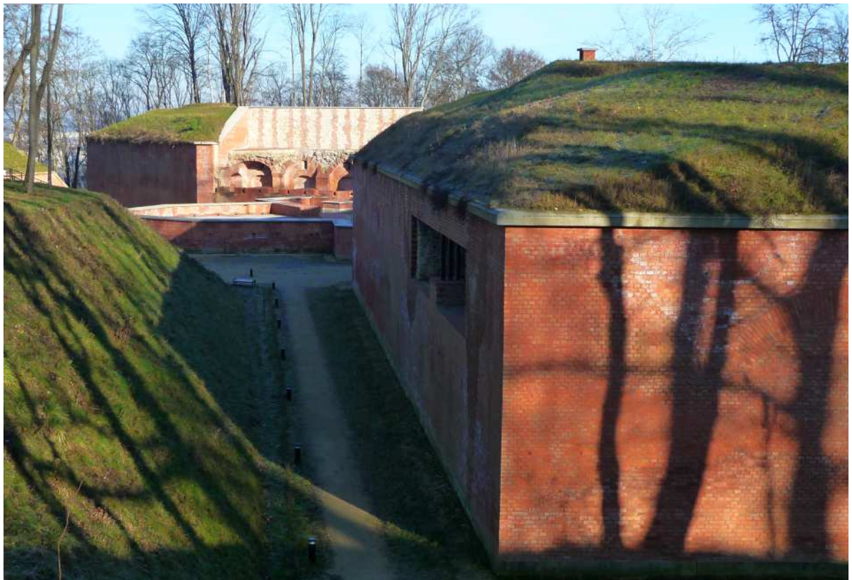
Fot. nr 235 (235-236). Zrekonstruowany mur oporowy bastionu nr II. (26.12.2024)
