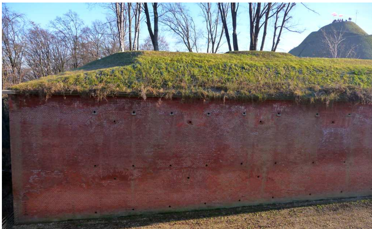
Fot. nr 242. Mur oporowy bastionu nr III. (26.12.2024)
