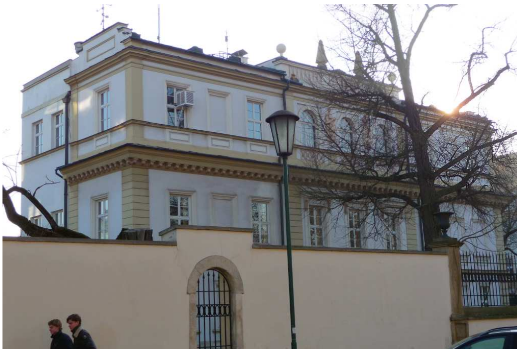
Fot. nr 70 (70-73). Gmach główny w wersji po przebudowie dokonanej po połowie wieku XIX. (29.12.2024)
