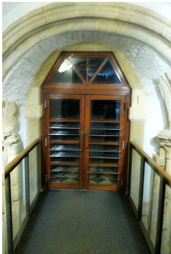
Fot. nr 177. Romański portal i drzwi wiodące do kościoła z przedsionka (26.12.2024)
