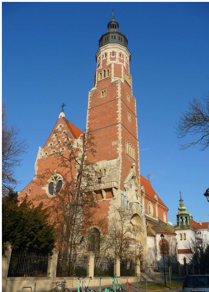
Fot. nr 96 (96-101). Kościół Jezuitów pod nr 26. (29.12.2024)
