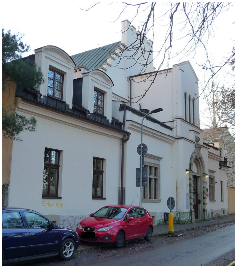
Fot. nr 289. Fasada budynku. (01.12.2024)
