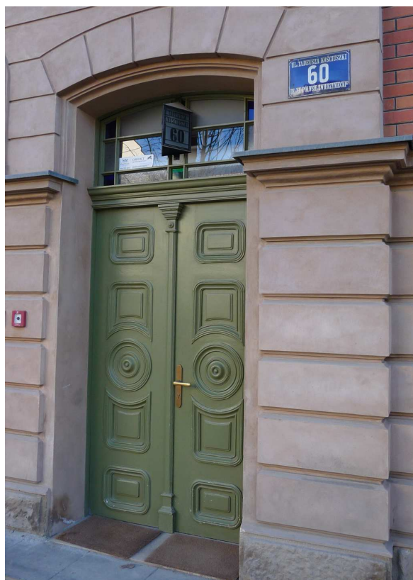
Fot. nr 169. Drzwi domu pod nr 60. (26.12.2024)
