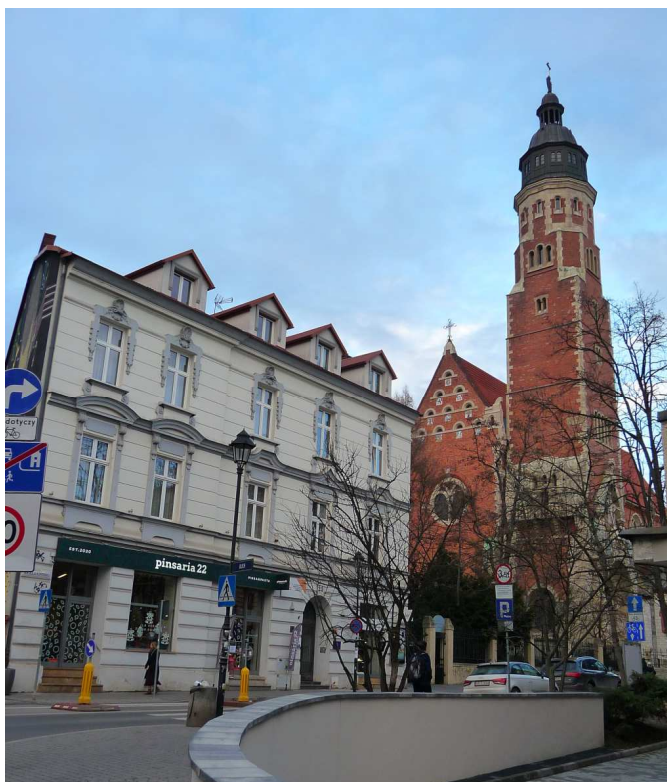
Fot. nr 97. Z odnowioną kamienicą pod nr 36 na pierwszym planie. (18.12.2024)
