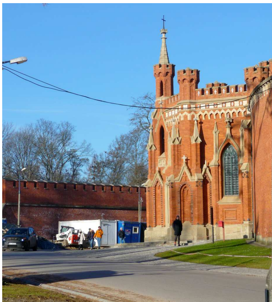
Fot. nr 243 (243-245). Częściowo zrekonstruowana ściana wewnętrzna (kurtyna II-III) pomiędzy bastionami II i III. (26.12.2024)
