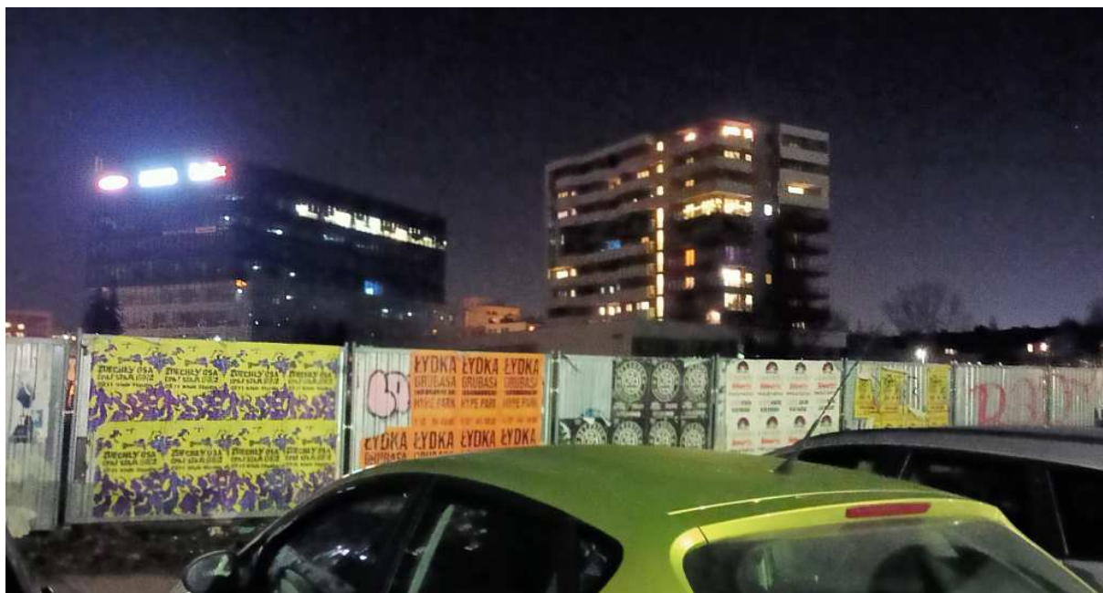
Fot. nr 147. Plac budowy na styku ulic: Grzegorzeckiej i Rogozińskiego. (31.12.2024)
