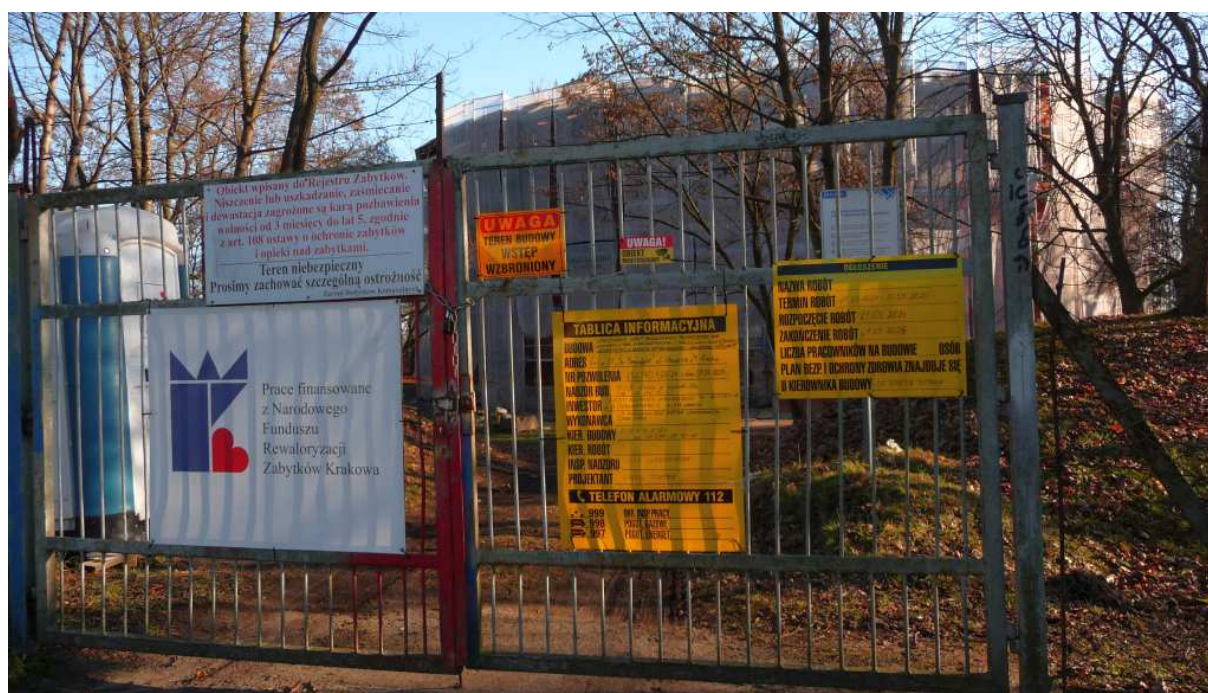
Fot. nr 310 (310-312). Fort św. Benedykt na etapie rewaloryzacji. (31.12.2024)
