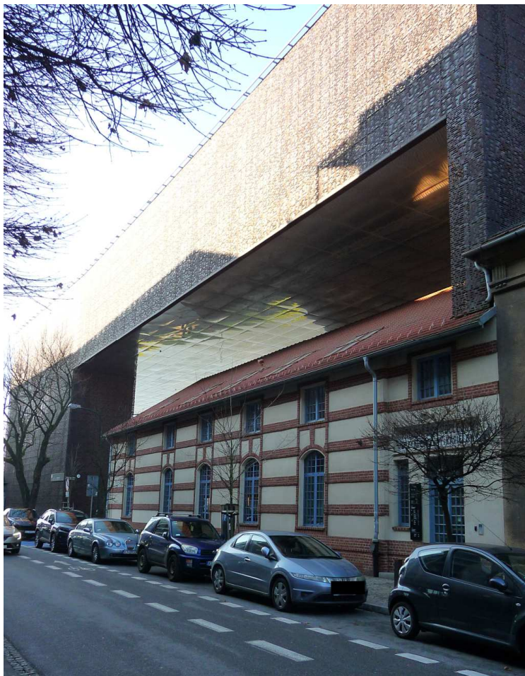
Fot. nr 277 (277-278). Budynek wybudowanej na początku XX wieku dawnej elektrowni podgórskiej przy ulicy Nadwiślańskiej 4, dziś stanowiący fragment Muzeum Kantora. (01.12.2024)
