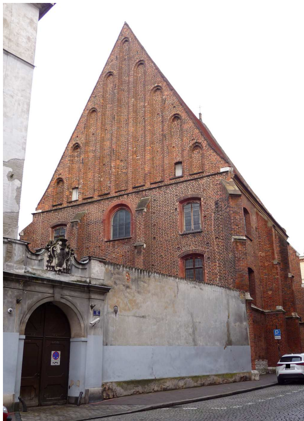
Fot. nr 57. Zachodnia ściana szczytowa kościoła św. Marka. (07.12.2024)
