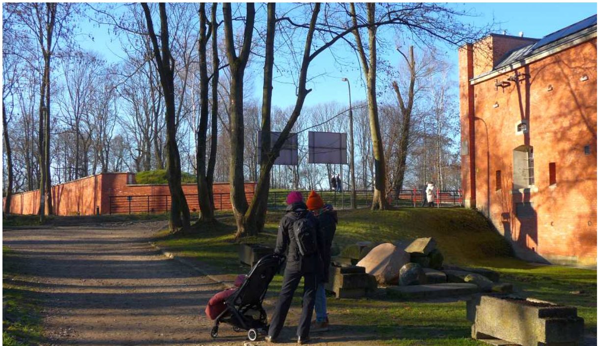
Fot. nr 221 (221-247). Przegląd zrewitalizowanej części zachodniej fortu. Z bastionem nr I w tle. (26.12.2024)
