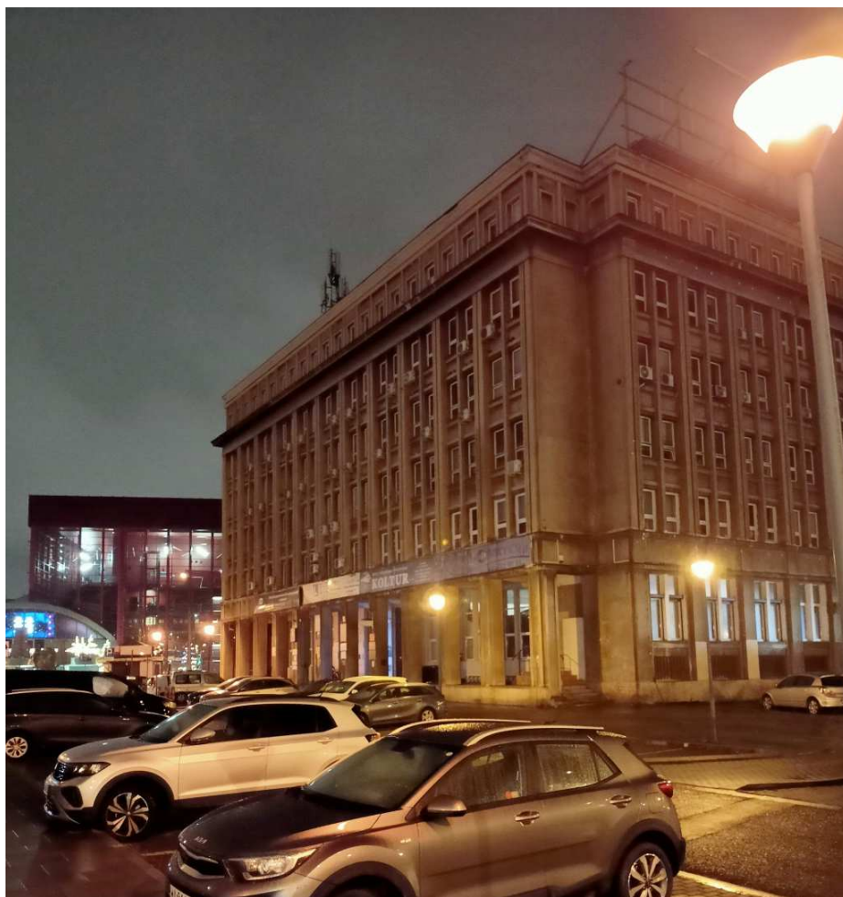
Fot. nr 64. Gmach PKP przy ulicy Borowickiej 1. (10.12.2024)
