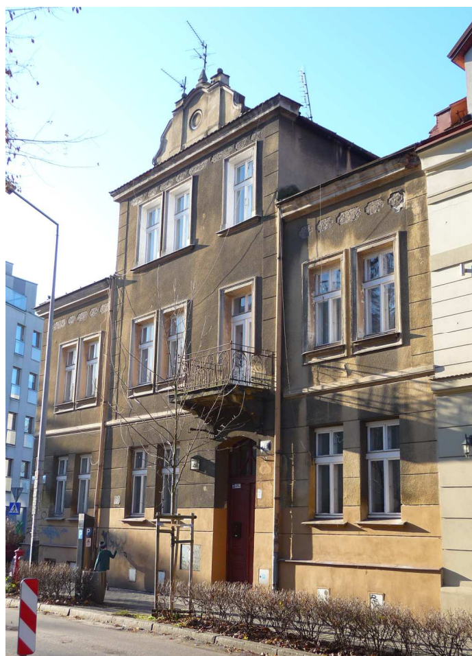
Fot. nr 298. Kamienica z początku XX wieku pod nr 28. (01.12.2024)
