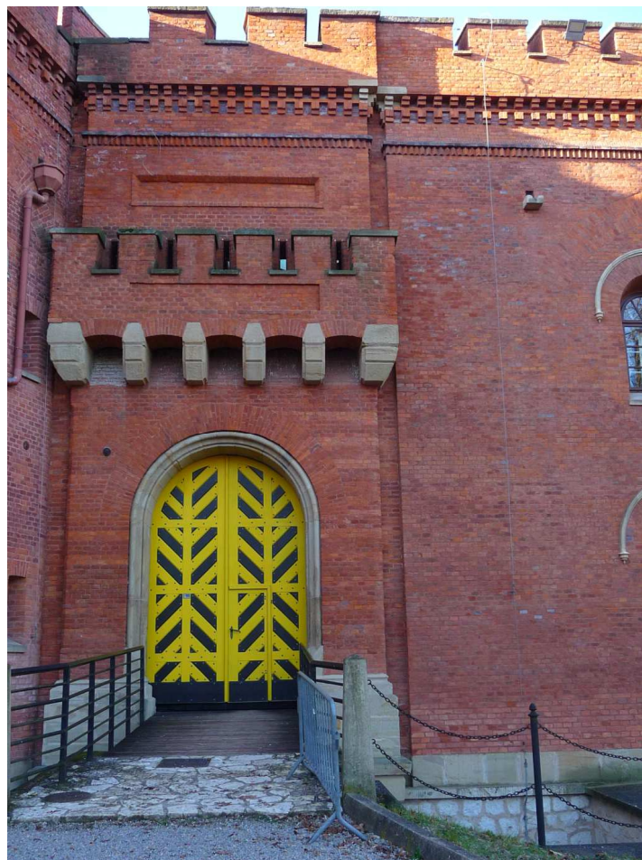
Fot. nr 258. Brama wjazdowa do kaponiery południowo-wschodniej. (26.12.2024)
