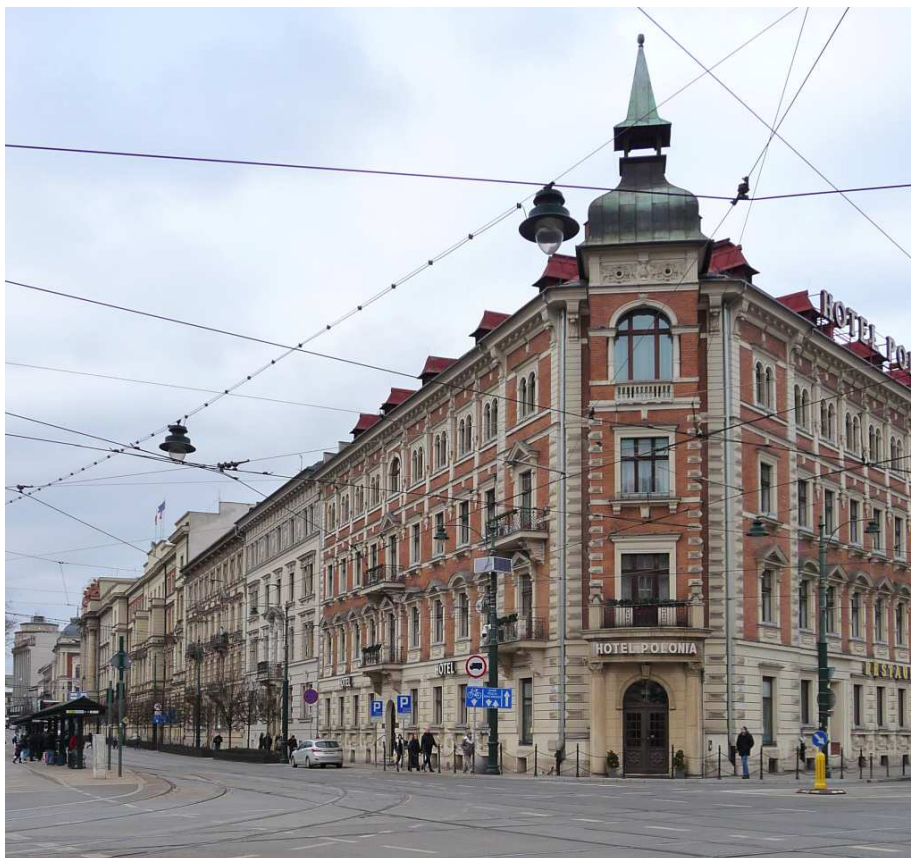
Fot. nr 60 (60-61). Na styku ulic: Basztowej i Pawiej. (24.12.2024)
