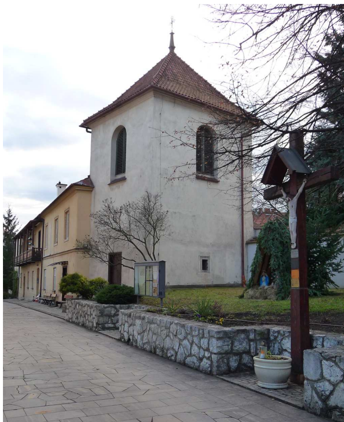
Fot. nr 118. Widok z ulicy Kopernika. (18.12.2024)
