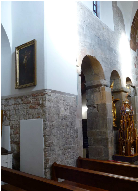
Fot. nr 198 (198-199). Romańskie empy w ścianach bocznych prezbiterium. Ściana północna. (26.12.2024)
