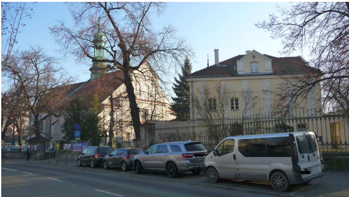
Fot. nr 120. Fragment dawnej oficyny dworskiej pod nr 7f. (29.12.2024)
