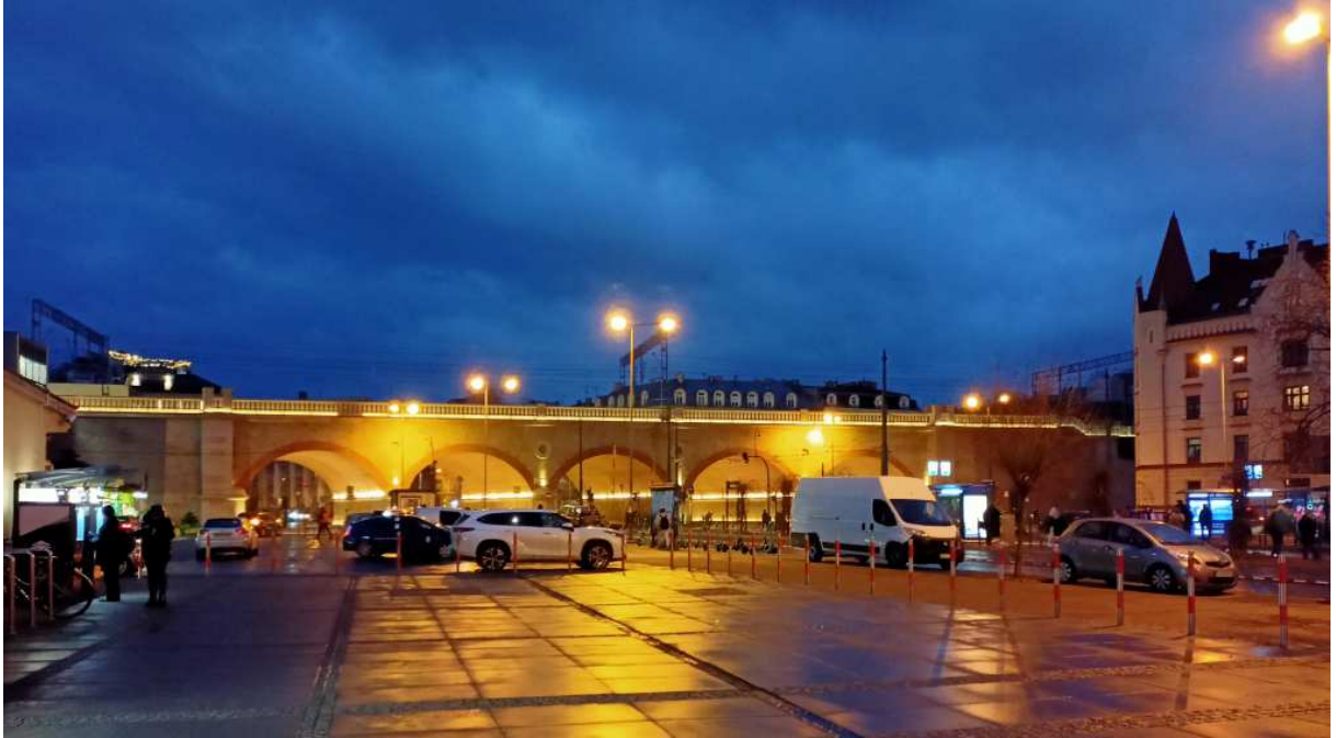
Fot. nr 154. Nowy wiadukt kolejowy. (17.12.2024)
