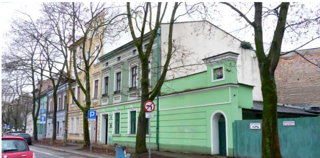
Fot. nr 268. Fragment zabudowy powyżej nr 29. (12.12.2024)
