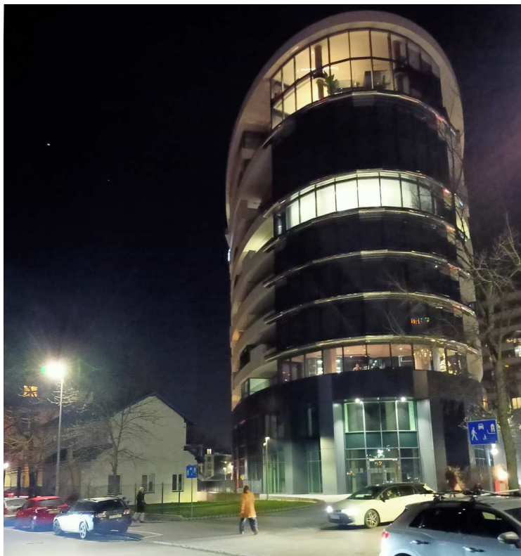
Fot. nr 150 (150-151). Nowa zabudowa mieszkalna na terenie dawnej fabryki Zieleniewskiego. (31.12.2024)
