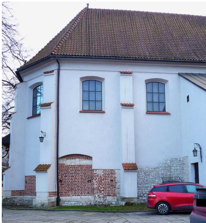
Fot. nr 110 (110-112). Prezbiterium i jego zabytkowe detale: romańskie (z kostki wapiennej) i gotyckie (w układzie ceglanej). (18.12.2024)
