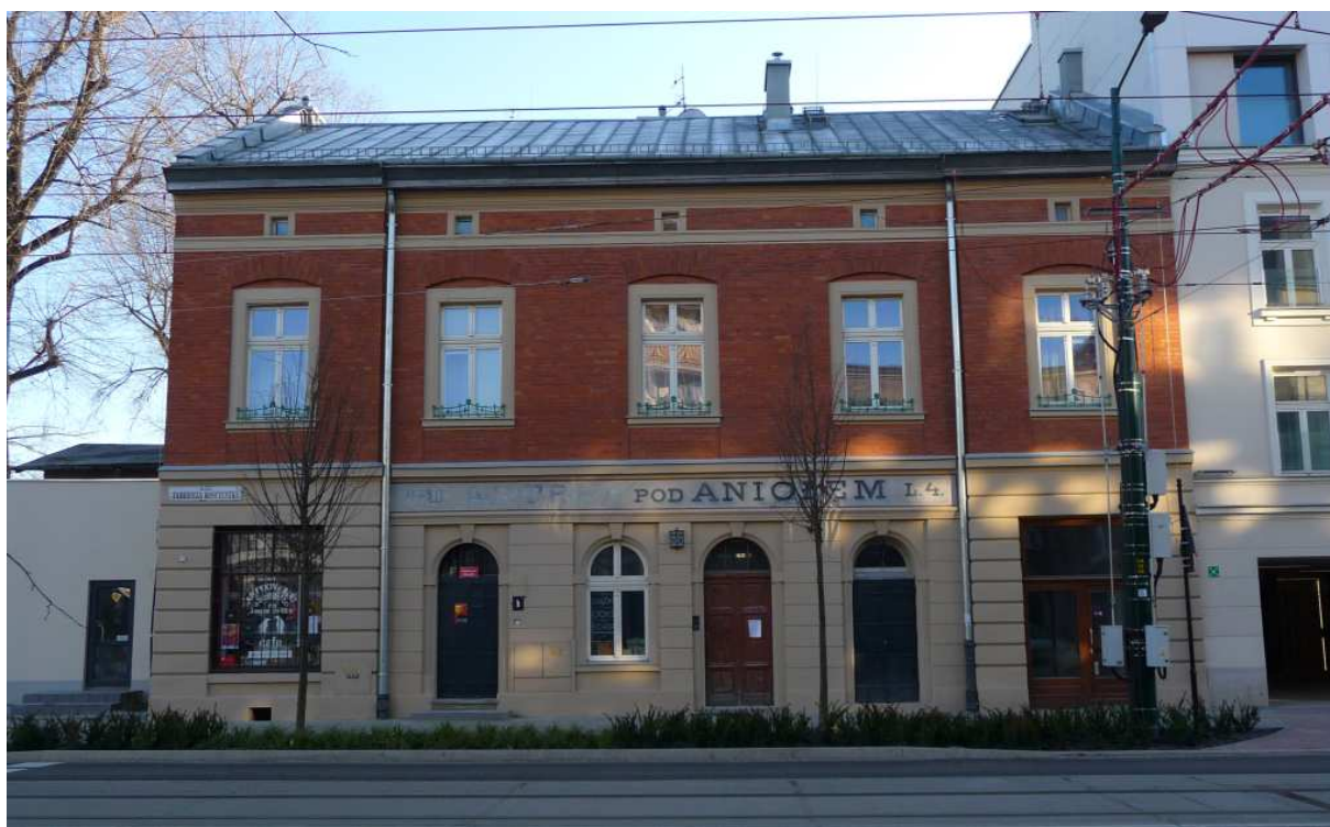
Fot. nr 158 (158-171). Wzdłuż ulicy Kościuszki. Dom pod nr 18. (26.12.2024)
