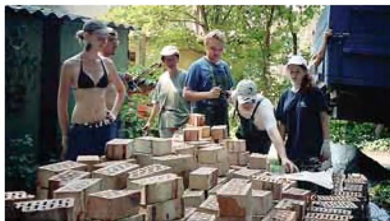
Przyjechała cegła do odbudowy muru cmentarnego
