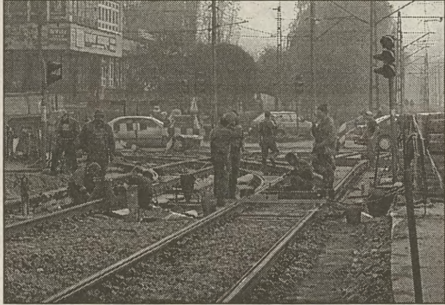
Prace na odcinku Wielicka — Dworcowa dobiegają końca. Już w czwartek nad ranem kursować będą tędy tramwaje. Fot. Joanna KOSTRZ
