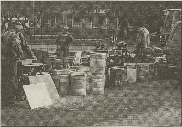
Na skrzyżowaniu ulic Limanowskiego i Na Zjeździe pracuje się niemal bez przerwy. Robót nie przerywa ani zapadnięcie zmroku, ani ulewny deszcz. Mimo to trudno przypuszczać, by zakończono je w terminie. Fot. Konrad PAWŁOWSKI
