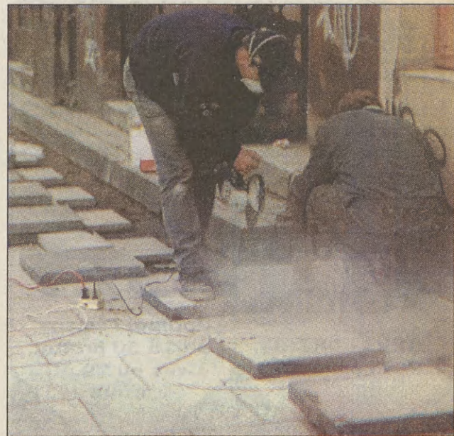
Oddano skrzyżowanie ul. Lubicz z Rakowicką. Trwają jeszcze prace przy układaniu chodników
