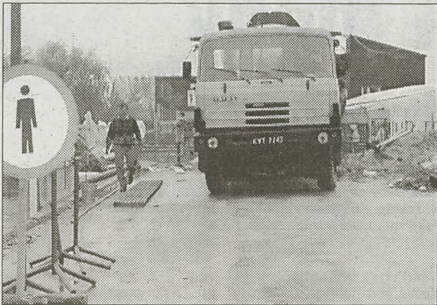
Na stopniu Dąbie, mimo deszczowej pogody, trwają prace. Najważniejsze było wylanie płyty, to jednak udało się zrobić. Fot. Joanna KOSTRZ
