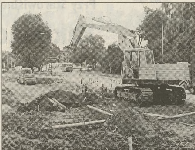
Trwają prace na skrzyżowaniu ul. Lublańskiej, Bora Komorowskiego i Dobrego Pasterza
