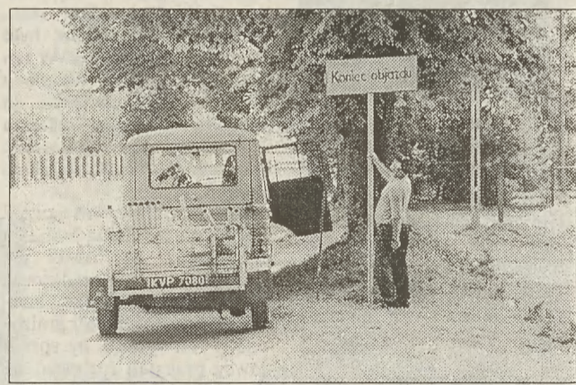
Wkopywanie tablic objazdowych w Pisarach informujących o zmienionych trasach na zamkniętym wiadukcie w Rudawie
