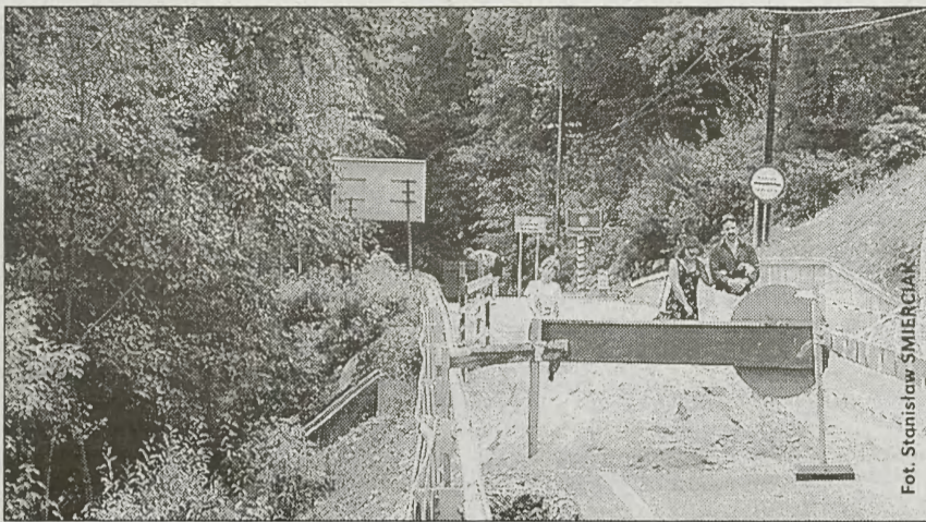
Na kilku odcinkach droga do granicy ograniczona została do połowy swej szerokości. Urwiska opadają tam 200 m ku Popradowi
