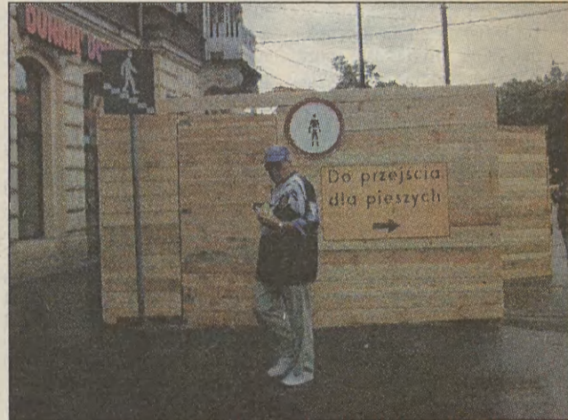
Na razie ograniczono ruch pieszych. Teren, gdzie będą wykonywane prace został zabezpieczony. Winda przewiezie pierwszych pasażerów na początku 2000 roku
