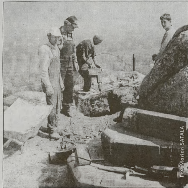
Na skutek ulewnych deszczów przechylił się Kopiec Kościuszki co groziło stoczeniem się pamiątkowego, 4 tonowego granitowego głazu ku czci Tadeusza Kościuszki. Głaz zdjęto ze szczytu przy pomocy śmigłowca, czeka teraz na wyremontowanie kopca i ponowne ustawienie go na szczycie
