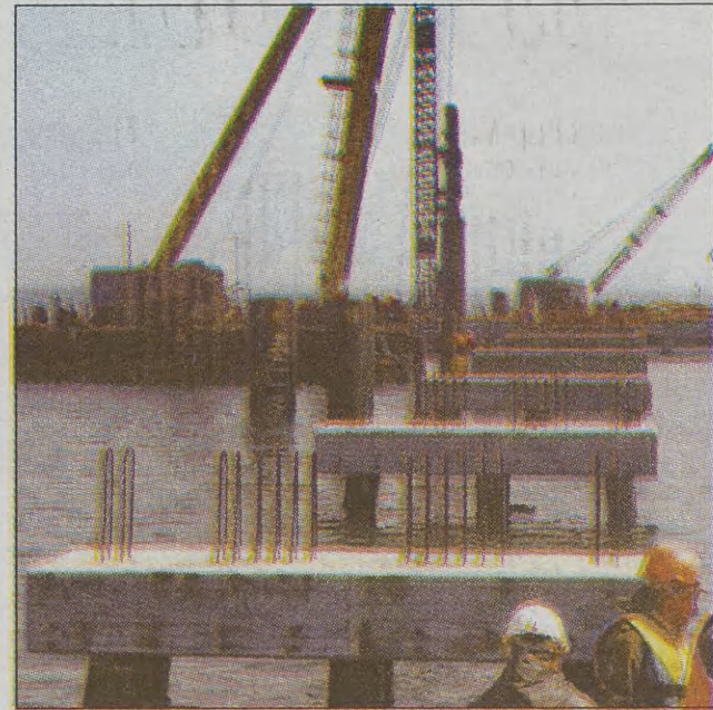
Brytyjski Sunley z Krakowa chętnie buduje nad morzem. Tak powstał terminal dla Norwegów w Porcie Północnym.
