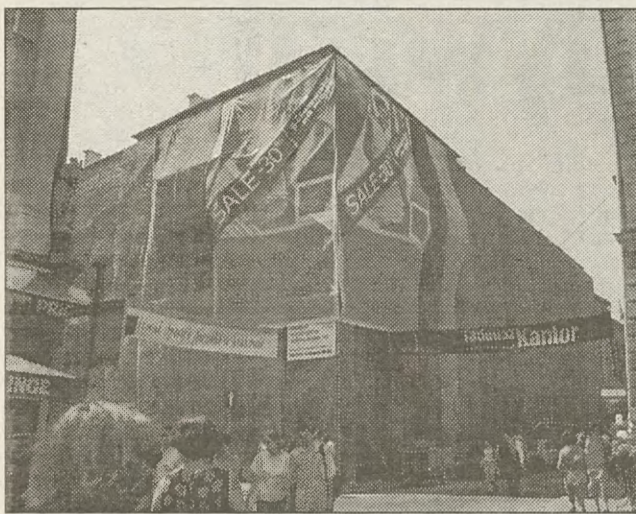
Trwa remont elewacji budynku DT Centrum Krakus na rogu ulic św. Anny i Wiśniej. Chodnik został zwyżony. Przejżdżającym kierowcom koło Rynku Głównego (oczywiście tym, którzy mają stosowne pozwolenia) radzimy, by uważali na pieszych idących całą szerokością ulicy.
