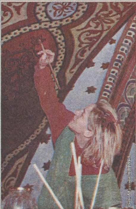
Katarzyna Bielawska odtwarza detale na frontowej ścianie synagogi Tempel
