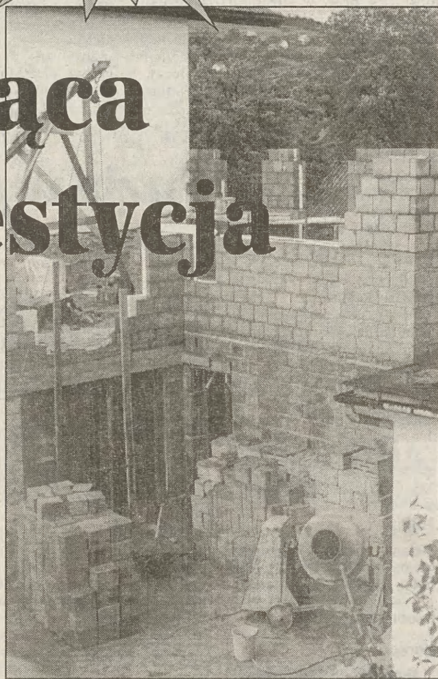
Właścicielowi powstającego budynku trudno będzie znaleźć miejsce na szambo
