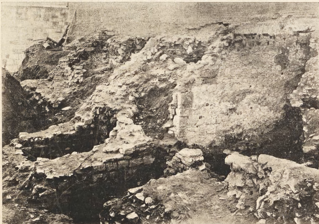
Fig. 10. Reszty wieży romańskiej przy sali o 24 słupach.
