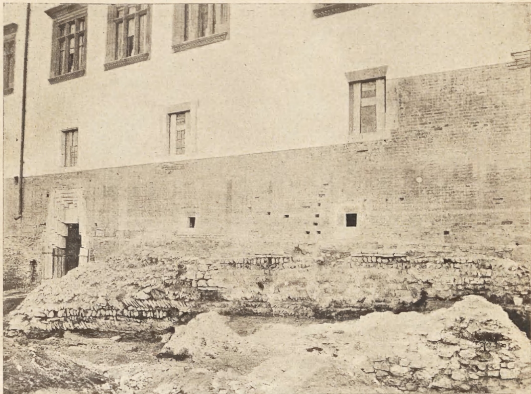
Fig. 6. Mur fundamentowy sali o 24 słupach.
