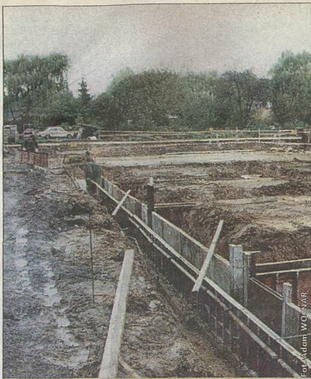
Przy ul. Ulanów rozpoczęto budowę Domu Pomocy Społecznej. Inwestorem jest Fundacja Dla Dzieci Głęboko Upośledzonych. Wykonawcą — „Budostal2”. Dom ma być nowoczesnym ośrodkiem, w którym przewidziano miejsce m.in. na salę gimnastyczną z prawdziwego zdarzenia i pełnowymiarowy basen. (AW)
