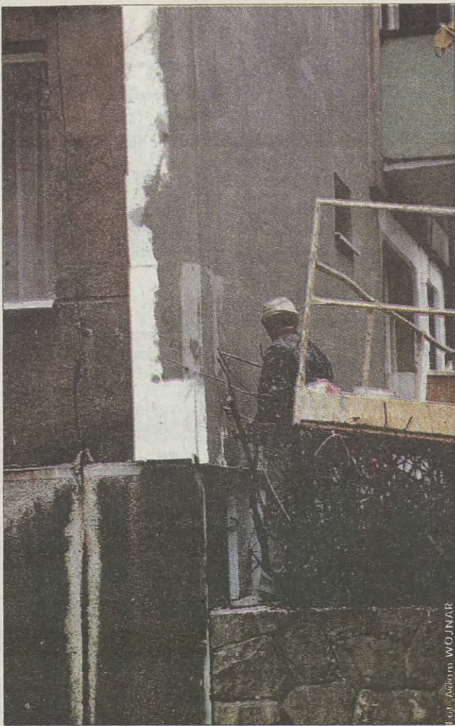
Dawne partactwa trzeba dziś naprawić. Przy ul. Ułanów ocieplane są bloki. Technologia – płyty styropianowe. Ponoć dobrze ocieplają i będą tak skuteczne przynajmniej kilkanaście lat... (AW)
