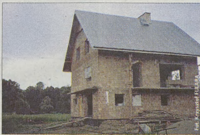
W stanie surowym dom stanął już w październiku
