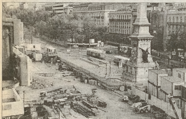
Ubiegłoroczne lato w Lizbonie było okresem przebudowy
