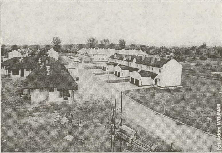
Miało być jak w bajce — a jest rozgrzebany teren i cuchnące szambo przed oknami
