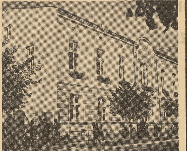
Szkoła Podstawowa nr 9 w Tomaszowie Mazowieckim otrzymała piękną elewację w kolorach pastelowych. Budynki zostały zbudowane przed 90 laty i może śmiało rywalizować z niejedną szkołą obecnie zbudowaną. Fot. Cz. Górski
