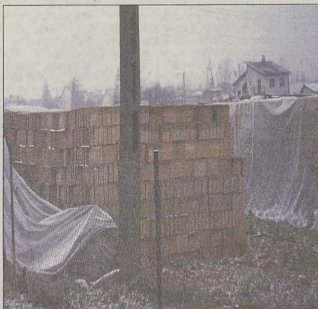
Materiały na budowę warto zacząć szybko gromadzić. Najlepiej jednak kupować je w roku, w którym uzyskamy urzędowe pozwolenie na budowę Fot. Andrzej ZARYCH
