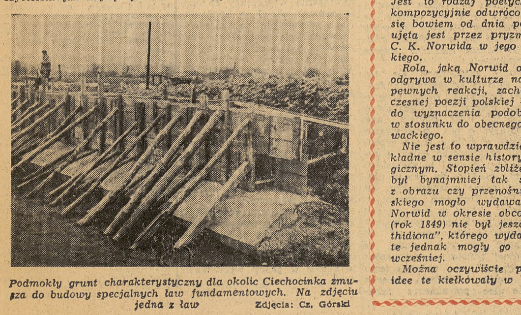
Podmokły grunt charakterystyczny dla okolic Ciechocinka wymaga do budowy specjalnych ław fundamentowych. Na zdjęciu jedna z ław
