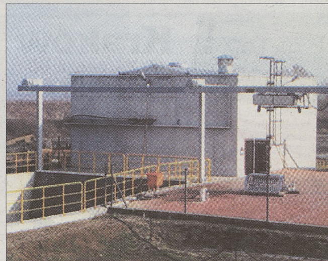
Elektrownia przy stopniu Łączany (wyróżnienie)
