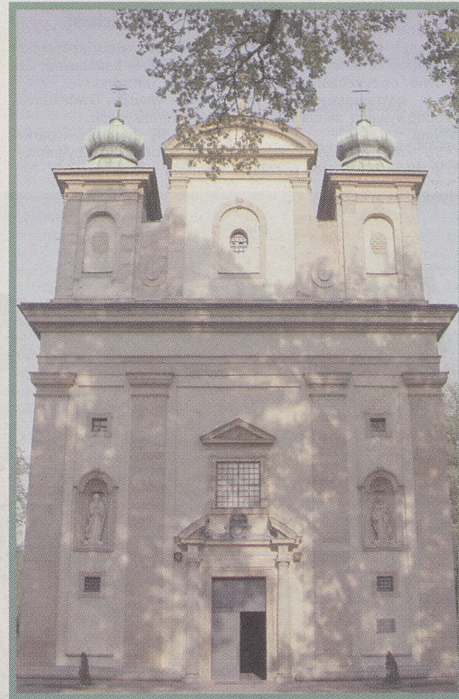
Kościół pw. Wniebowzięcia Najświętszej Marii Panny fot. Paweł Bielak
