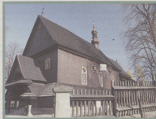
Kościół pw. Wszystkich Świętych w Sobolowie – wzniesiony na miejscu poprzedniej świątyni pod koniec XVI wieku. To jeden z wielu podobnie pięknych obiektów na ziemi bocheńskiej. Sobolowska perła architektury sakralnej błyszczy również w nocy dzięki zamontowanej iluminacji.
