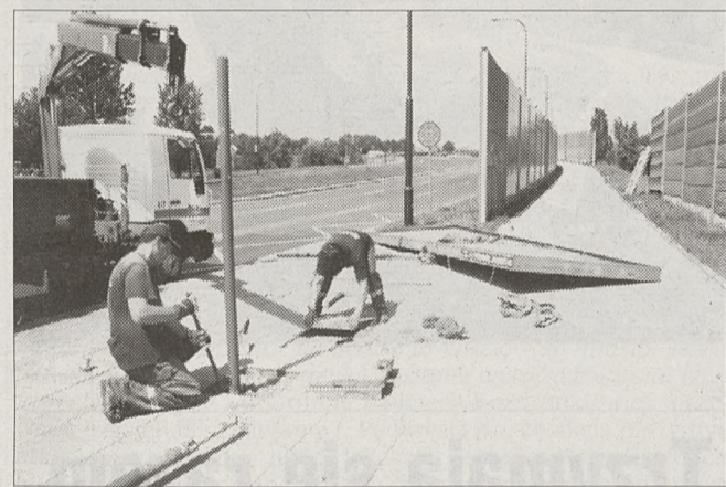
Przystanek autobusowy przy ul. Stella-Sawickiego
