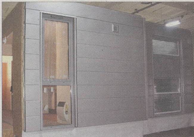
Moduł przestrzenny w trakcie montażu
