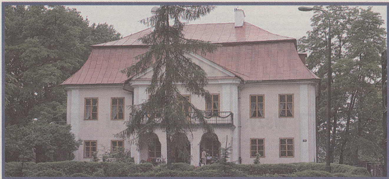
Dwór przy ul. Podedworze
