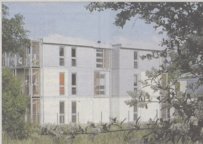
Dom w osiedlu Mała Góra
