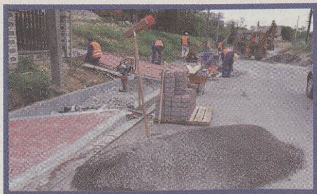
Modernizacja ulicy Kuryłowicza
