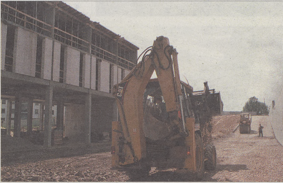
Budowa Centrum Bezpieczeństwa przy ul. Strzelców
