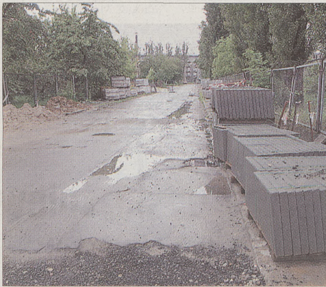
W związku z włączeniem ul. Śliwkowej do al. Pokoju zagrodzony zewnętrzny pas ruchu w stronę ronda Czyżyńskiego (na ok. 20 metrach); prace do 30 czerwca Fot. Anna Kaczmarz
