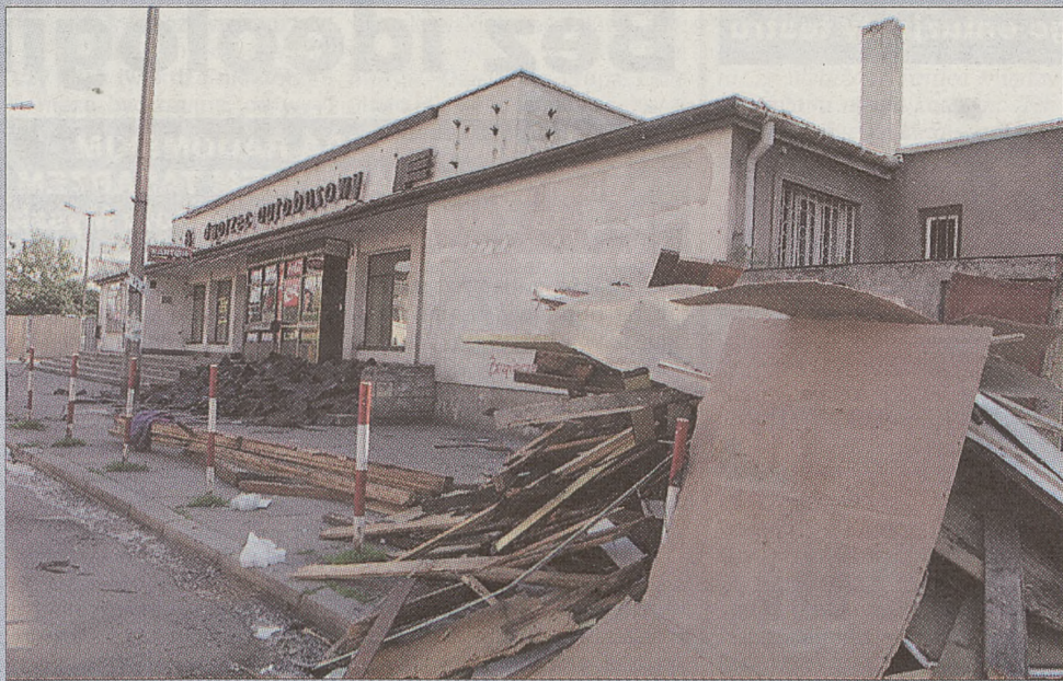
Na miejscu starego dworca ma być budowane centrum handlowo-usługowe
