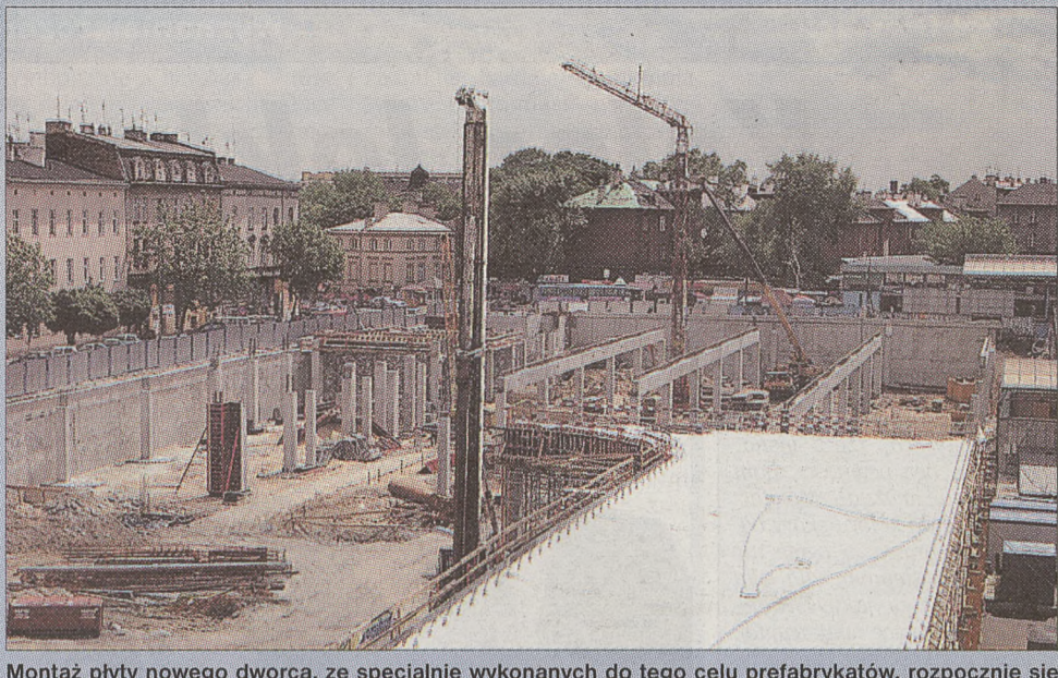
Montaż płyty nowego dworca, ze specjalnie wykonanych do tego celu prefabrykatów, rozpocznie się w poniedziałek
