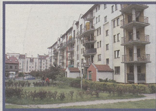
Młodym mieszkańcom os. Żabiniec przyda się wkrótce ogródek jordanowski Fot. Piotr Kędziarski
