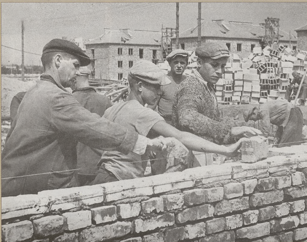
Trójka murarska przy pracy, 1951 r.
