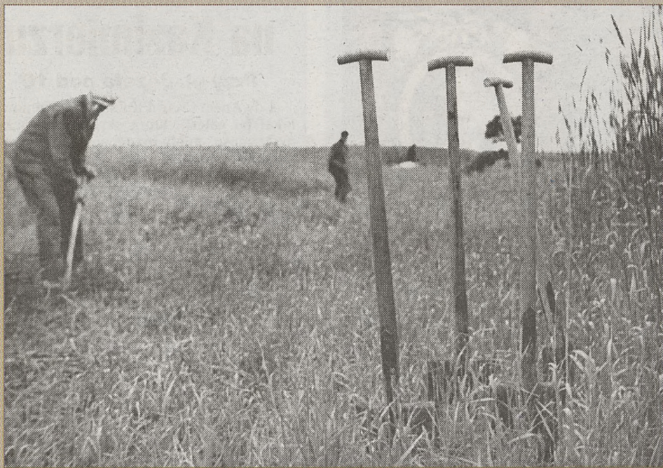
Wbicie pierwszych łopat pod budowę Nowej Huty, Mogiła, czerwiec 1949 r. Fot. z archiwum „Głosu – Tygodnika Nowohuckiego”
